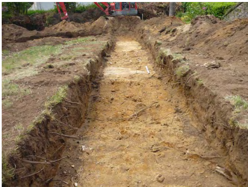
Fig. 8 – Tranchée 2 vue vers l'ouest. (© O. Ezanno)
