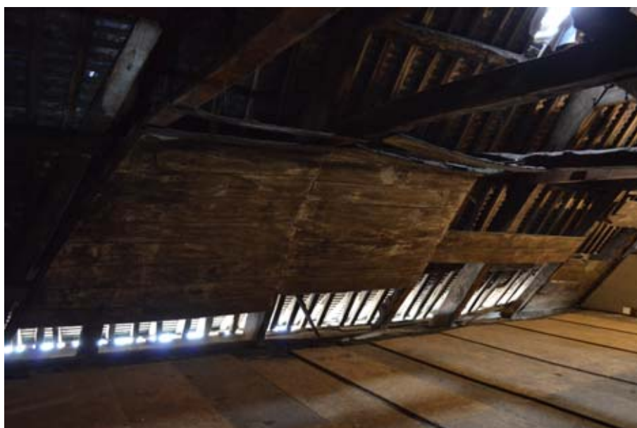
Fig.54 La voûte sur la croupe nord © Elen Esnault, Inrap
