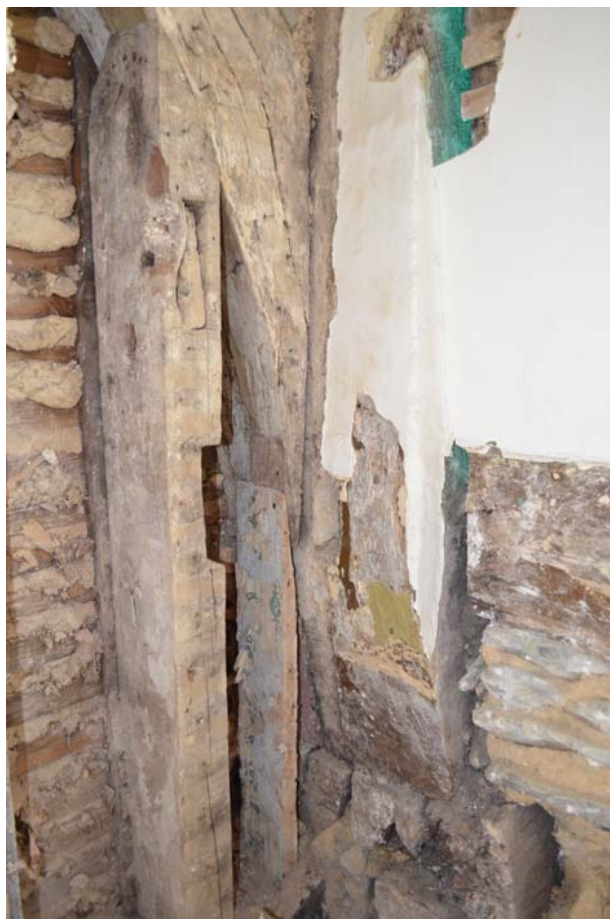
Fig.40 Le poteau 5 délardé pour l'intégration de la cerce © Rozenn Battais, Inrap
