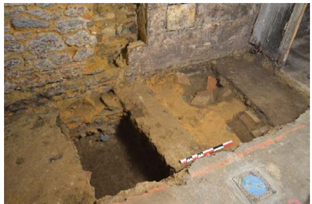
Fig.73 La tranchée de récupération 210 © Marie Millet, Inrap
