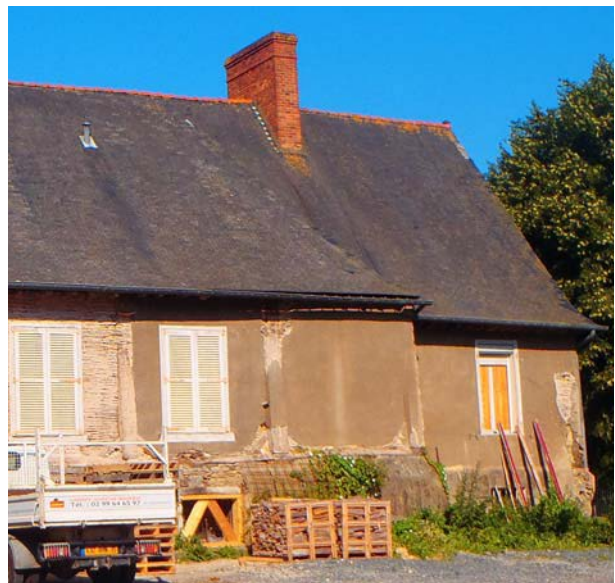
Fig.150 L'enduit ciment sur le mur 16 © Elen Esnault, Inrap
