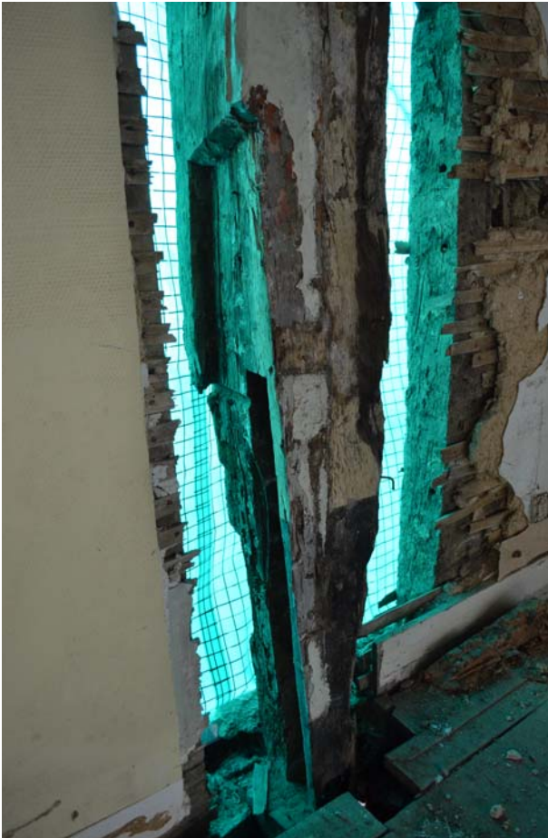
Fig.17 La partie basse du poteau 102 délardée © Elen Esnault, Inrap
