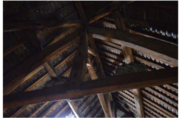
Fig.51 Les mortaises orphelines orphelines de la croupe © Elen Esnault, Inrap
