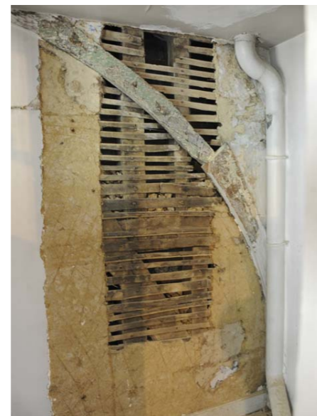
Fig.127 Le sondage pratiqué sur le mur pignon de la chapelle latérale © Hervé Paitier, Inrap
