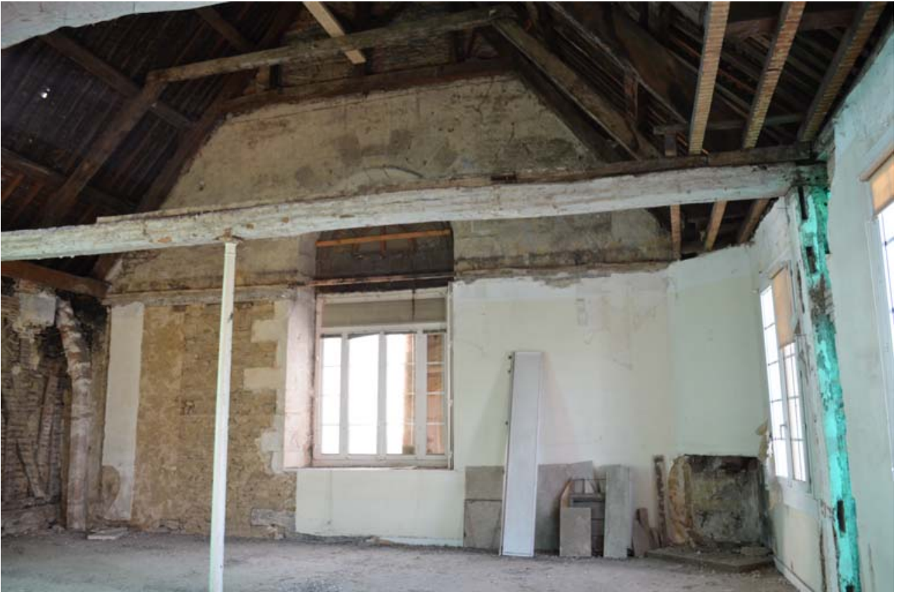
Fig.141 L'enduit du pignon sud © Elen Esnault, Inrap
