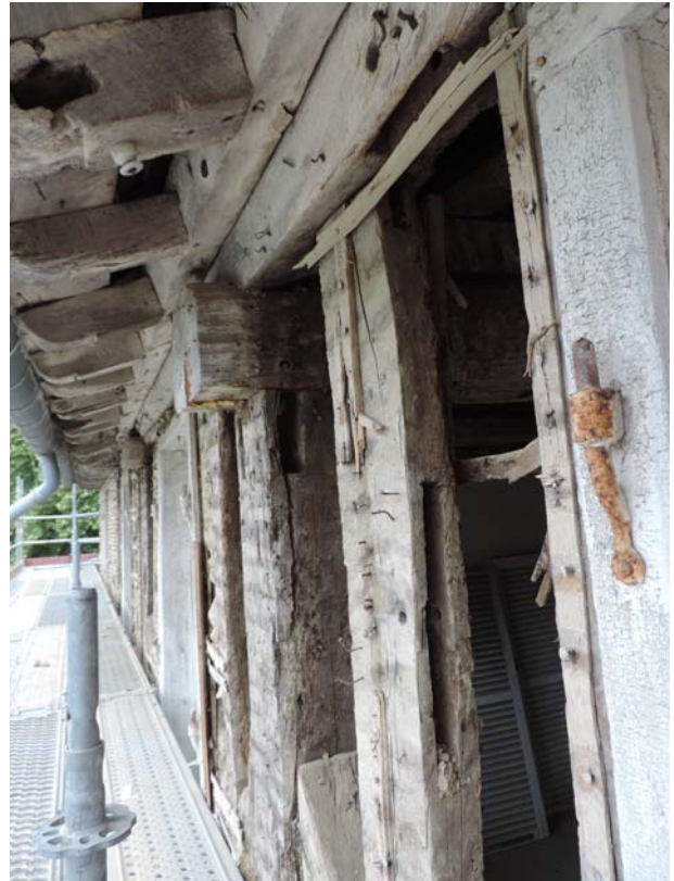
Fig.18 Le doublement de la panne sablière et les corbelets © Rozenn Battais, Inrap
