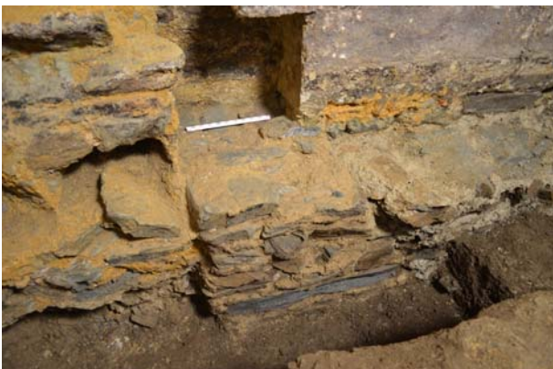
Fig.72 Le plot 248 et la fondation du mur de brique © Marie Millet, Inrap
