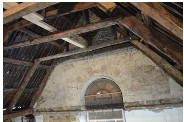
Fig.52 La partie sud de la charpente © Elen Esnault, Inrap
