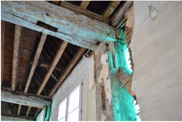
Fig.10 L'assemblage poteau-entrait-sablère © Elen Esnault, Inrap
