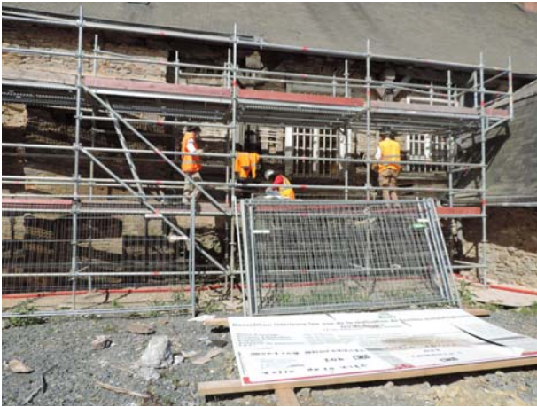
Fig.2 L'échafaudage extérieur © Elen Esnault, Inrap
