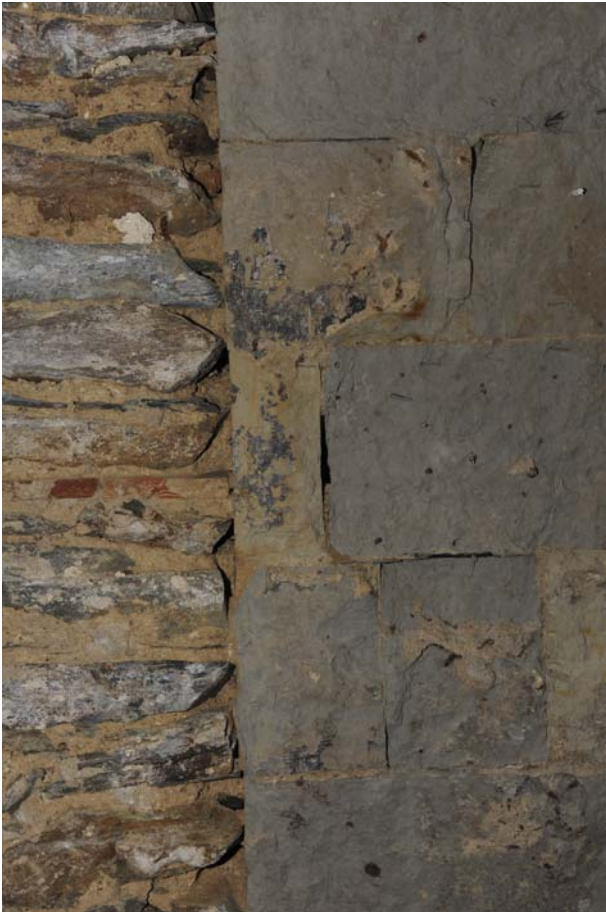
Fig. 29 L'enduit de faux-appareil 286 © Hervé Paitier, Inrap
