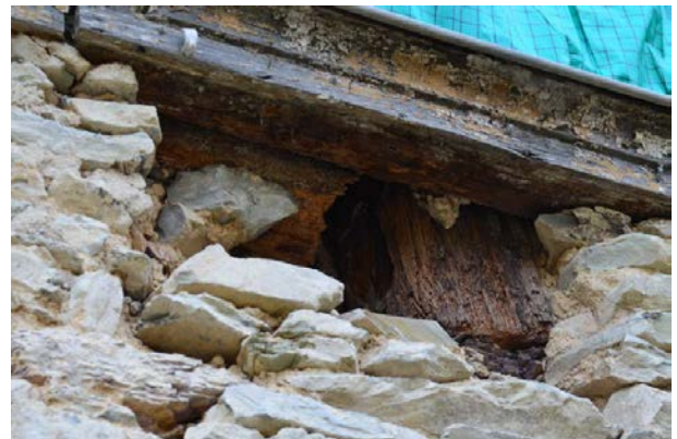
Fig.13 La base des poteaux ennoyées dans la maçonnerie 112/181 © Elen Esnault, Inrap
