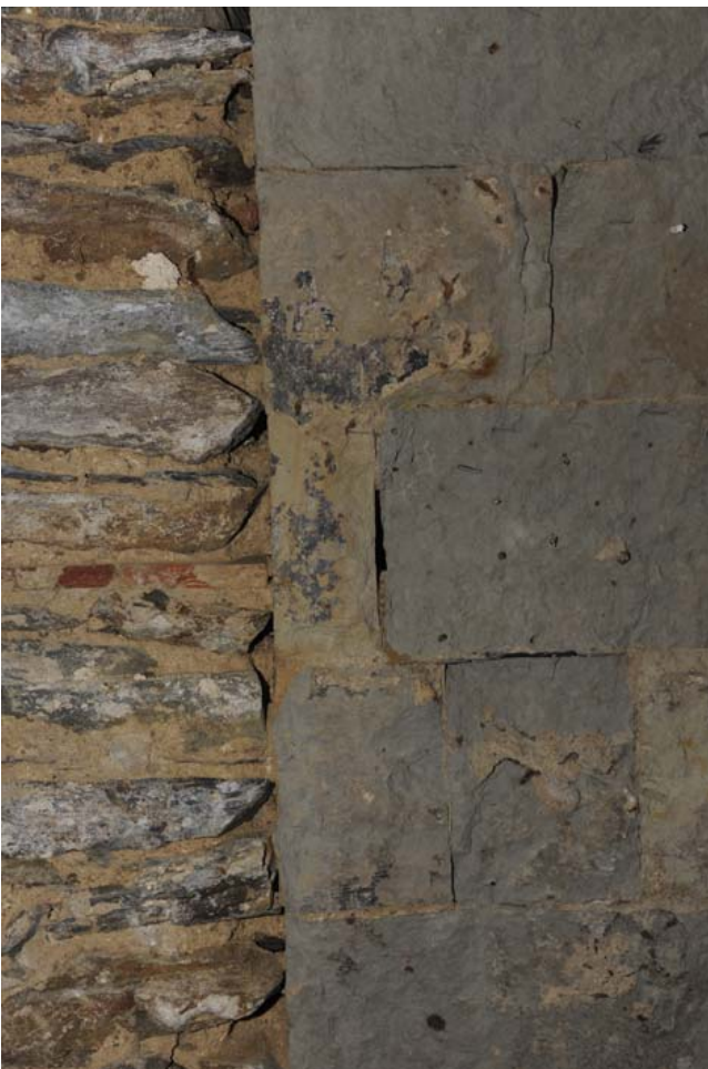
Fig.142 Le faux-appareil © Hervé Paitier, Inrap
