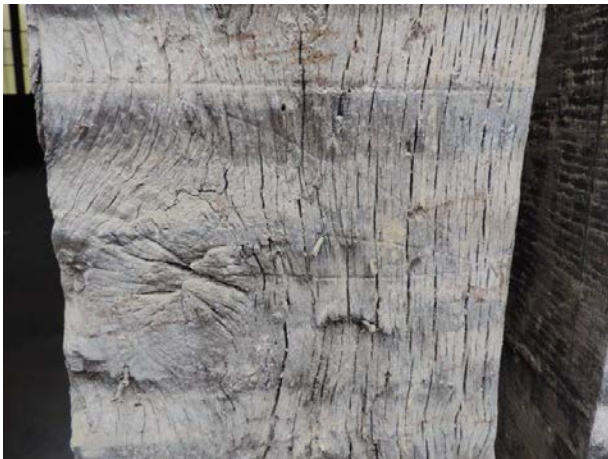
Fig.11 Les marques de charpentier © Marie-Laure Thierry, Inrap
