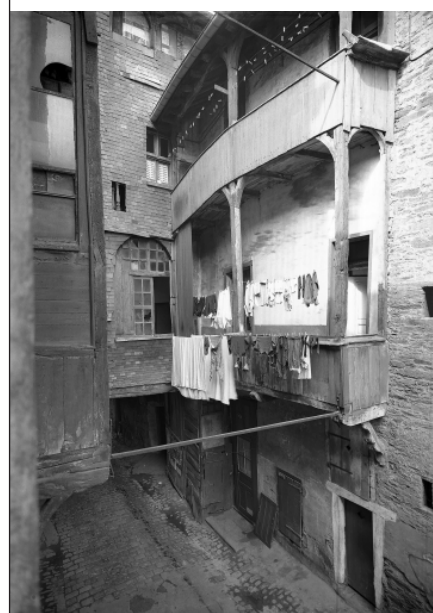
Fig.90 Quelques exemples de galerie : l'ancien couvent des carmélites à Rennes (35), le manoir de Launay-Bazouin à Noyal-sur-Vilaine (35), la ferme du 6 rue Notre-Dame à Chartres de Bretagne (35)
