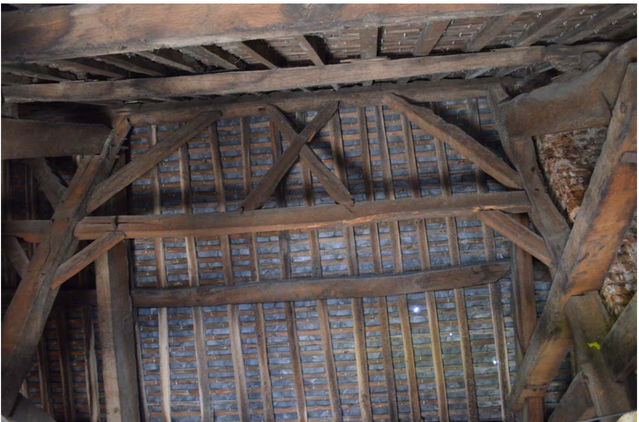
Fig.44 Vue générale de la charpente © Elen Esnault, Inrap
