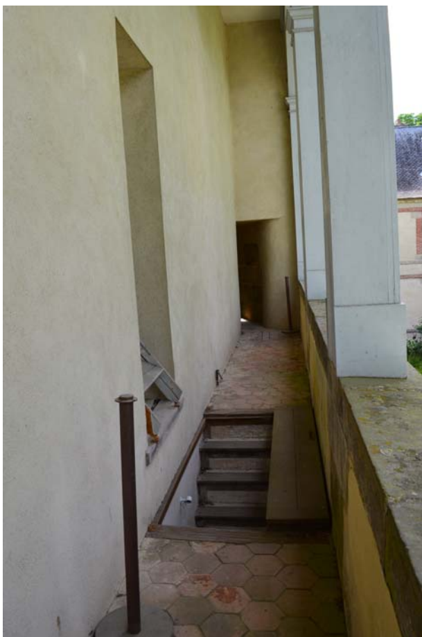
Fig.92 L'escalier de Fontainebleau © Elen Esnault, Inrap
