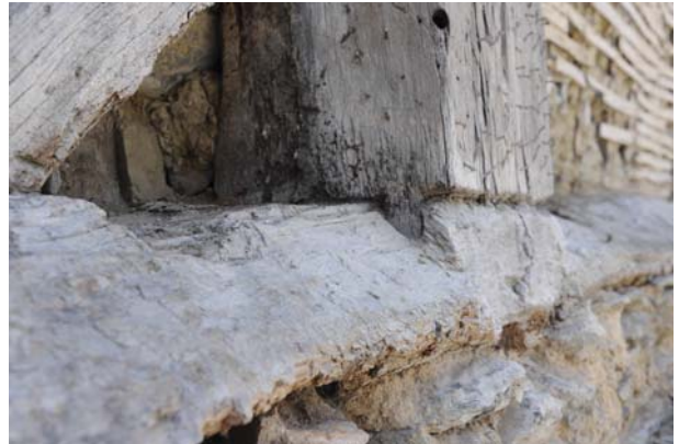
Fig. 23 La sablière en forme de larmier © Hervé Paitier, Inrap
