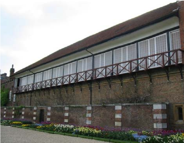
Fig.114 La galerie d'Hampton Court, Angleterre © auteur inconnu
