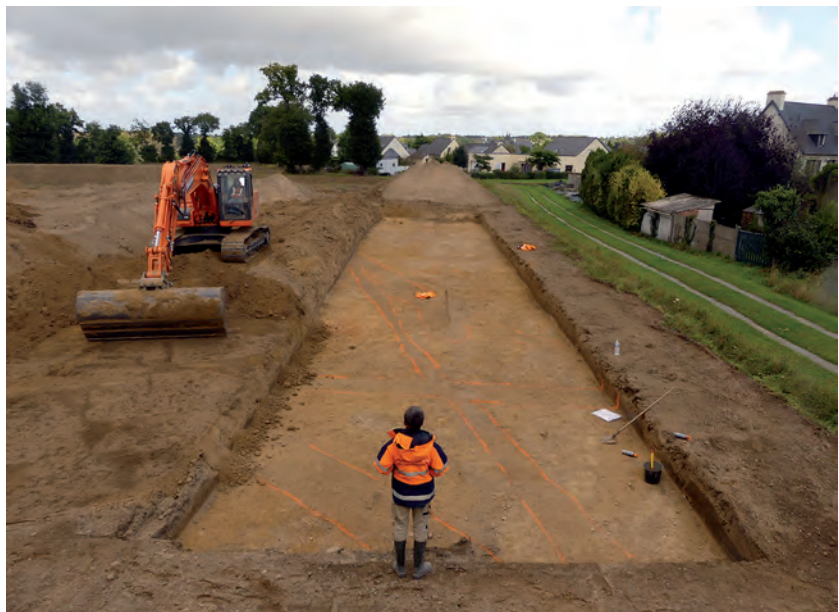
Fig. 13 Décapage mécanique de la vignette nord. © Nicolas Ménez
