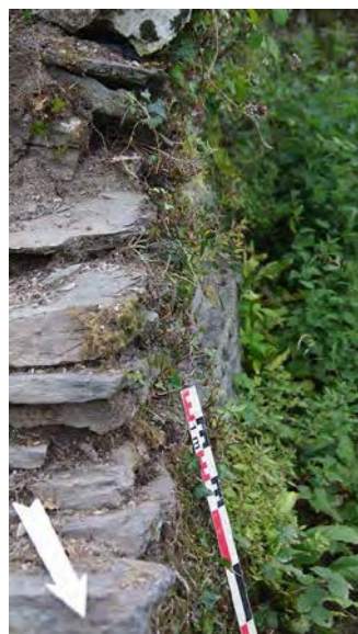
Fig. 76 : Parement nord de la courtine M50 : détail de l'un des retraits d'aplombs. Vue de l'est. Cl. R. Pérennec 2015, CD29/ Mission Archéologie.
