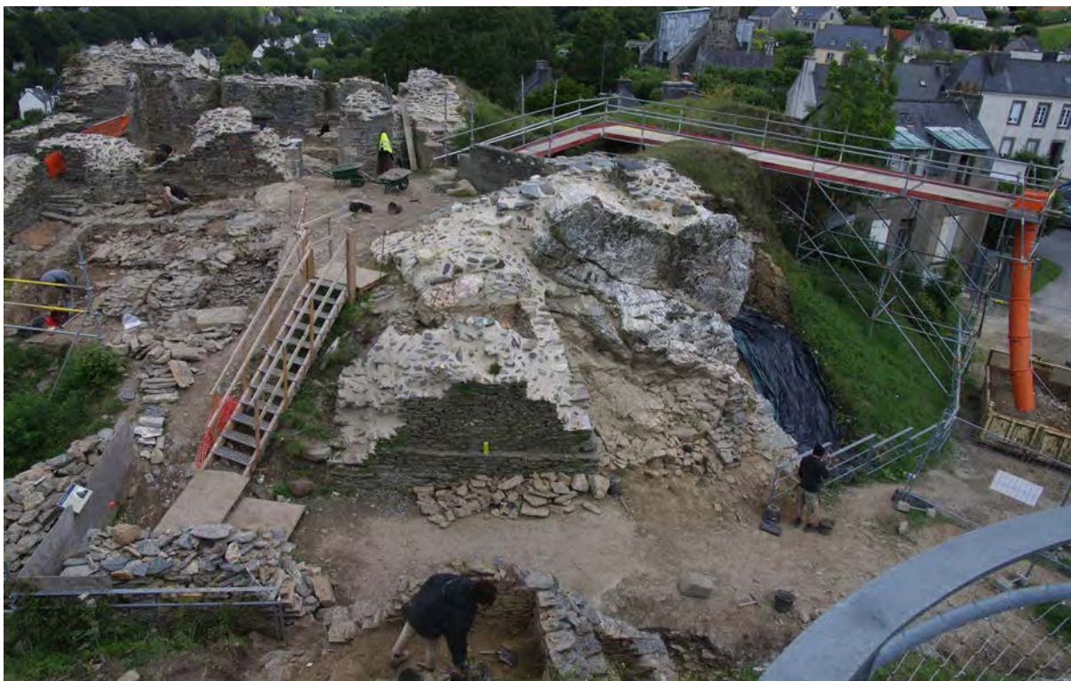
Fig. 3 : Vue générale, en cours de fouille, du dispositif d'évacuation des déblais (cl. R. Pérennec, CD29/Mission Archéologie).
