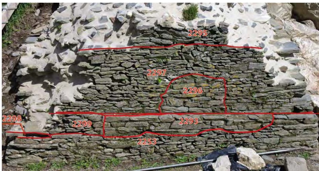
Fig. 63 : Aperçu des reprises de maçonneries sur le massif M45. CD29/Mission Archéologie.
