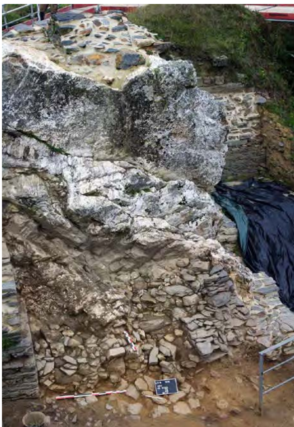
Fig. 48 : Au pied et à l'ouest de la paroi rocheuse, structures annexes et partie occidentale US 2269 de la tour M35/M41 mise au jour au sommet du rocher en 2013, sur les faces sud et est. Cl. R. Pérennec, 2015, CD29/ Mission Archéologie.
