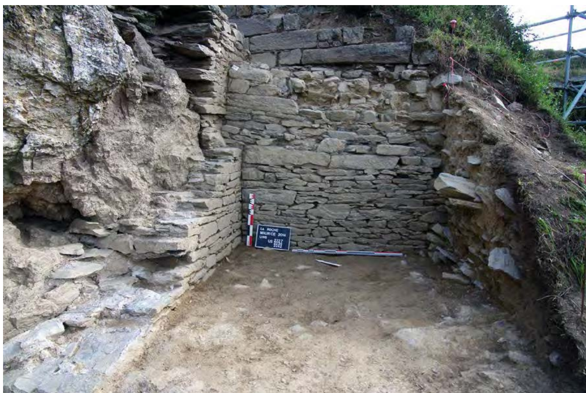
Fig. 92 : L'appareil de pierres de taille de la tour d'artillerie, reposant sur des ouvrages antérieurs en saillie de la courtine. À droite, le talutage d'argile qui protège la partie basse des maçonneries. Vue de l'ouest. Cl. R. Pérennec 2014, CD29/ Mission Archéologie.
