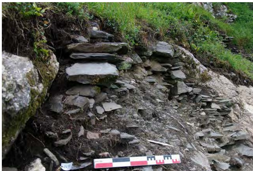
Fig. 84 : Coupe du mur 3016. A droite en contrebas, mur antérieur 3015. Vue prise de l'est. Cl. R. Pérennec 2015, CD29/ Mission Archéologie.
