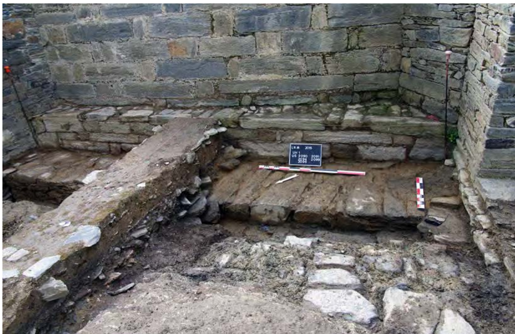
Fig. 35 : Les fondations en gradins de la tour d'artillerie : US 2094 et 2099. Vue du nord-ouest. Cl. R. Pérennec, 2015, CD29/ Mission Archéologie.
