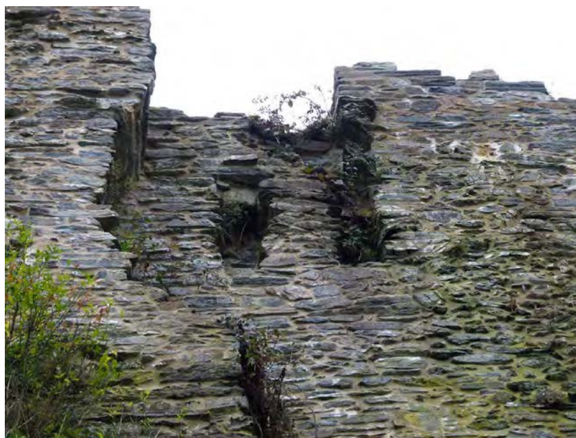
Fig. 43 : L'implantation des latrines sur le parement nord de la courtine M32-M44. A droite, ancrage de la latrine US 2027 (saignées US 2054). A gauche, implantation de la latrine US 2024 : arasement partiel de l'angle de la courtine M32, parement US 2025 (ancrage), supportant une réfection de la courtine, US 2037 Cl. R. Pérennec, CD29/Mission Archéologie.
