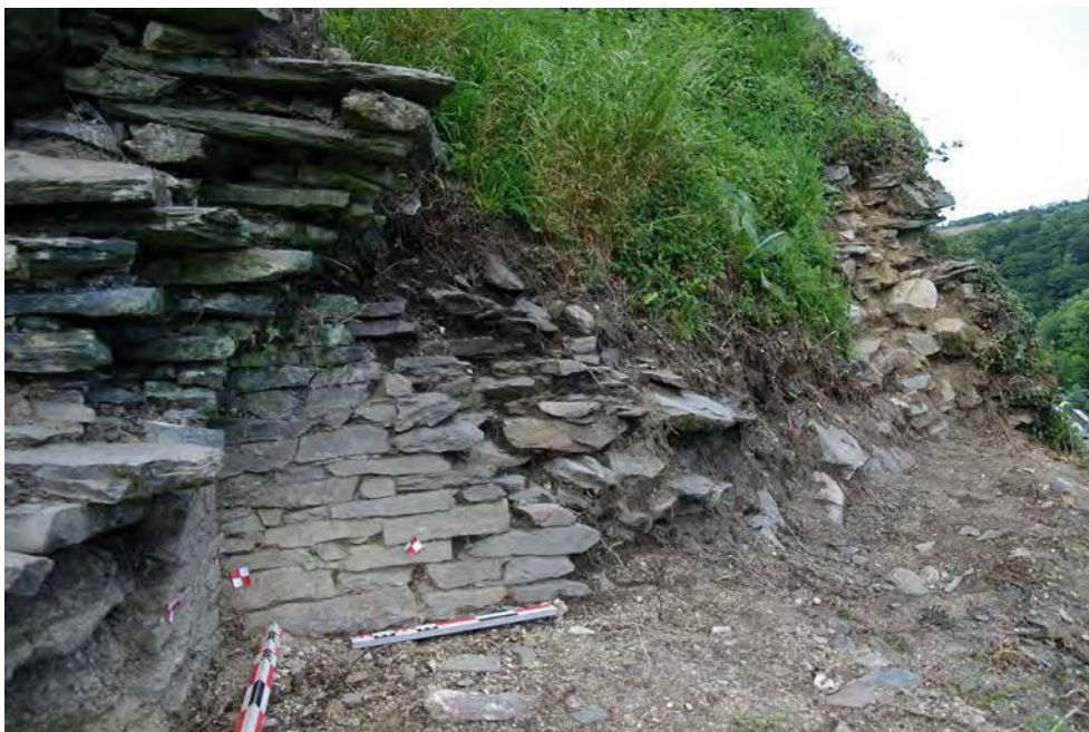
Fig. 81 : Cheminée 3011 : départ de la hotte US 3010. A droite, la courtine M50. Vue du sud-est. Cl. R. Pérennec 2015, CD29/ Mission Archéologie.
