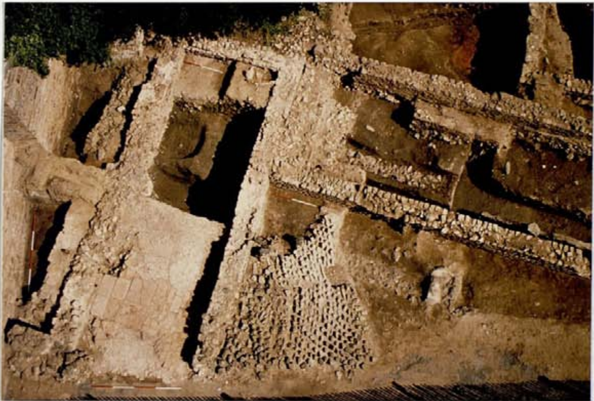
Fig.11 : Vue de l'angle nord-ouest de la cour du bâtiment à galeries, le parement du mur effondré.
