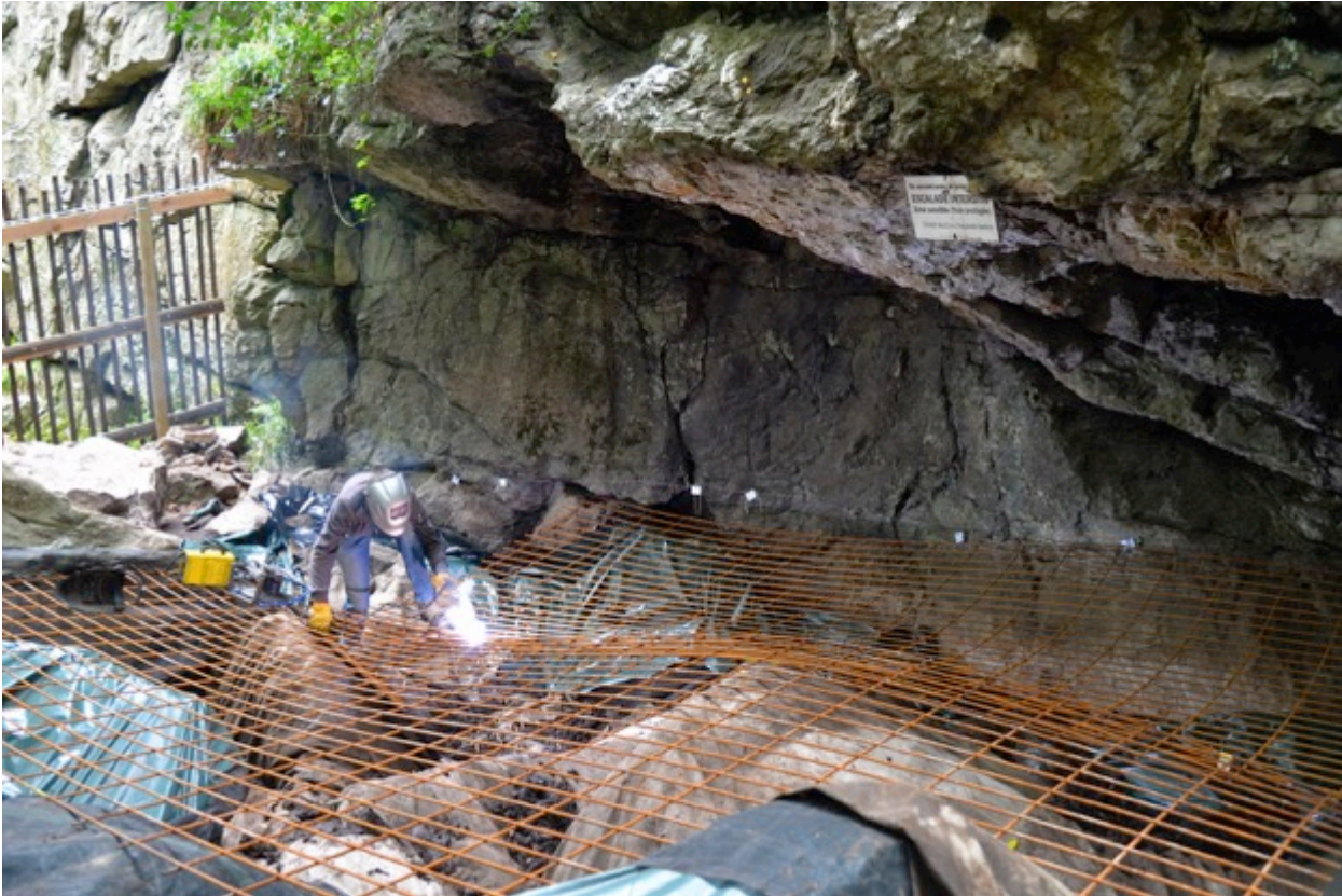
Figure 39. Soudure des différents éléments de treillis entre eux (N. Naudinot).
