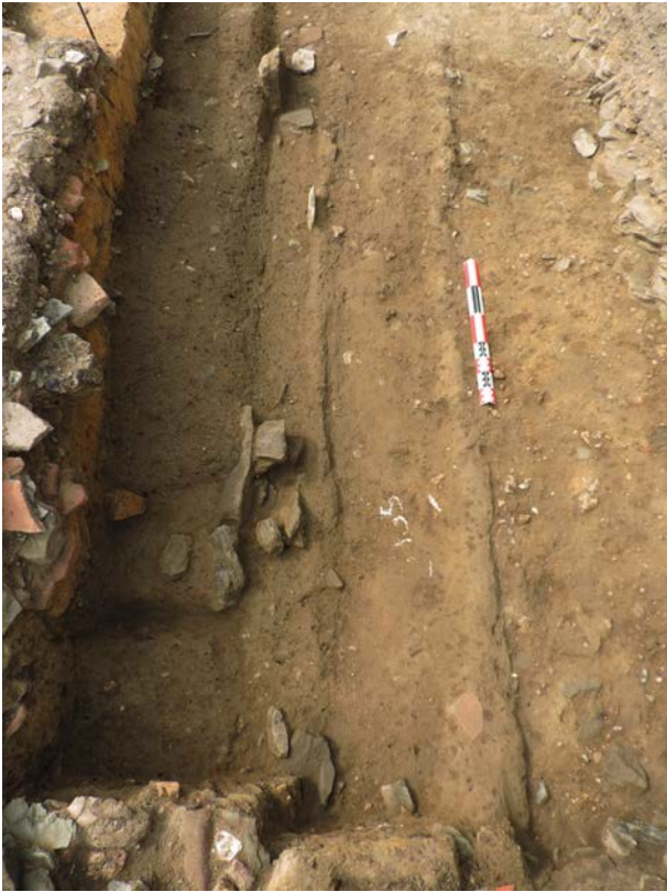
Fig. 46 La base du négatif 1368 depuis le nord avec quelques pierres de 1393 encore de chant. A sa droite, le négatif du fossé initial 1583 © S. Le Berre-Inrap, 24.07.2014-1375
