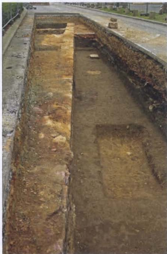
Figure 4 : vue de la maçonnerie 1001 depuis l'est (Cliché L. Beuchet/Inrap)
