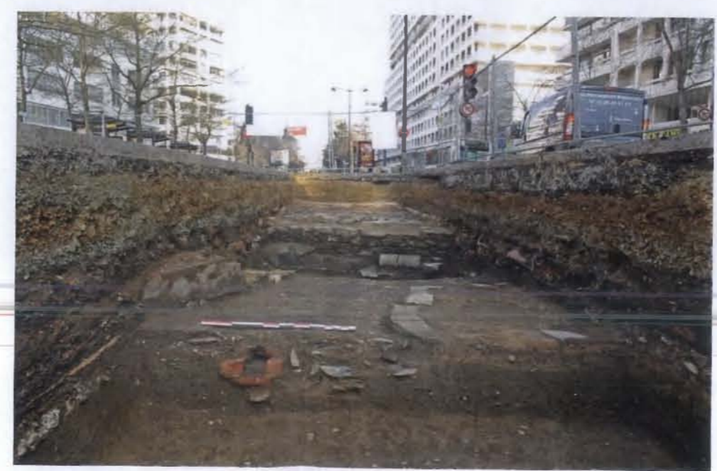
Vue générale de la tranchée 2. Au premier plan la section 8 (Cliché L. Beuchet/Inrap).
