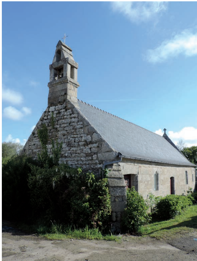
Fig. 3 Façade ouest de l'église © T. Béthus
