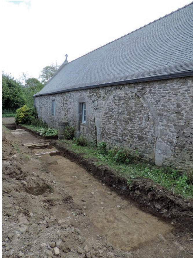
Fig. 7 Vue d'ensemble de la tranchée © T. Béthus
