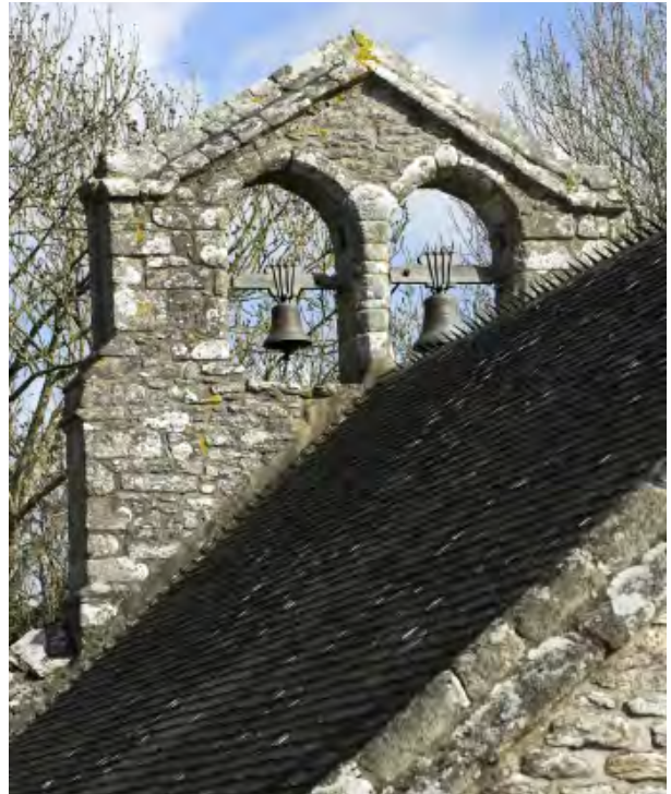
Fig. 12 Clocher-mur © Région Bretagne
