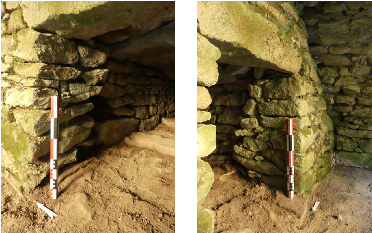
Fig. 41 Rupture de maçonnerie entre les murs 1005 et 1006 © M. Millet, Inrap
