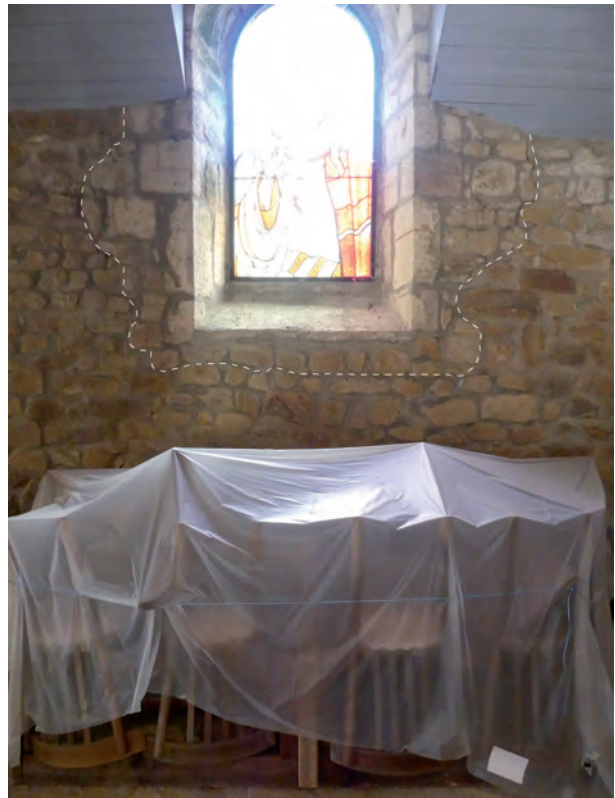
Fig. 14 Fenêtre du mur gouttereau nord © M. Millet, Inrap
