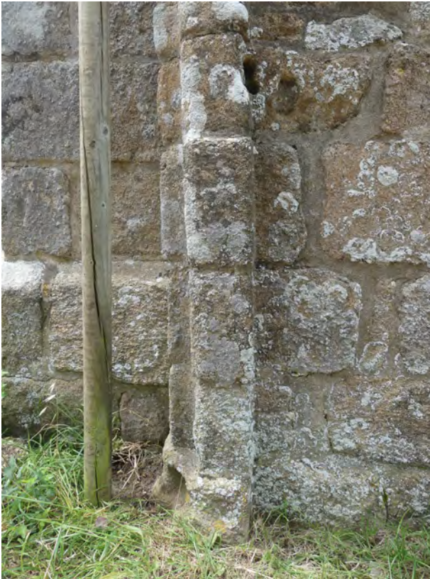
Fig. 21 Piédroit ouest d'une probable porte permettant un accès direct à l'ancien chevet © M. Millet, Inrap
