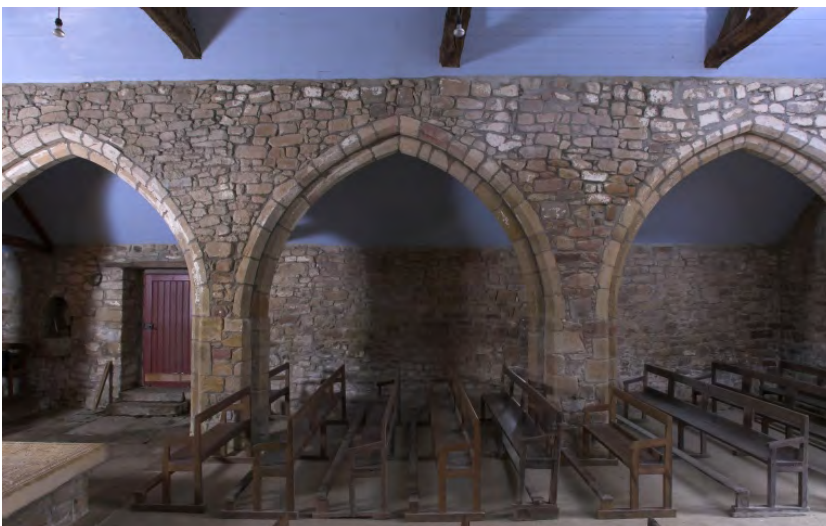
Fig. 9 Arcs brisés à double rouleau et piliers cruciformes séparant le vaisseau central des bas-côtés © Région Bretagne
