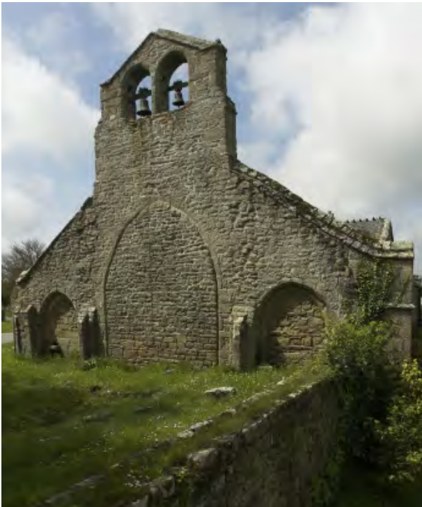
Fig. 11 Arcs diaphragmes, et bouchons © Région Bretagne
