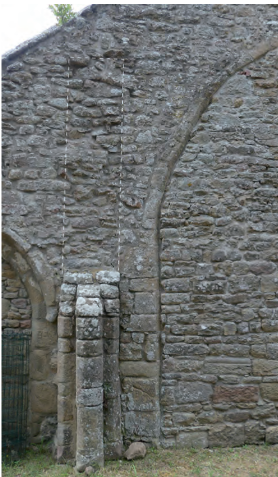
Fig. 15 Arrachement de l'arc sud, au niveau de l'arc diaphragme © M. Millet, Inrap
