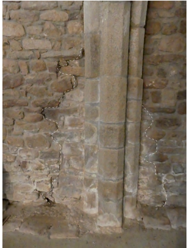
Fig. 22 Pilier nord engagé dans le pignon ouest © M. Millet, Inrap
