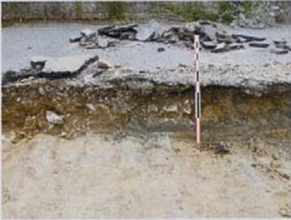
Photo 2 : Tranchée 1, vue de l'enrobé et de sa semelle de fondation reposant sur le sol naturel (cliché : R. Ferrette).
