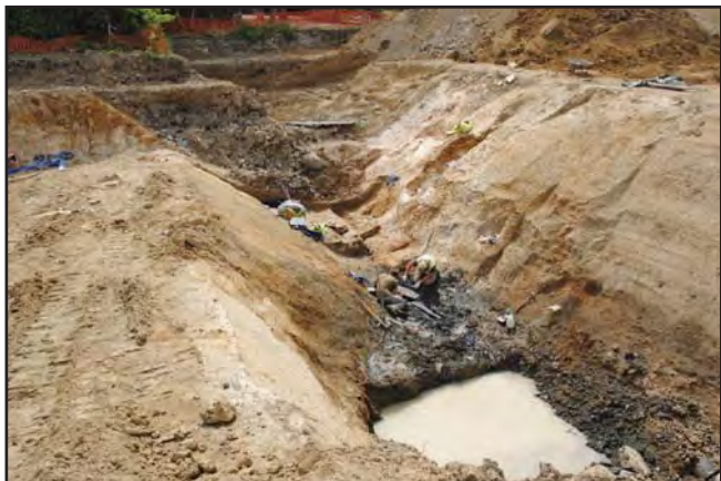
PN 939 Vue du fond du fossé à l'entrée en cours de fouille, exposé sud-ouest
