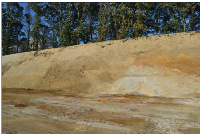
PN 529 Coupe de la carrière dans la côté nord de la rocade Briochine
