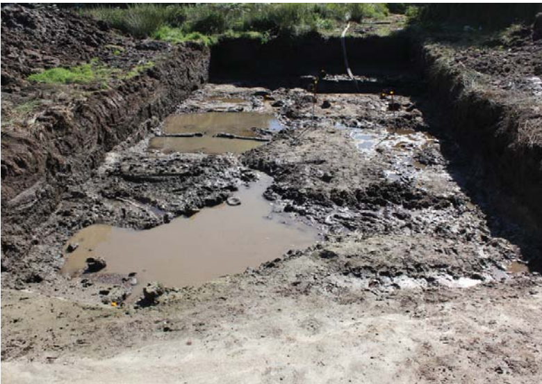
Fig. 11a - Secteur ZH 12 à la fin du décapage mécanique.
