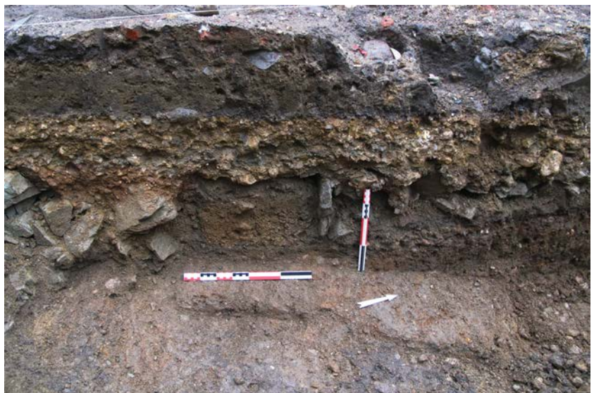
Fig.73 : Vue de détail du conduit 1308. Noter que sur le côté sud (à gauche) le radier de fondation est plus épais en raison de la présence de la dépression liée à la rigole d'écoulement des eaux de toiture de l'ensemble 2 © Equipe de fouille, Inrap.
