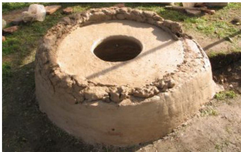
Fig.211 : Partie basse de la chambre de chauffe du four de verrier antique expérimental en cours de construction. ©( http://www.glasrepliken.de/p_glasofenexperiment_VFP.htm )
