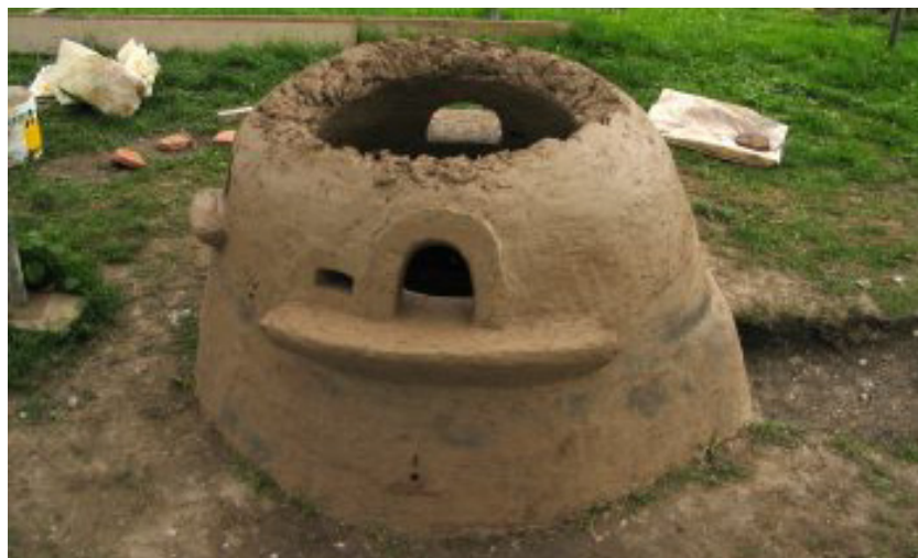
Fig.213 : Four de verrier antique expérimental en cours de construction. Chambre de chauffe couronnée par le laboratoire en cours de construction. © ( http://www.glasrepliken.de/p_glasofenexperiment_VFP.htm )
