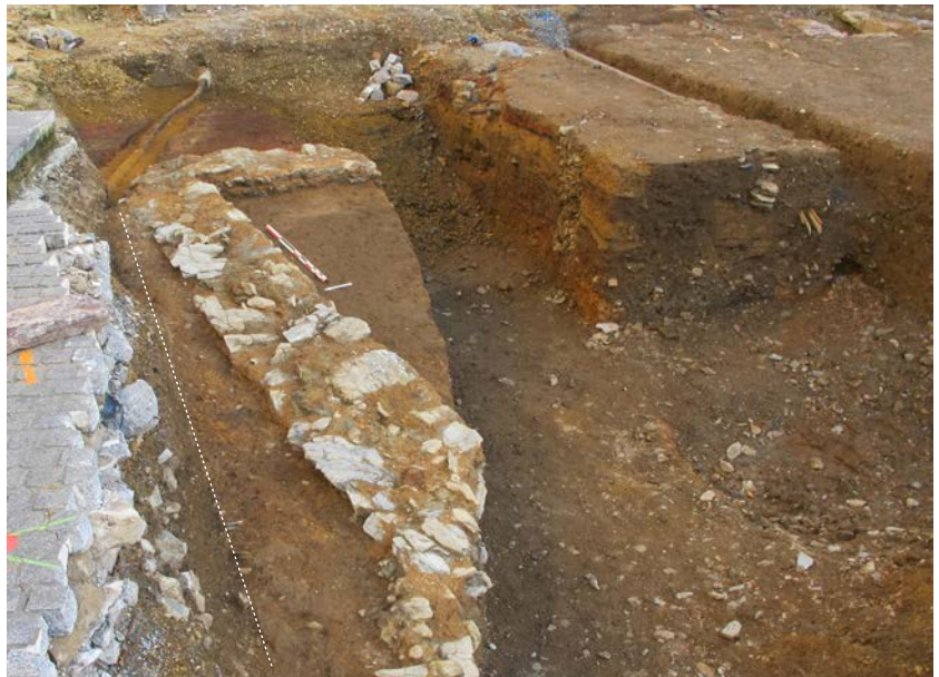
Fig.285 : Vue du témoin stratigraphique nord préservé entre la tranchée de tout à l'égout P3 et la tranchée d'adduction d'eau ancienne dont on devine le bord en bas à gauche. Au second plan le creusement d'installation d'un ancien câble électrique entamant également la stratigraphie ancienne est bien visible © Equipe de fouille, Inrap
