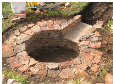
Fig.211 : Partie basse de la chambre de chauffe du four de verrier antique expérimental en cours de construction. ©( http://www.glasrepliken.de/p_glasofenexperiment_VFP.htm )
