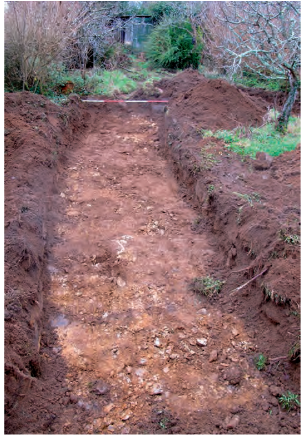
Fig. 7 Vue de l'extrémité ouest de la tranchée 7. © Dominique Pouille, Inrap
