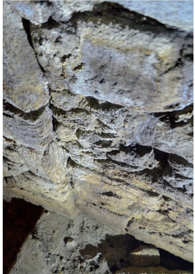
Fig. 83 L'absence de liaison de la porte 1069 avec la tour ouest © E. Cadiou, Inrap
