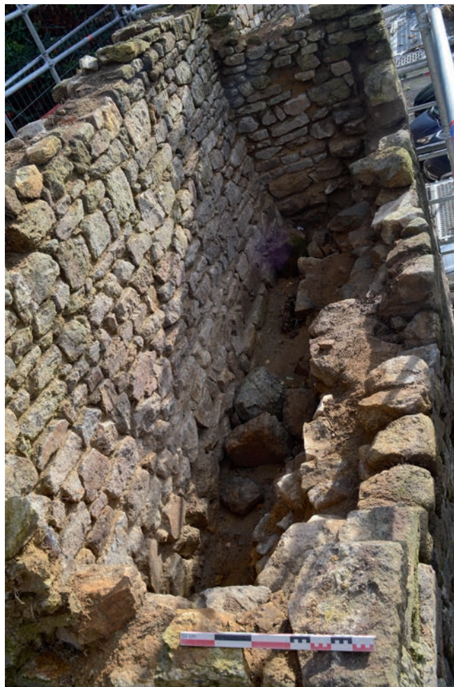
Elle a été détruite et épierrée avant la construction du muret de clôture.
