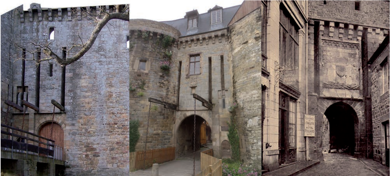
Fig. 242 Les ponts-levis à bascule : château de la Hunaudaye en Plédéliac (22), les Portes Mordelaises à Rennes (35), la porte du Roy au Mont-Saint-Michel (50) © clichés E. Cadiou, Inrap (sauf la carte postale ancienne)
