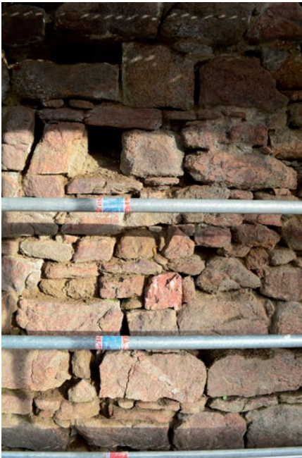
Fig. 262 La rubéfaction du parement 1133
