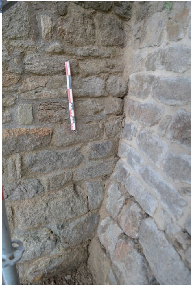
Fig. 143 Le chaînage de la courtine et de la tour ouest du châtelet © E. Cadiou, Inrap
