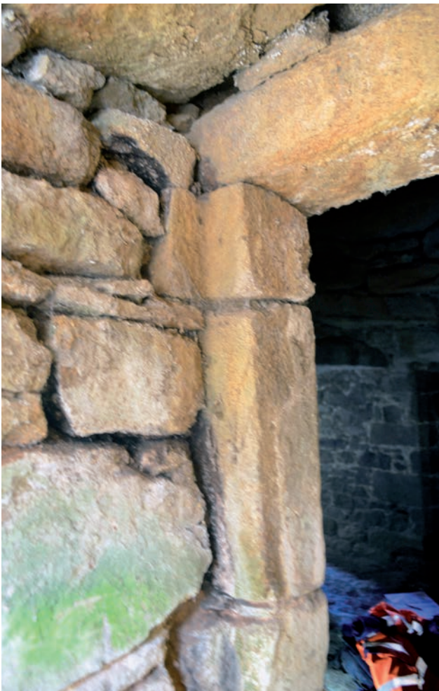
Fig. 80 La feuillure intérieure sur le tableau ouest © E. Cadiou, Inrap
