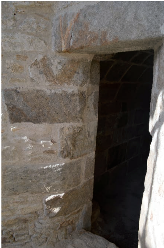
Fig. 128 Le chaînage du mur 1094 et de la baie 1096 © E. Cadiou, Inrap
