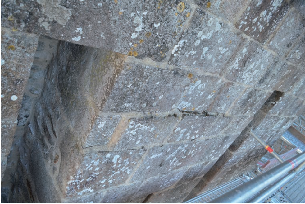
Fig. 56 La différence de nu sur la façade de l'avant-corps © E. Cadiou, Inrap
