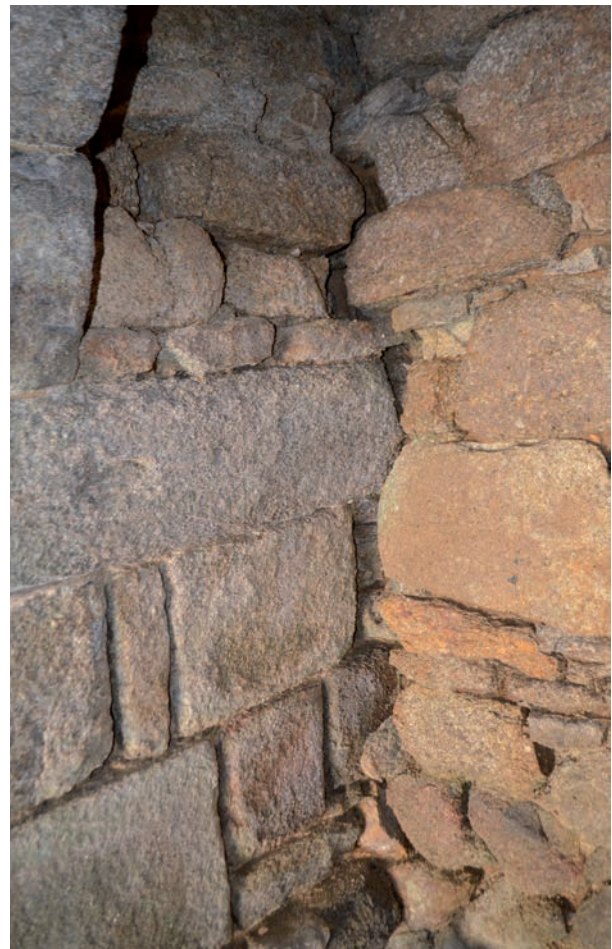
Fig. 74 Le bûchement de la première façade du châtelet pour intégrer la façade avancée © E. Cadiou, Inrap
