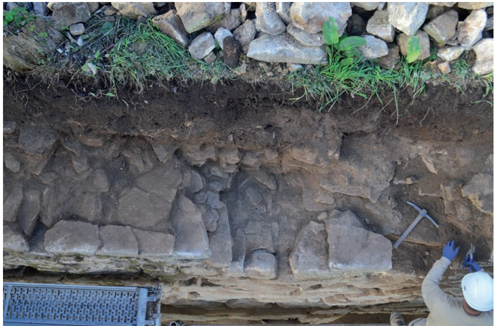
Fig. 138 Le blocage mettant en oeuvre les panneresses © E. Cadiou, Inrap
