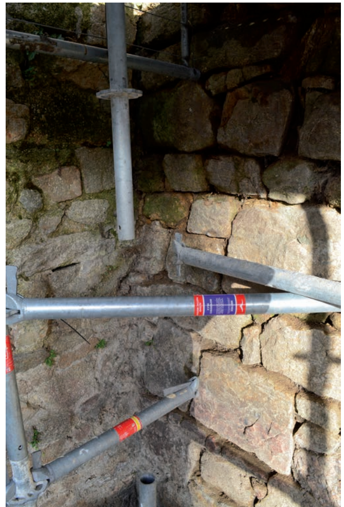
Fig. 165 Le chaînage de la courtine 1133 et de la tour carrée 1136 © E. Cadiou, Inrap
