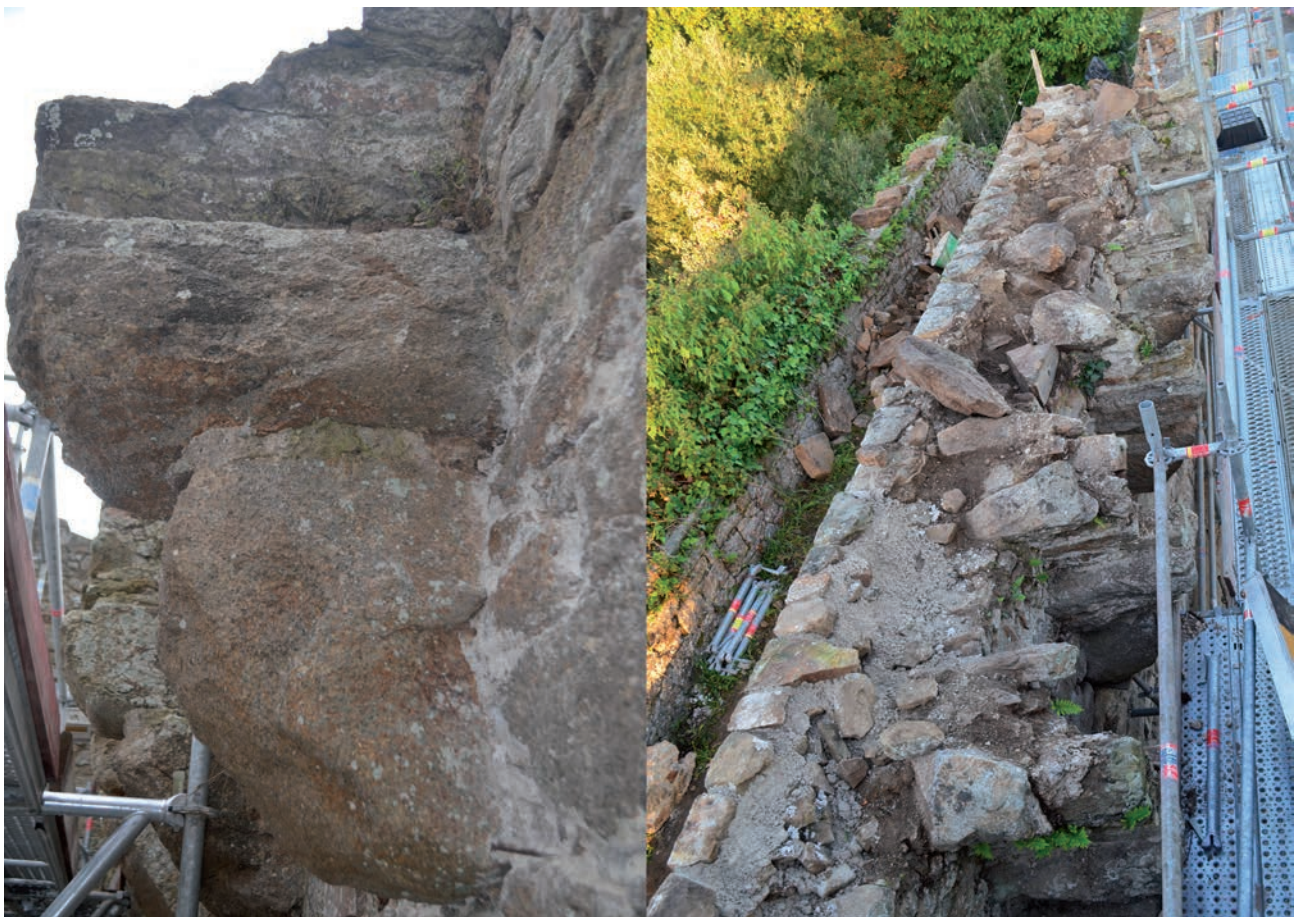
Fig. 146 Vue générale des mâchicoulis sur arcs et leurs consoles © E. Cadiou, Inrap
