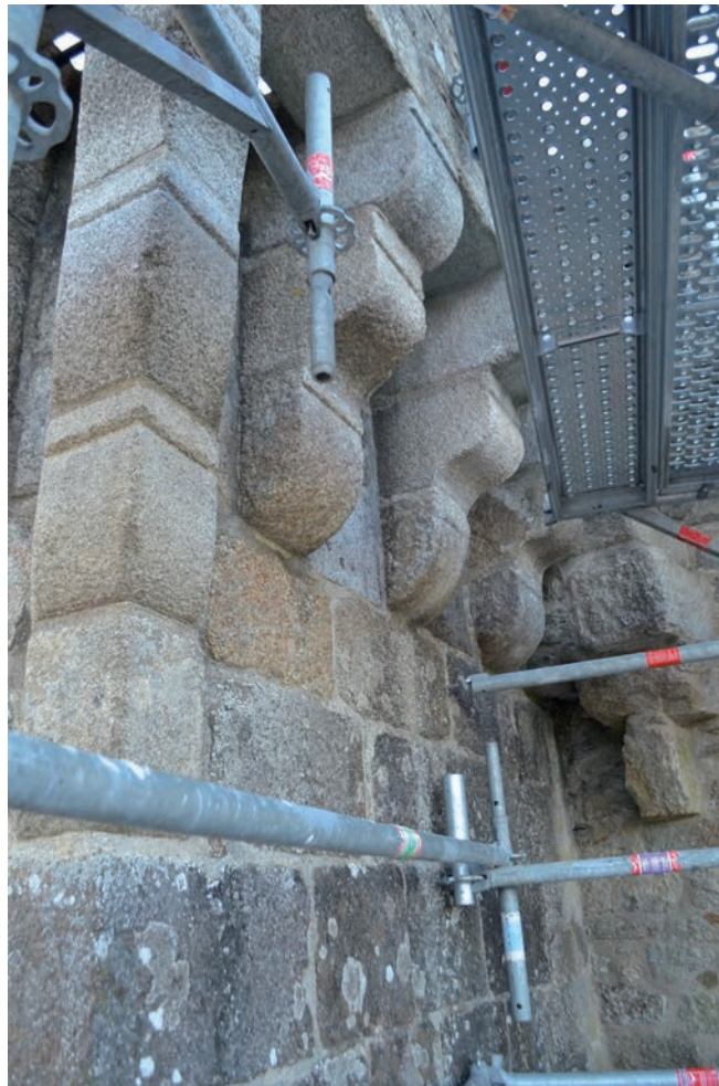
Fig. 57 Vue générale des consoles © E. Cadiou, Inrap
