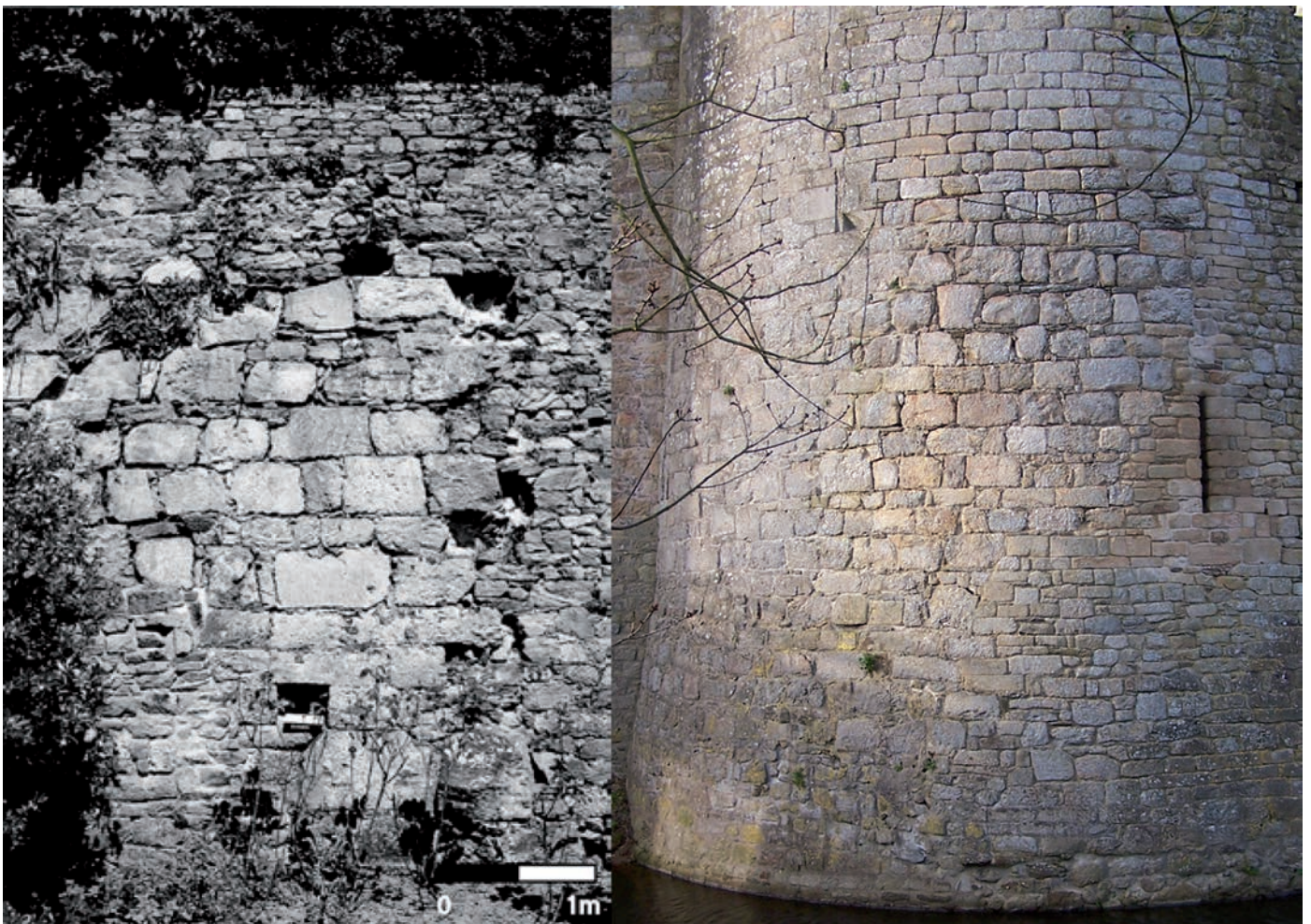
Fig. 260 Une mise en œuvre similaire à Lamballe (22) (extrait de HERVIAUX (G.). — Le château de Lamballe, dans Enceintes médiévales dans le Grand Ouest , projet collectif de recherches sous la dir. de J. Matrineau. Nantes : DRAC Pays de la Loire, SRA, 2011, p. 124-130, p. 129) et au château de la Hunaudaye en Plédéliac (22), tour de la Chapelle (XIIIe siècle) © E. Cadiou
