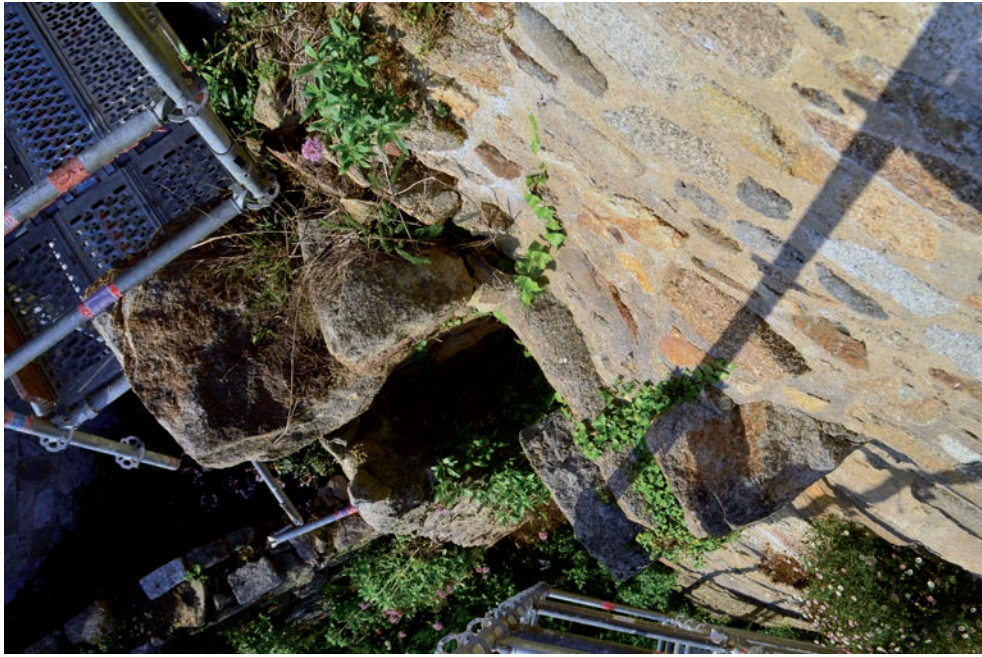
Fig. 50 L'ancien conduit de latrine © E. Cadiou, Inrap
