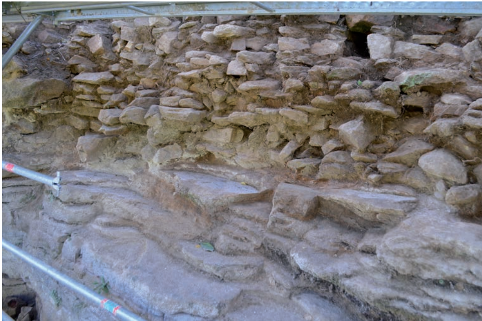
Fig. 140 Le trou de boulin conservé dans le blocage © E. Cadiou, Inrap
