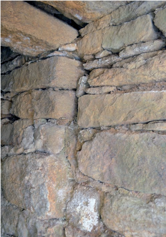
Fig. 82 L'absence de liaison de la porte 1054 avec la tour ouest © E. Cadiou, Inrap
