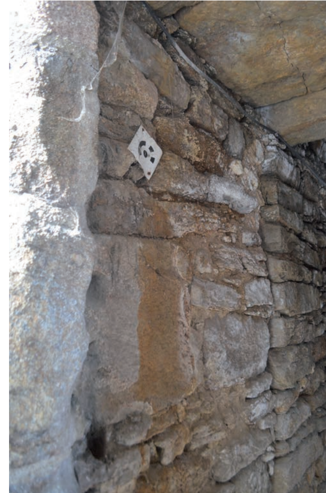
Fig. 101 L'absence de chaînage de la porte 1051 avec la tour est © E. Cadiou, Inrap
