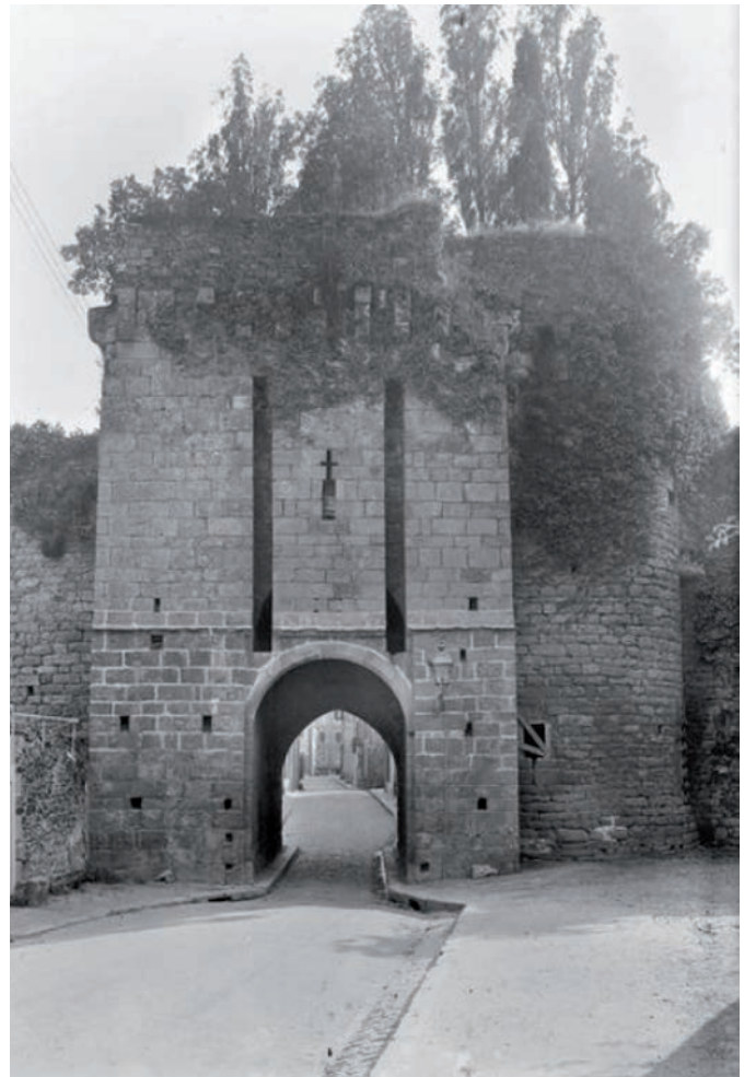
Fig. 252 L'archère frontale de la tour ouest agrandie avant la restauration de 1926-27 © G. Estève (MAP, 1996-025-0242)
