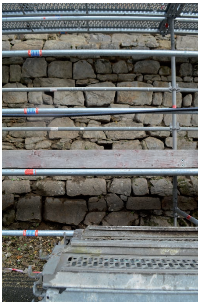
Fig. 163 Vue générale du parement médiéval 1133 © E. Cadiou, Inrap
