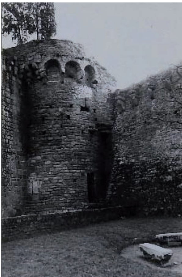
Fig. 253 L'élargissement de l'archère 1021 à l'étage de la tour ouest (MAP, 0081-022-0013)
