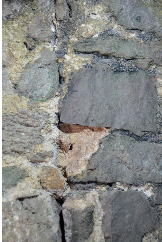
Fig. 96 Le détail des mortiers dans l'archère 1122 (mur de soutènement nord) © E. Cadiou, Inrap
