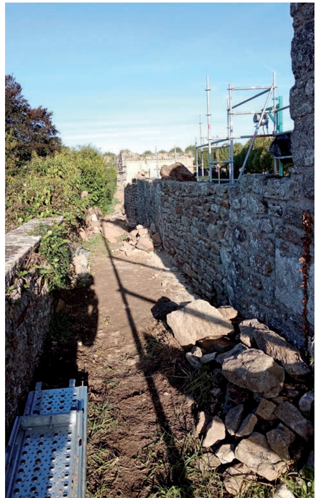
Fig. 149 Vue générale du chemin © E. Cadiou, Inrap
