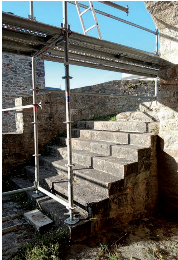
Fig. 134 L'escalier neuf menant au chemin de ronde © E. Cadiou, Inrap
