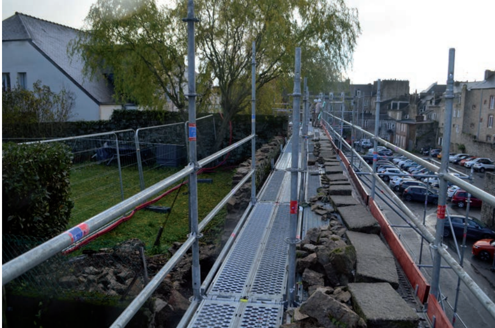
Les dalles de couverture ont été déposées par l'entreprise de maçonnerie.
