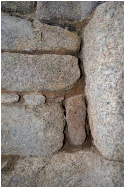
Détail du liant en terre de 1049 qui s'appuie sur 1036. Le mur de gorge est donc postérieur.
