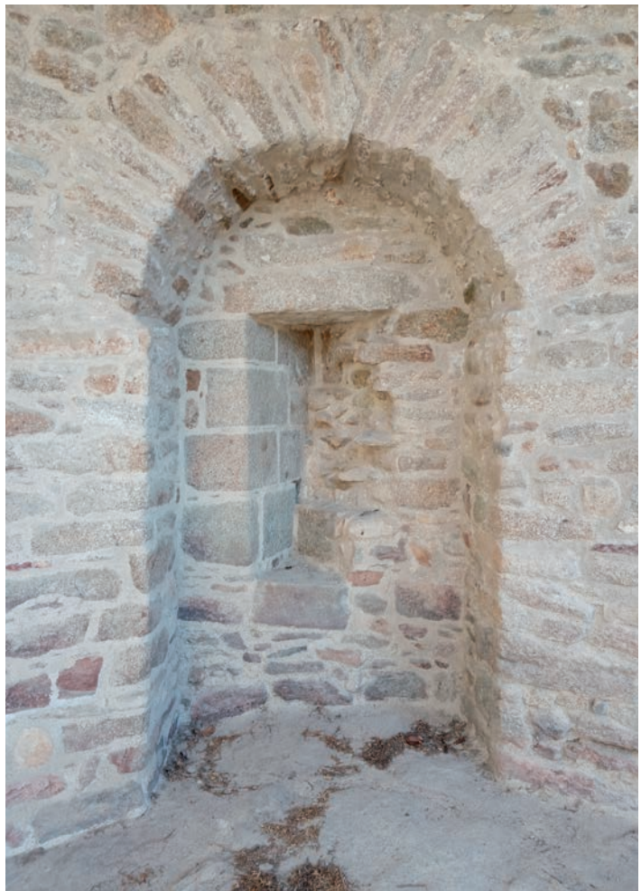
Fig. 34 Le rejointoiement de 1993-94 © E. Cadiou Inrap
