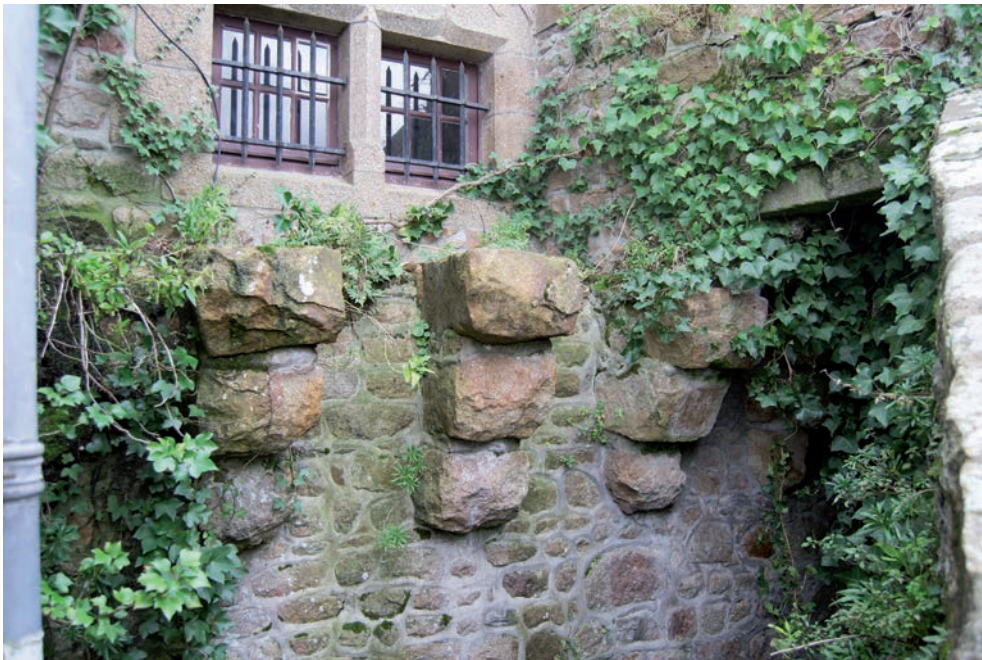
Fig. 227 Les consoles de l'enceinte édifiée à partir de 1256 au Mont-Saint-Michel (50) © L. Arnaud, Inrap
