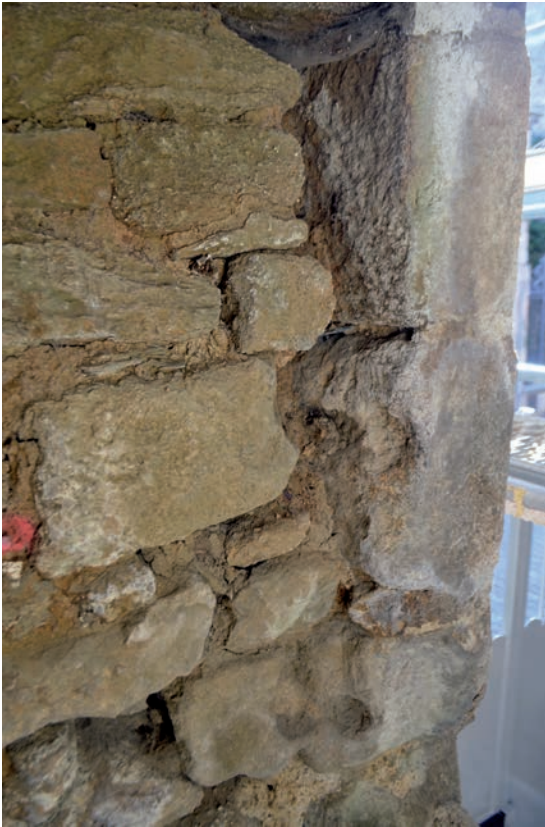
Fig. 79 La porte 1054 : chaînage des pierres d'encadrement extérieur avec le tableau © E. Cadiou, Inrap
