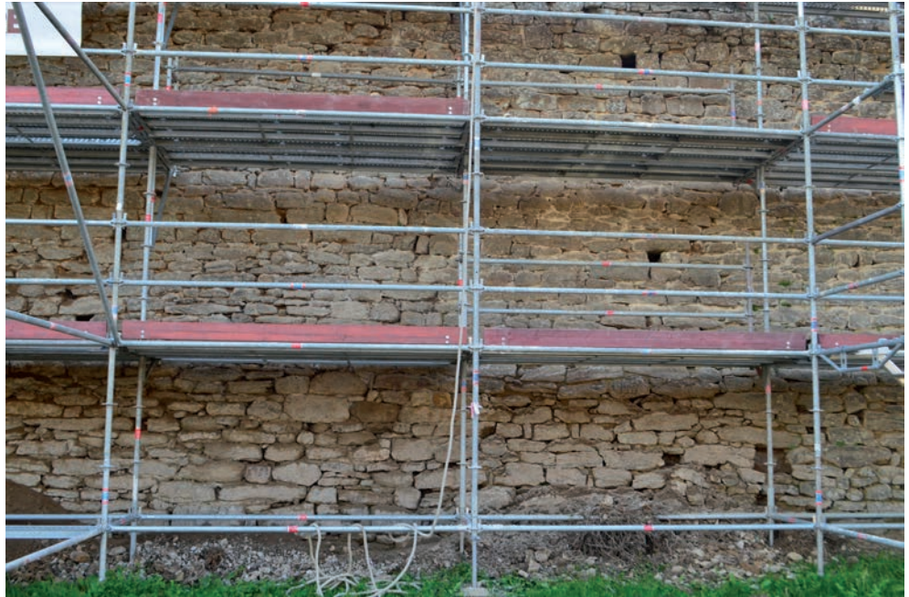
Fig. 137 Vue générale du parement médiéval 1001 © E. Cadiou, Inrap
