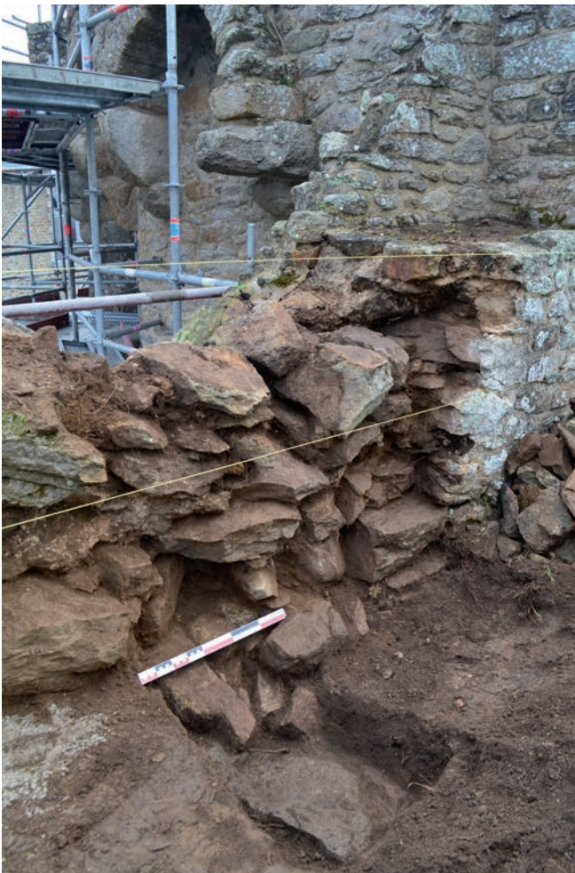
Fig. 148 Le parement d'habillage suite à l'arrachement de la courtine © E. Cadiou, Inrap
