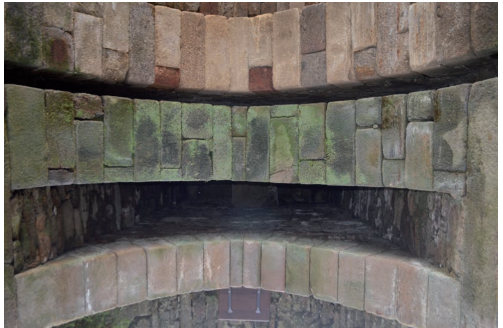
Fig. 67 L'assommoir et la herse de la porte 1036 © E. Cadiou, Inrap
