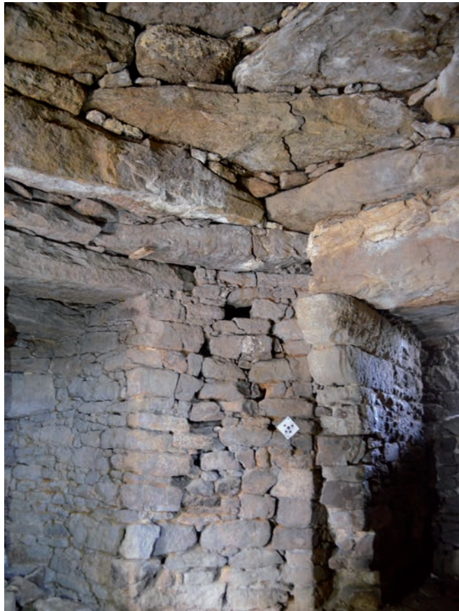
Fig. 114 Vue générale des dalles fissurées
