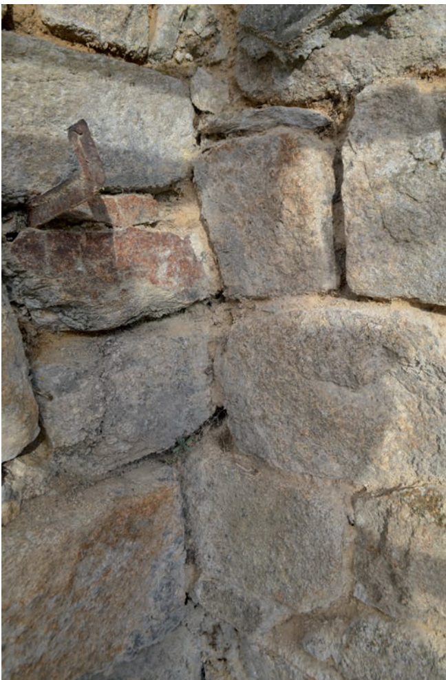
Fig. 168 Le chaînage de la tour carrée et de la courtine 1153
