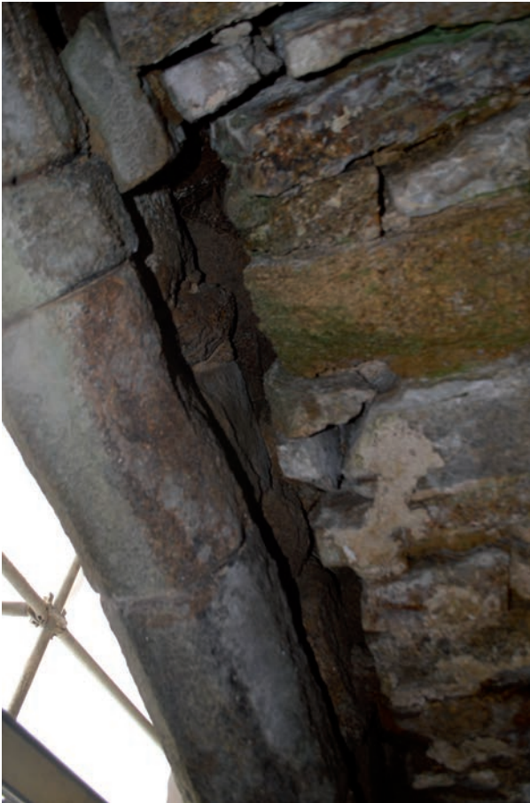
Fig. 64 Les claveaux de l'arc 1050 non chaînés à la voûte © E. Cadiou
