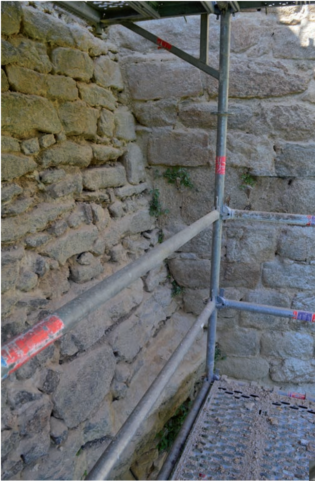
Fig. 142 La tour Beaumanoir qui s'appuie sur le parement de la courtine © E. Cadiou, Inrap
