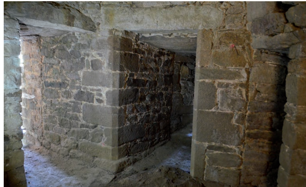
Fig. 98 Vue générale de la tour ouest © E. Cadiou, Inrap
