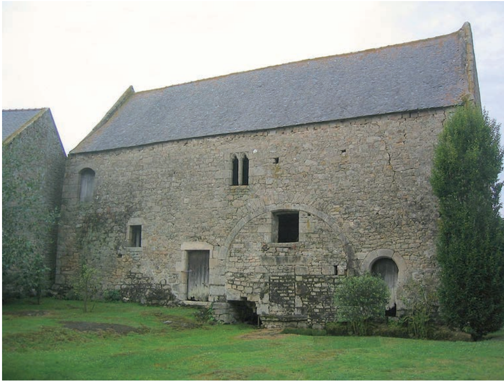
Fig. 231 L'arc en plein-cintre doublé d'un arc de décharge : manoir des Fossés à Plélan-le-Petit (22) (cliché internet)
