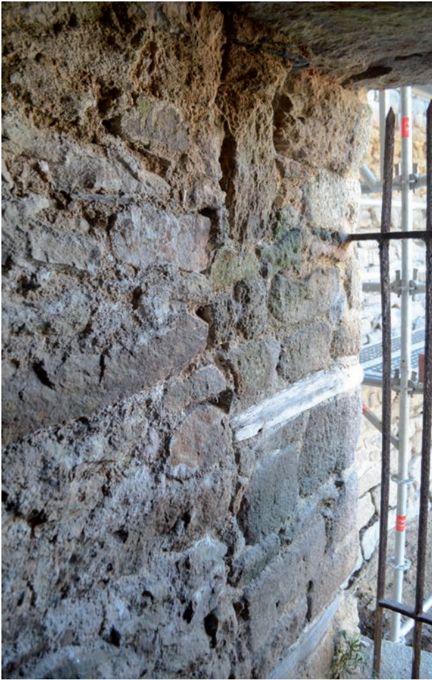
Fig. 95 Le détail des mortiers dans l'archère 1122 (mur de soutènement sud) © E. Cadiou, Inrap
