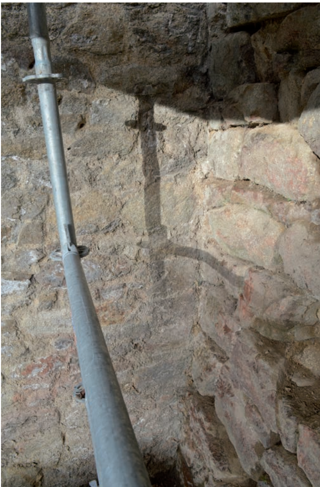
Fig. 164 Le contrefort 1165 qui s'appuie sur la courtine 1133 © E. Cadiou, Inrap
