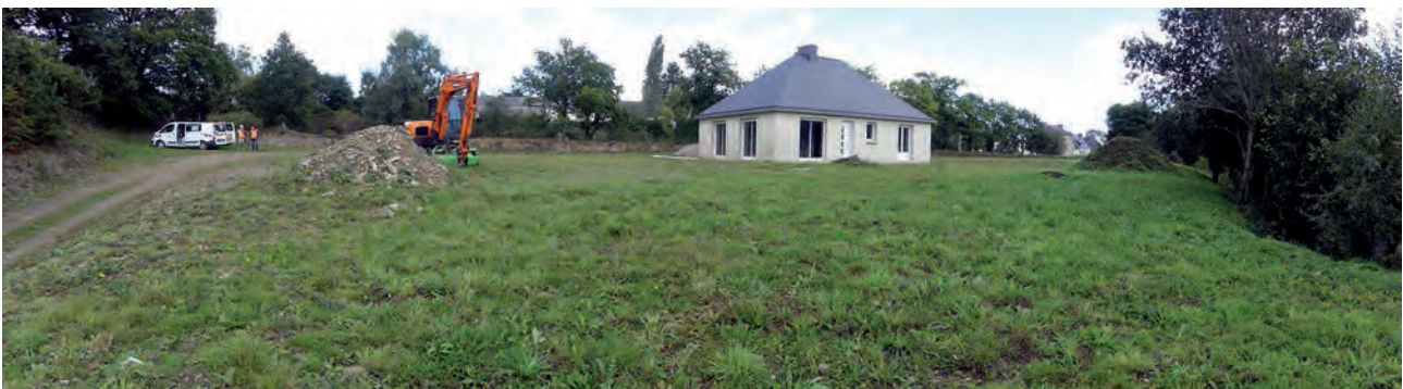
Fig. 4 Vue panoramique du terrain vers le nord avant l'ouverture des sondages.
