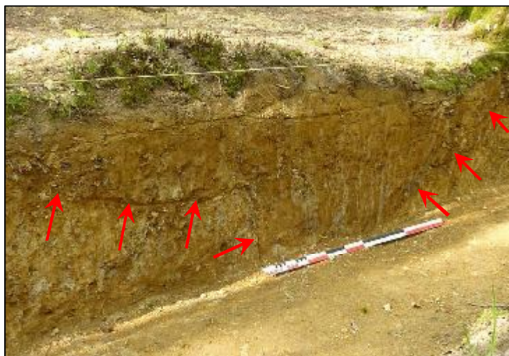
Photo21 : Fosse (US 609) au centre de l'élévation centrale
