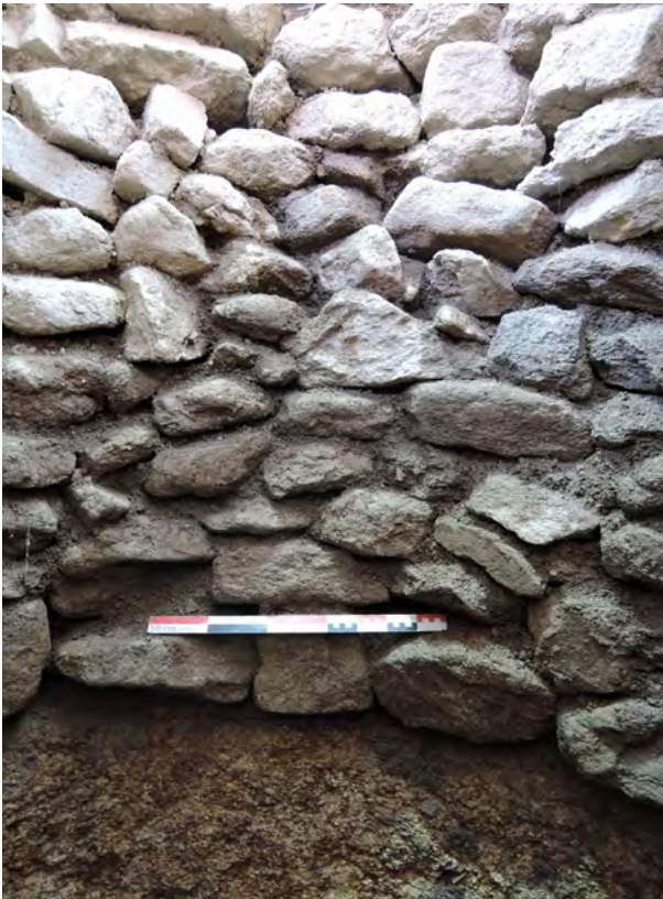
Fig. 178 - Vue du parement reposant directement un ressaut aménagé dans le substrat © J. Dolbois, Inrap.
