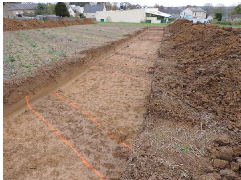
Fig. 61 Les fossés appartenant au parcellaire laniéré tranchée 4. © Emmanuelle Ah thon, Inrap
