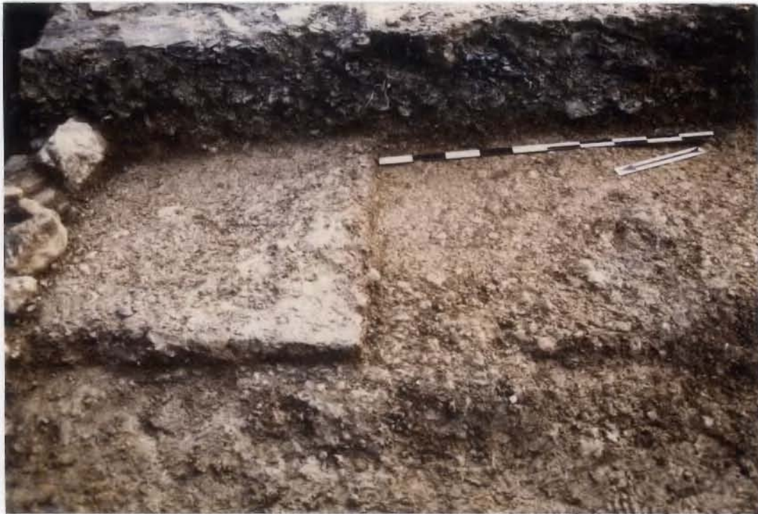
Cliché 7: recharge sur le trottoir de l'axe primitif. On distingue nettement l'épais remblai schisteux destiné à remonter le niveau de la chaussée pour le franchissement du fossé.
