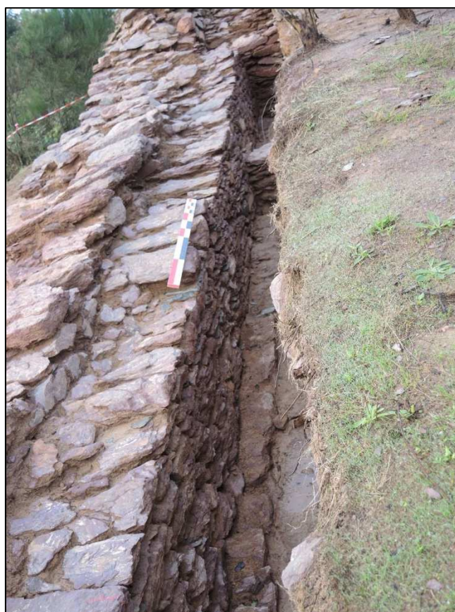
Photo 14 : contremur F770 plaqué contre la muraille F 700
