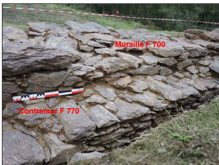
Photo 7 : parement nord de la muraille partiellement masqué par le contremur F 770
