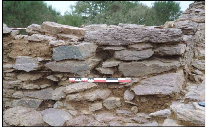
Photo 10 : vue du parement interne ouest
