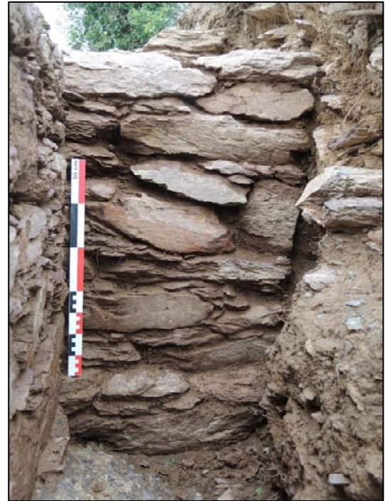
Photo 18 : vue du parement est
