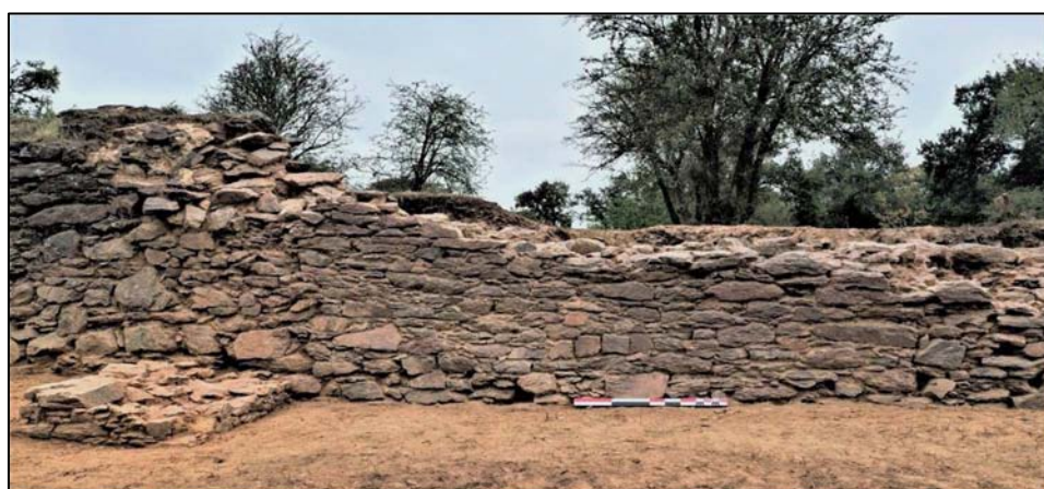
Photo 6 : reprise de maçonnerie F 783
