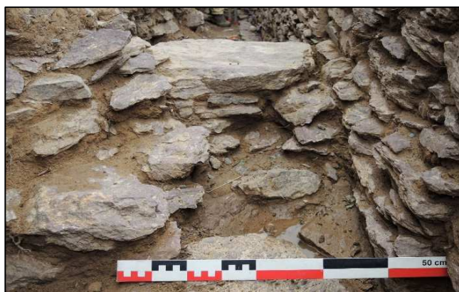
Photo 25 : mur F 782 parement ouest dégradé
