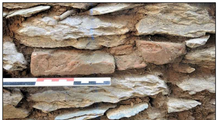
Photo 47 : carreaux de sol en réemploi dans le contremur F 770
