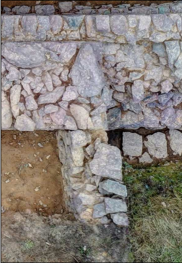
Photo 29 : mur appuyé sur la muraille F 700 - vue de dessus
