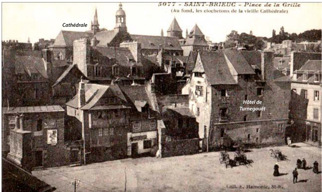
Fig. 9 La place de la Grille en cours de reconstruction.
