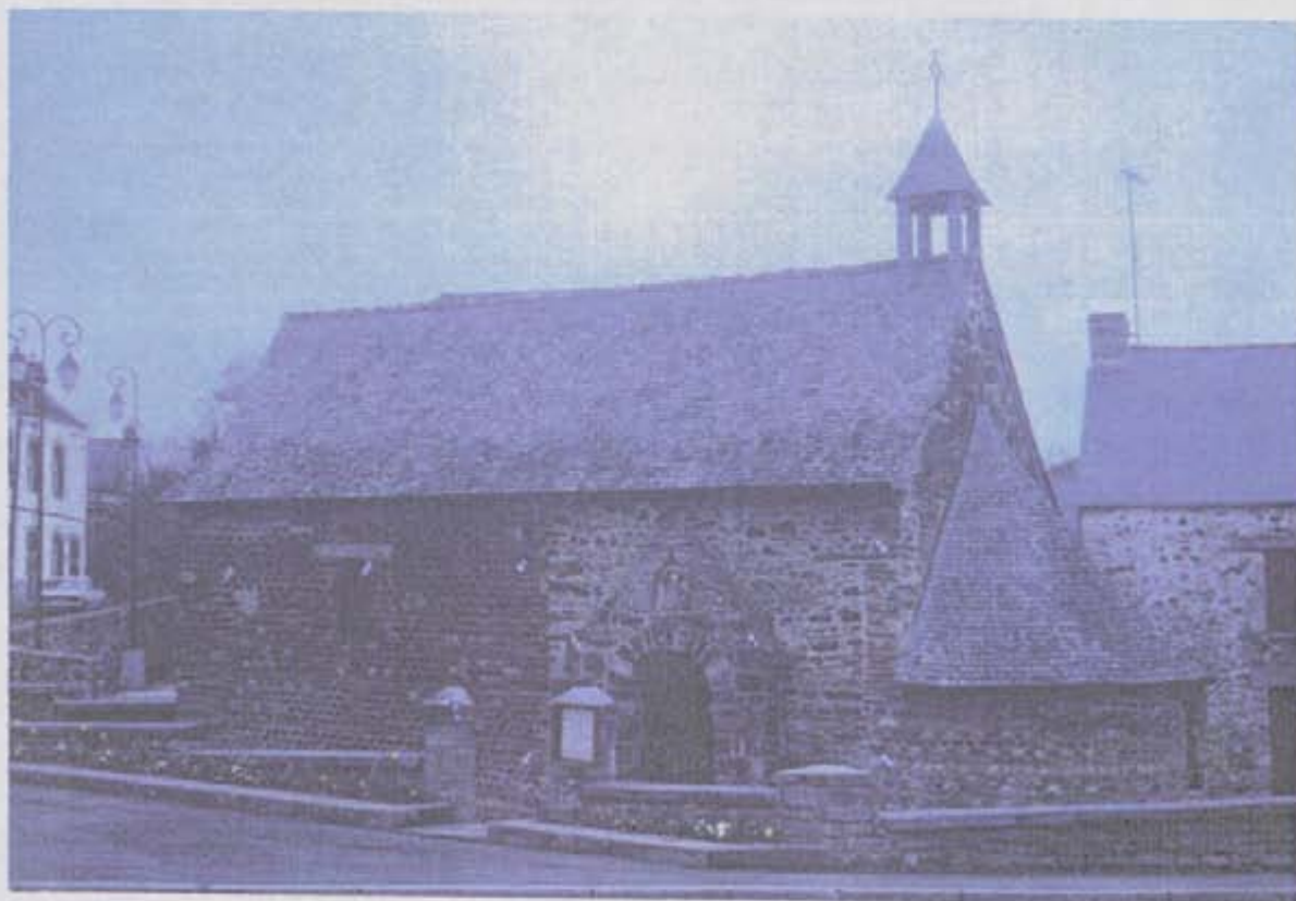
FIG. 6 Chapelle Sainte-Agathe; vue générale de la facade sud, du mur pignon est et de l'abside. Cliché : X. Rodier (L.A.U.T.).
