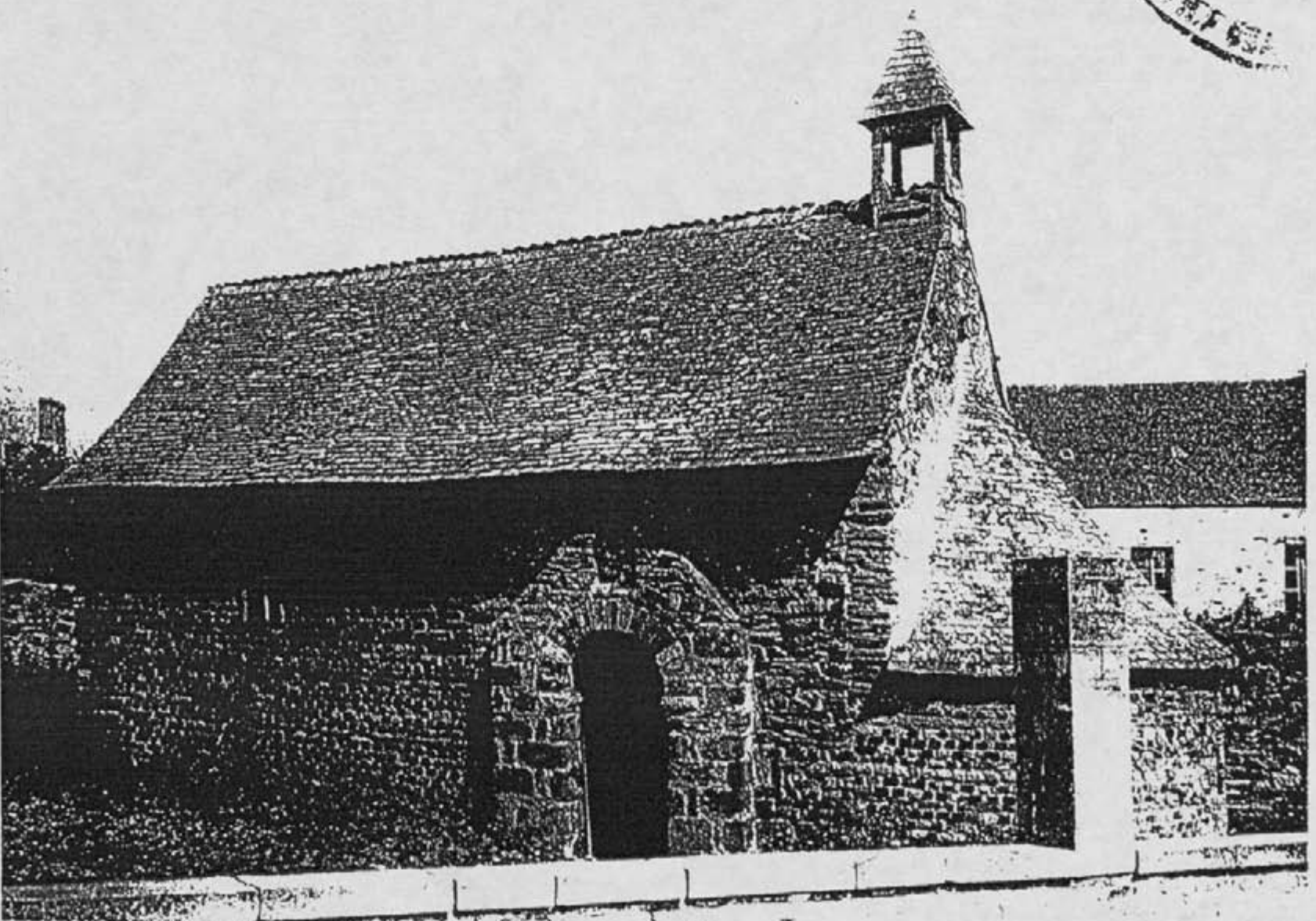
FIG. 13 Photographie de la façade sud de la chapelle Sainte-Agathe avant 1878. Au premier plan on peut voir le mur du cimetière. (archives départementales)
