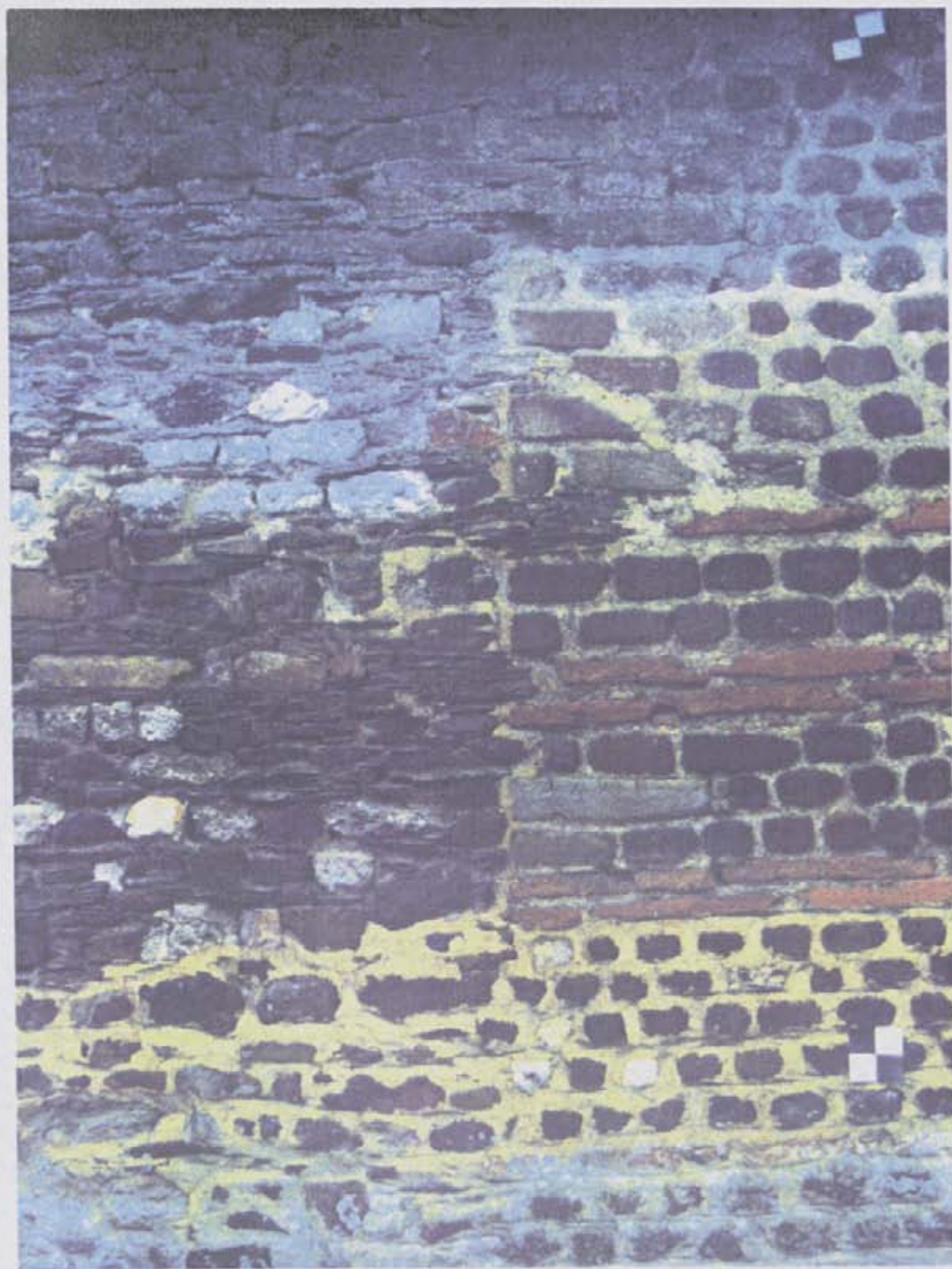
FIG. 43 Chapelle Sainte-Agathe. Zone 3; détail de la jonction entre les élévations gallo-romaine et médiévale. Cliché : X. Rodier (L.A.U.T.).
