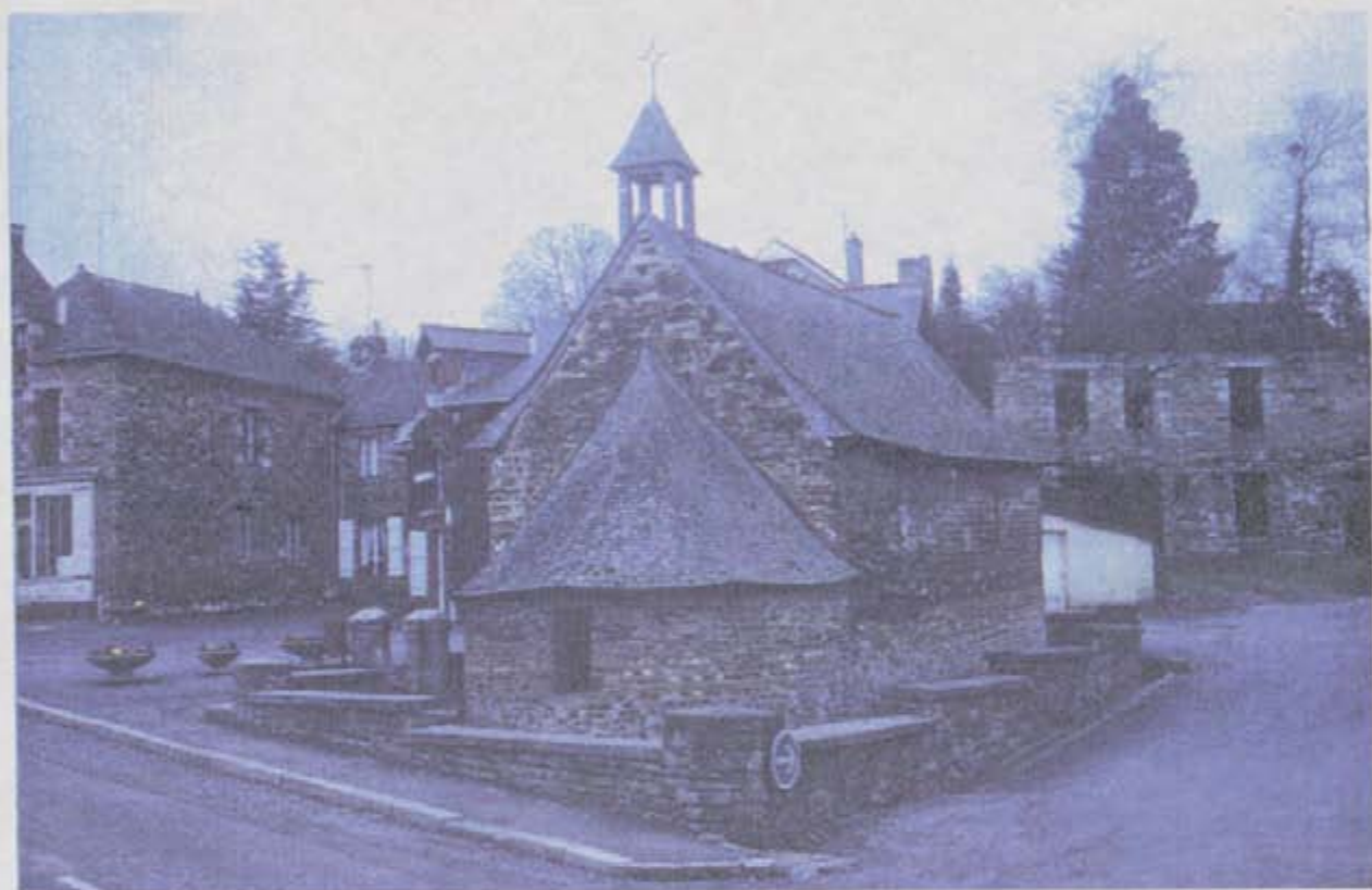
FIG. 48 Chapelle Sainte-Agathe. Zone 4 Vue générale du mur pignon est et de l'abside (zone 5).
