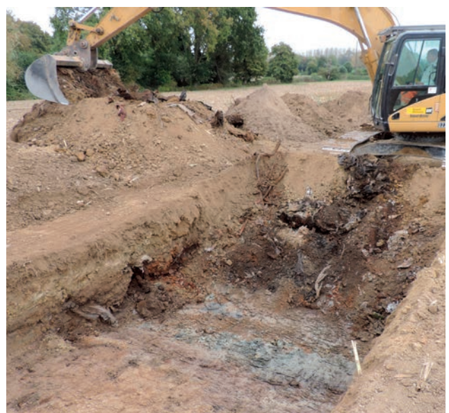
T36 - comblement du chemin creux : métal, plastique, béton...
