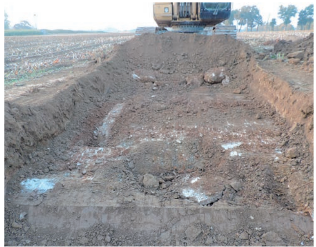
T4 - remblais : plaques de béton
