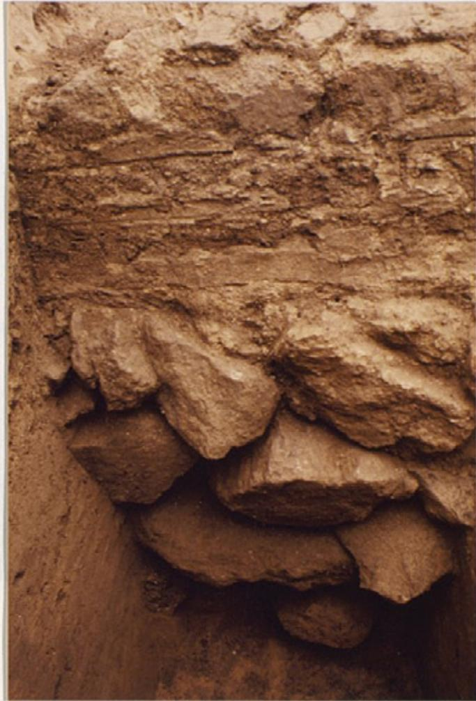
Détail du mur gallo-romain : fondation et appareillage avec joints au fer
