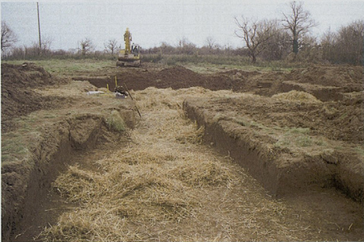
Photo 3 : mise en place de paille pour la protection des blocs en cas de redécapage. E. Mare, INRAP
