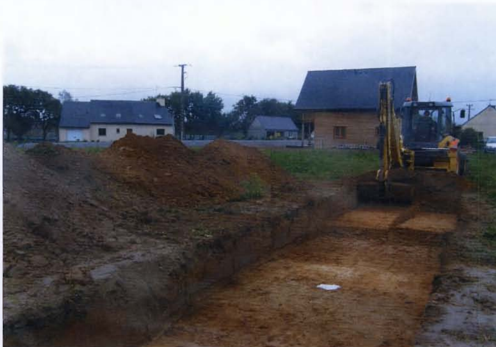
Fig. 6 : vue générale de la tranchée 1 (Cl. T. Béthus / Inrap)
