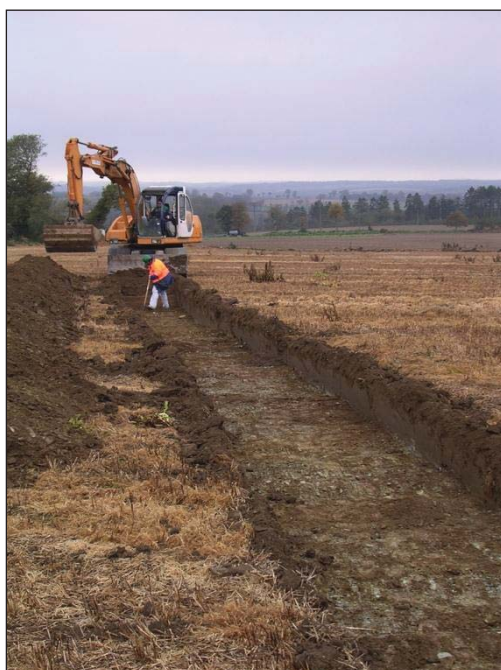
Figure 82. Décapage de la Tranchée T1 (M. Fily)
