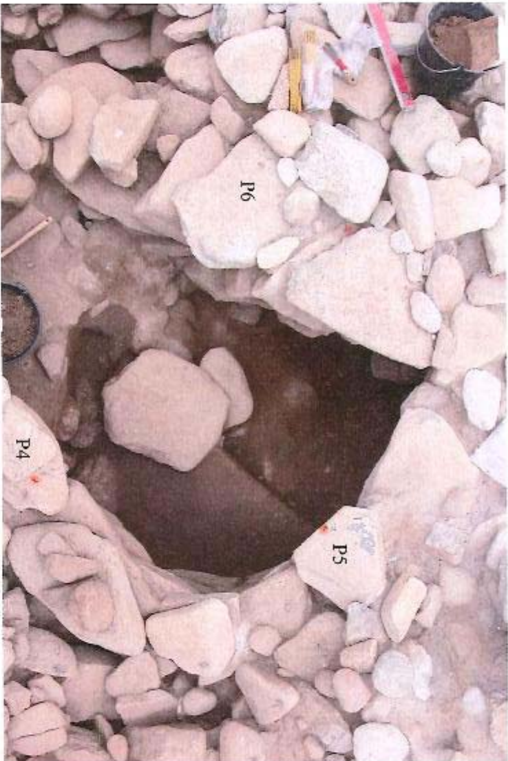
PL 30 : Structure I, alvéole. Le mur de refend P6 s'appuie sur le parement interne, F5. La continuité entre P4 et P5 est nulle. (CL V. E. Leroux)
