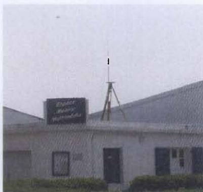
Fig. 11 : Vue de la station RGP sur le toit du Cyber Espace de Molène à partir duquel nous avons effectué nos relevés
