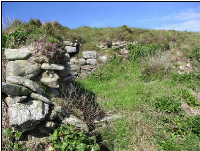
Fig. 4 - Construction moderne, Tariec Vraz, Landéda (cliché Y. Sparfel).
