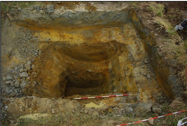
Photo 55 : creusement au godet étroit, substrat rocheux
