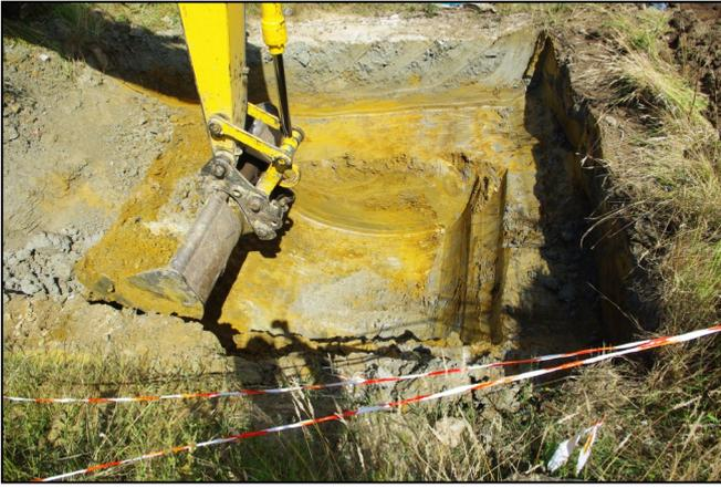
Photo 53 : creusement au godet large : sédiment gris du fond du puits.
