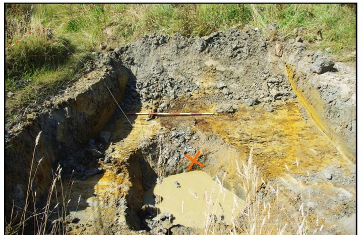
Photo 52 : creusement du puits au tractopelle (godet large); La base de la marche septentrionale est encore visible (en marron) ; la croix rouge indique le point de résurgence de l'eau .
