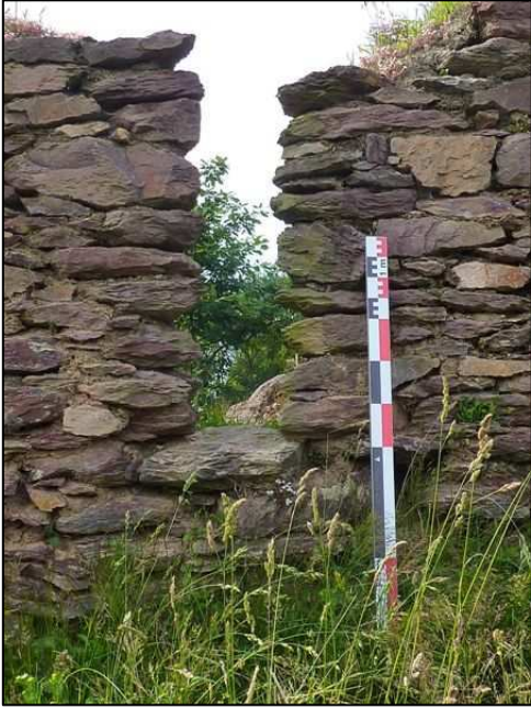
Photo 88 : Archère restaurée UC 5
