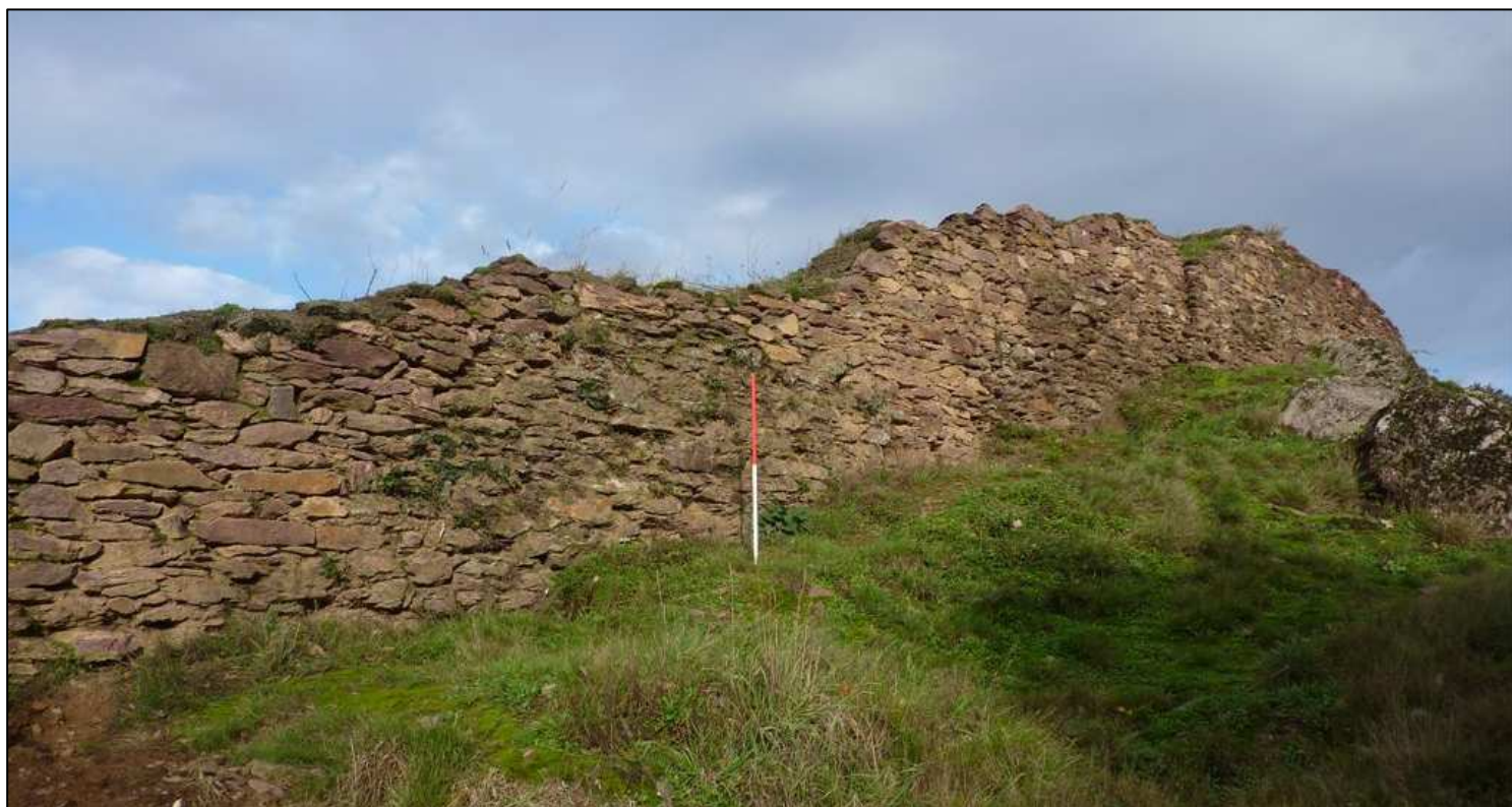
Photo 87 : Parement M 700 (côté ouest) en partie restauré
