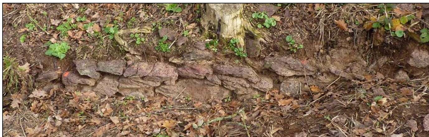
Photo 63 : Parement M 160 intérieur bâtiment A3
