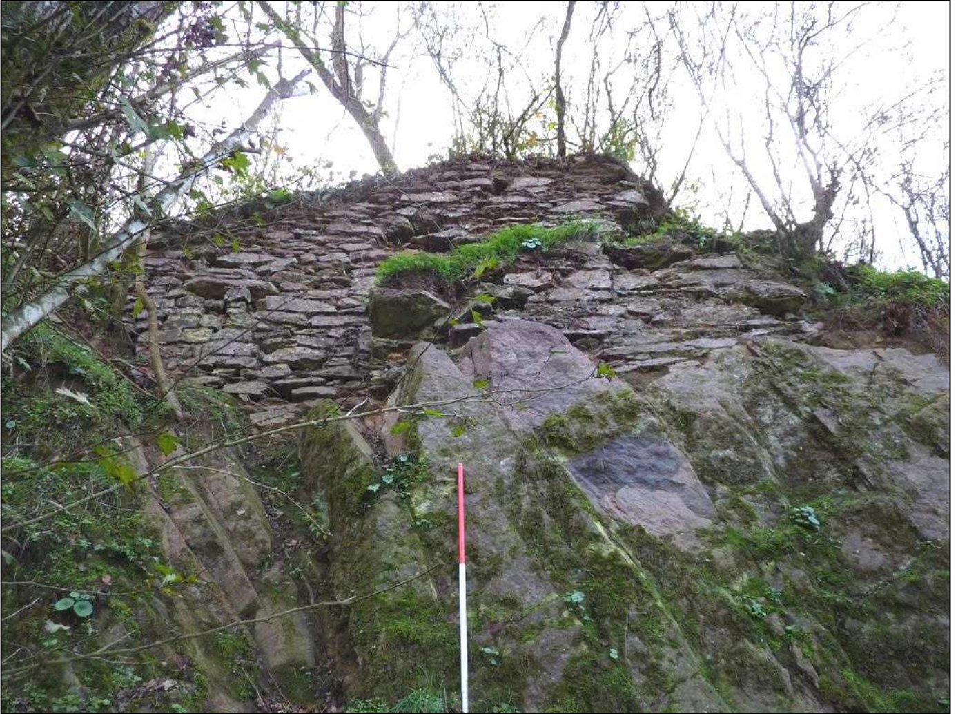
Photo 46 : Mur M 301 et contrefort M 310 construits sur l'affleurement rocheux
