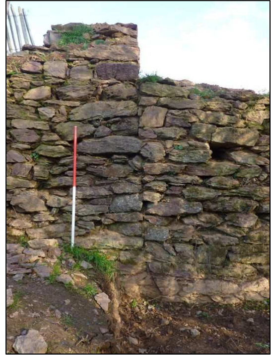
Photo 76 : Détail de la jonction entre les murs M 530 et M 631
