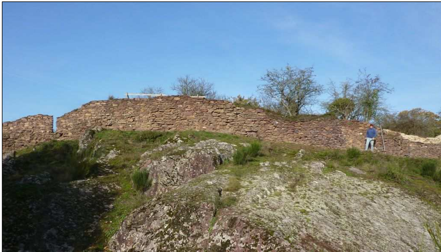
Photo 86 : Parement M 700 (côté est) en partie restauré
