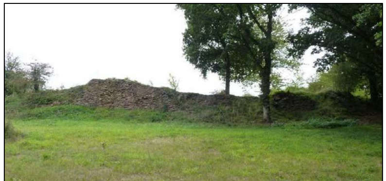
Photo 4 : Vue extérieure de la muraille nord-est
