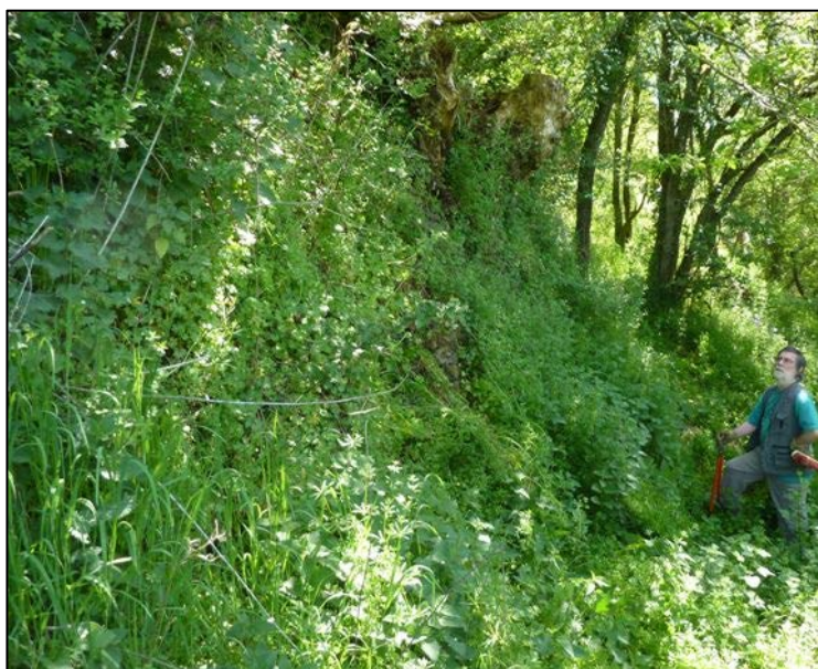
Photo 35 : Etat du mur ouest de la basse-cour avant débroussaillage (M 501)
