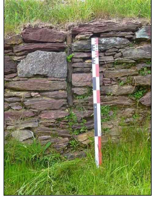
Photo 90 : Archère restaurée UC 7
