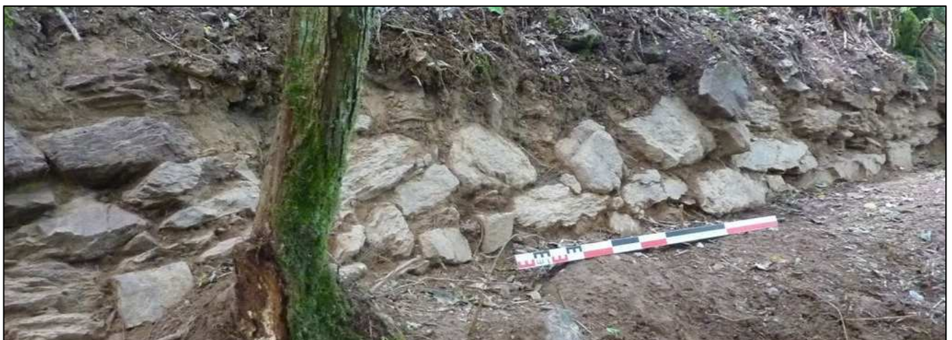
Photo 45 : Parement M 320 partie ouest
