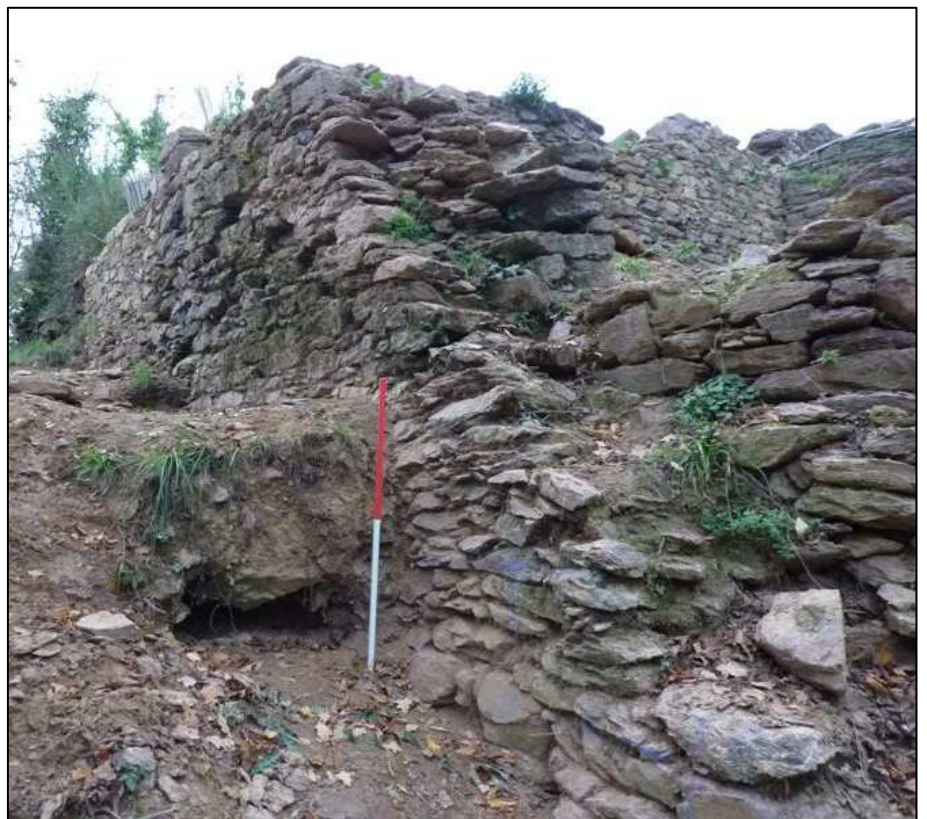
Photo 85 : Mur M 631 vue sud
