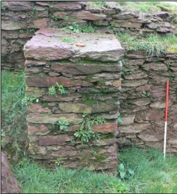
Photo 91 : Contrefort intérieur M 720
