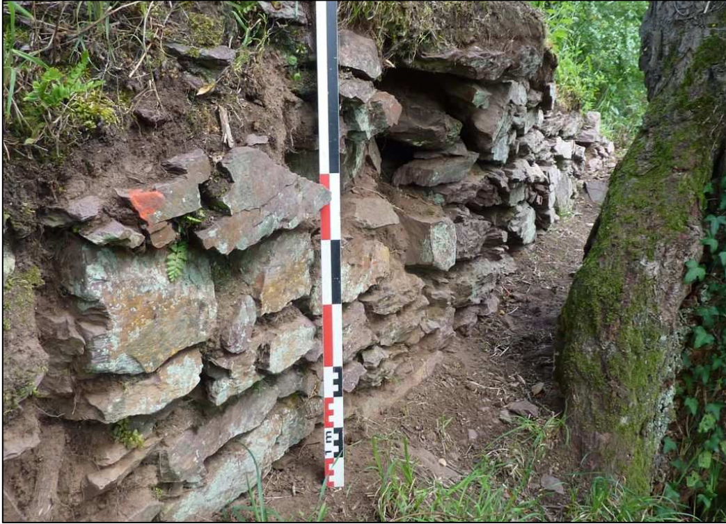
Photo 37 : Parement M 200 vue sud-ouest
