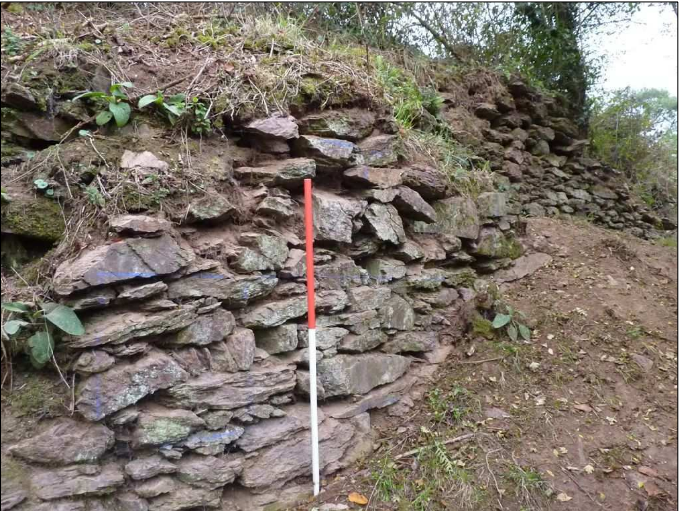
Photo 72 : Contrefort M 520 avec en arrière plan et décalé le mur M530
