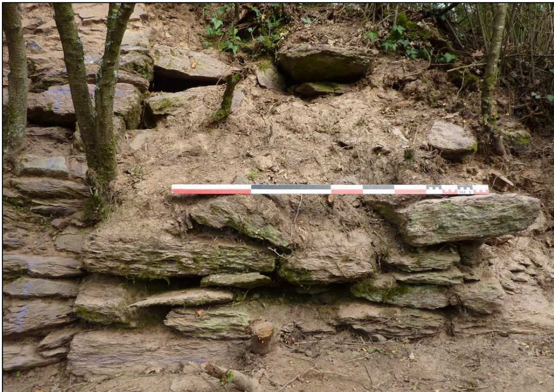
Photo 55 : Détail du probable contrefort M 440
