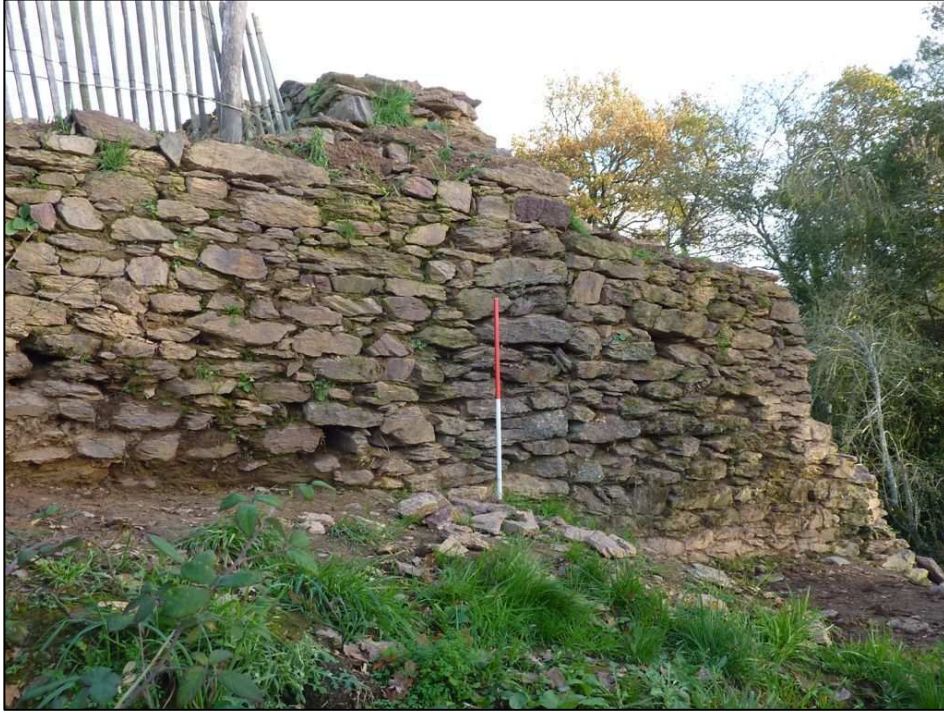
Photo 75 : Parements M 530 partie sud et M 631 partie nord restaurés
