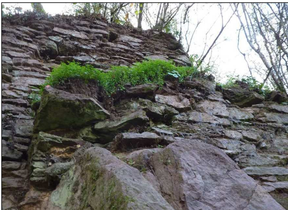
Photo 47 : Contrefort M 310 avec en arrière plan le mur M301
