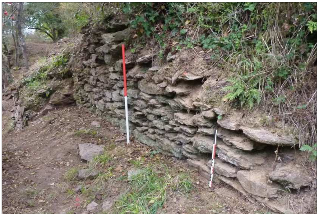
Photo 74 : Parement M 530 partie nord avec en arrière plan le contrefort M 520
