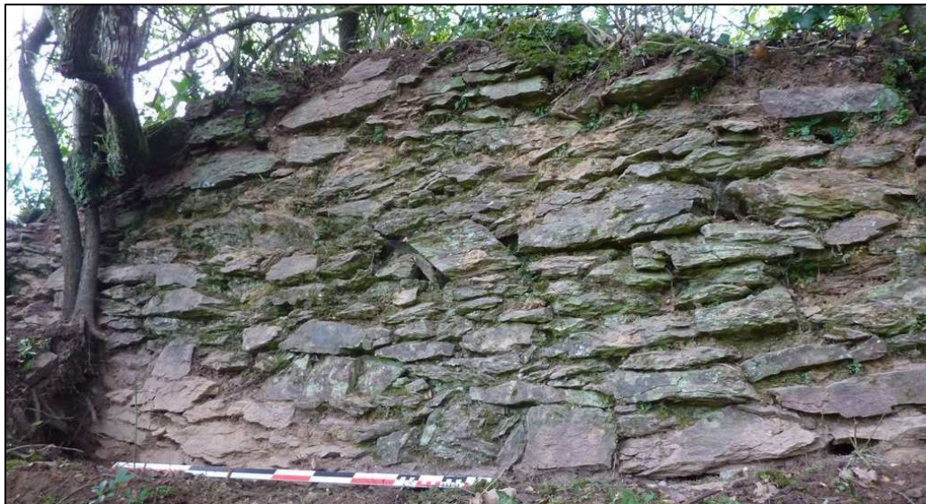
Photo 49 : Parement M 400 partie centrale
