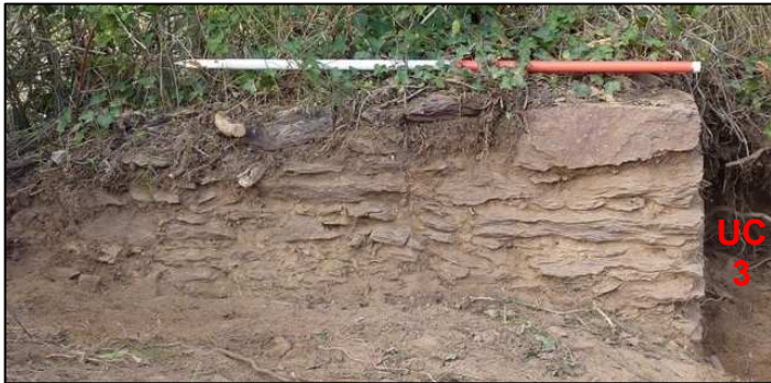
Photo 77 : Mur M 540 en cours de restauration et UC 3
