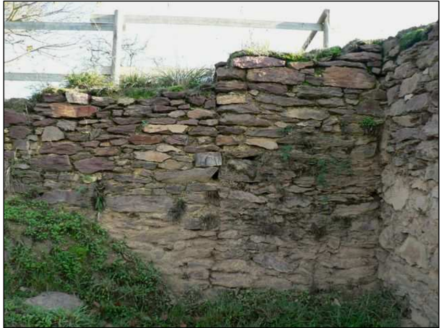
Photo 92 : Contrefort intérieur M 730 et mur accolé M 740
