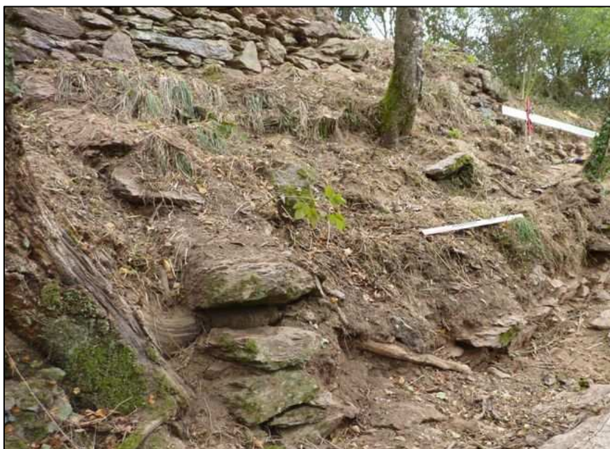
Photo 71 : Contrefort M 510 avec en arrière plan le mur M 503
