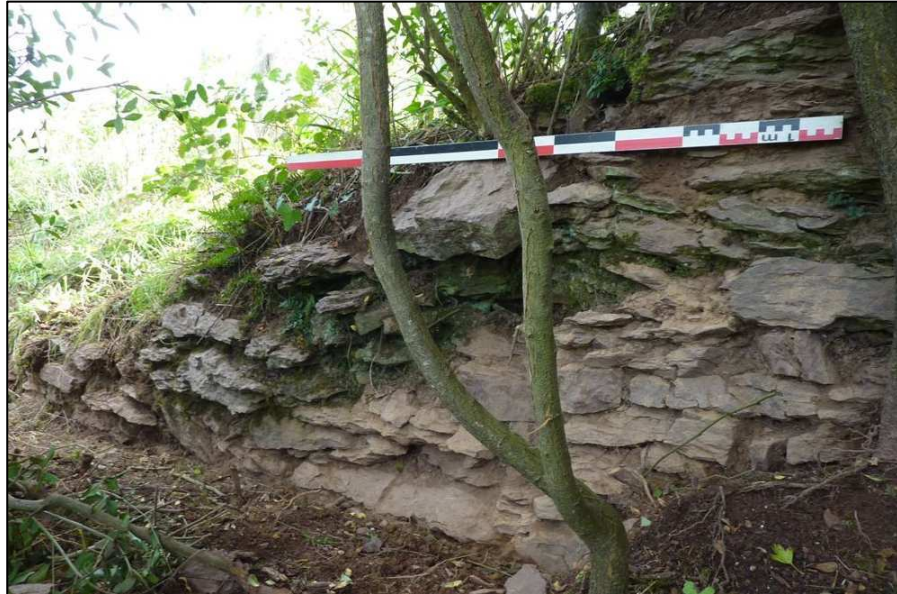
Photo 48 : Parement M 400 partie nord
