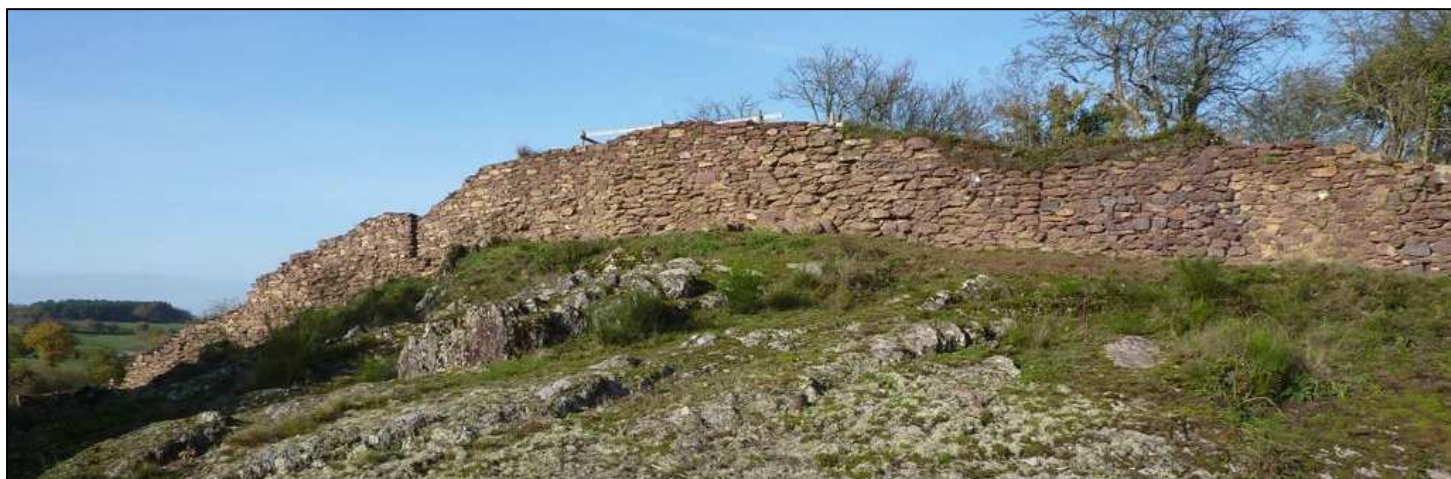
Photo 34 : Etat du mur sud-est de la basse-cour après restauration
