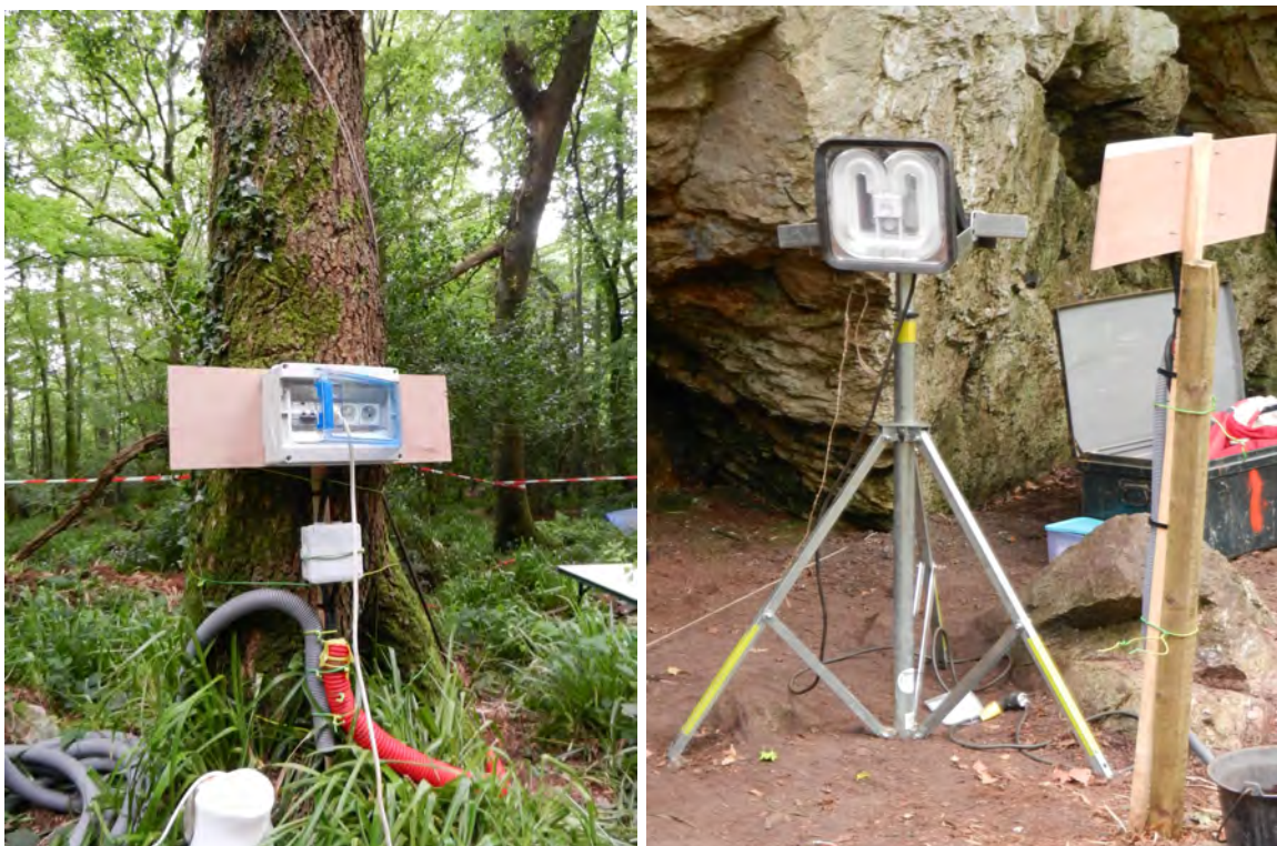
Figure 19. Installation électrique et de l'éclairage sur le site (cliché N. Naudinot)
