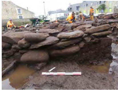
Fig.26 Exemple de parement en blocs d'estran © S. Sicard
