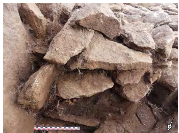
Fig. 196 Vue de détail du chainage du mur nord avec le massif au nord © S. Sicard
