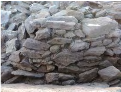
Fig.25 Exemple de parement en petit appareil © E. Pierre
