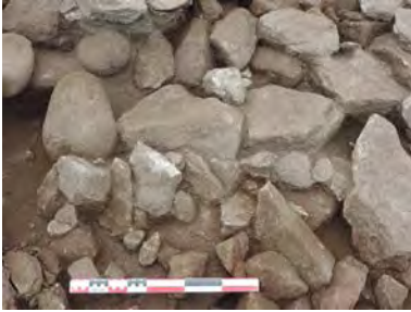
Fig.144 Exemple de petits blocs installés en avant de la base du parement sud
