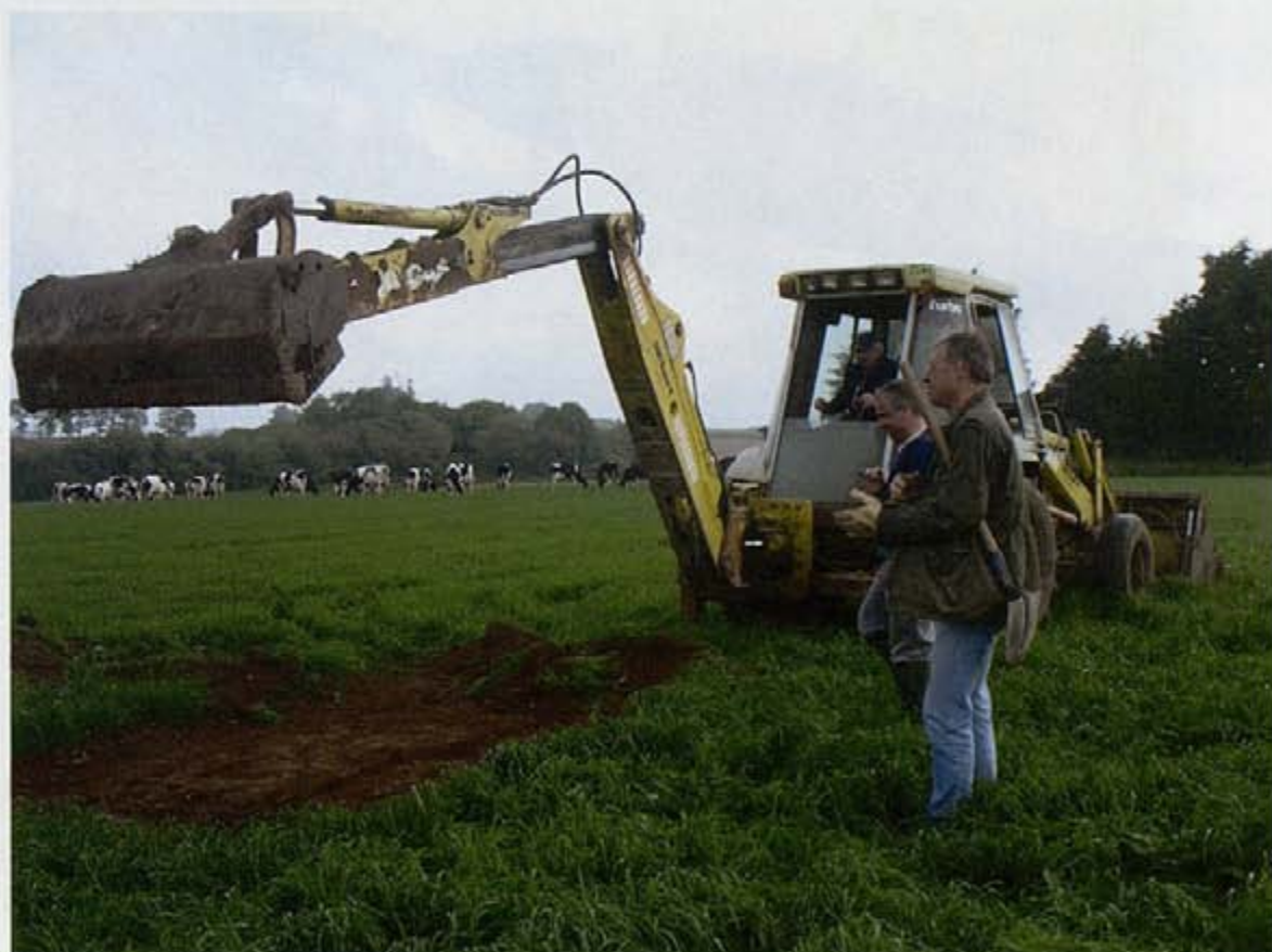
Figure 7. Décapage mécanique (M. Fily)
