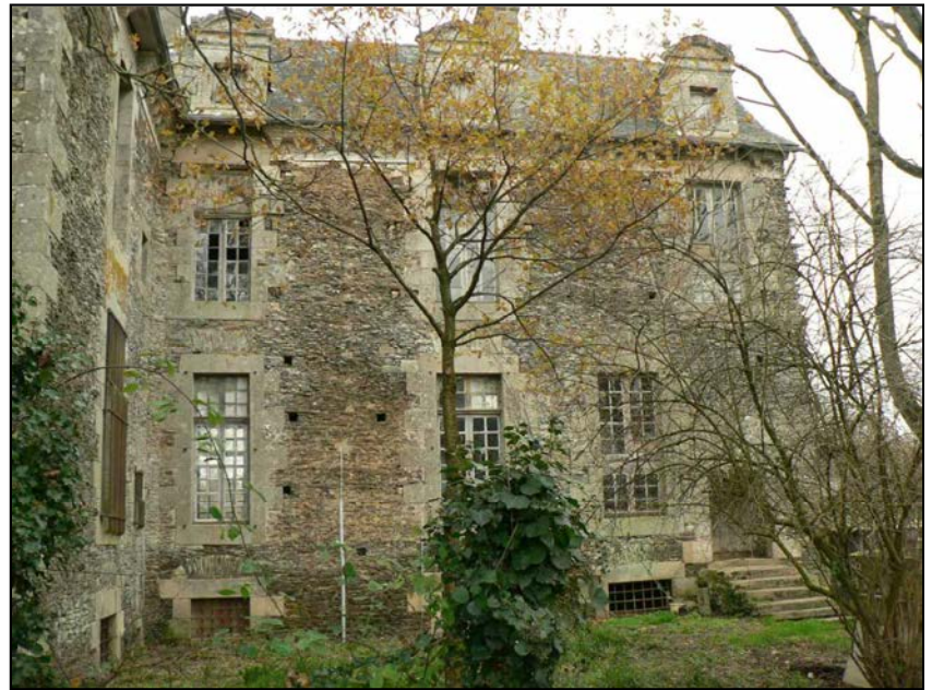
Fig. 34 : Logis élévation ouest
