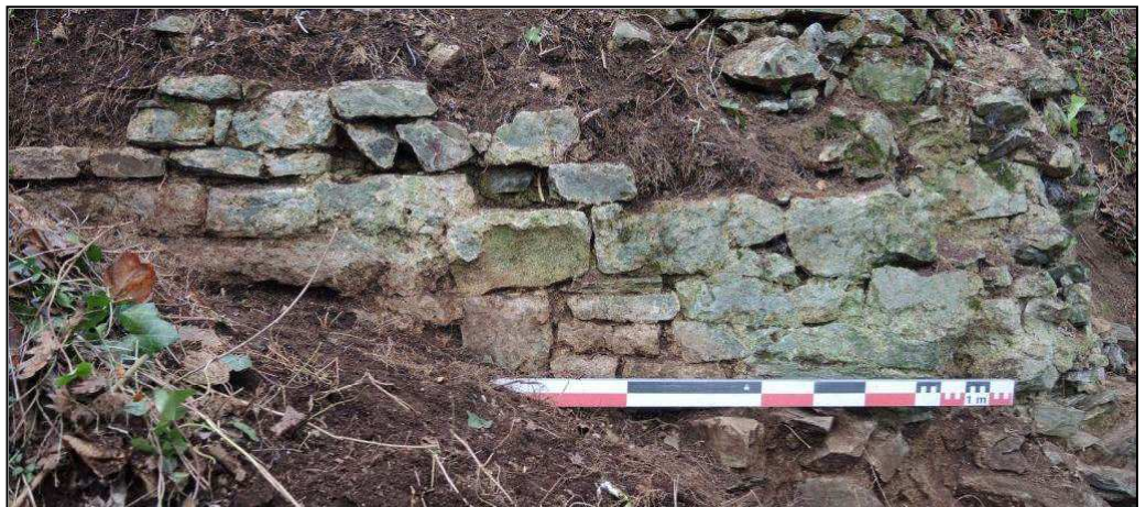
Parement d'une ouverture à ébrasement dans la tour
