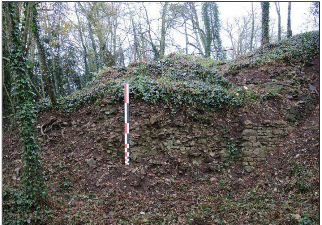
Remplissage et arrachement de la maçonnerie de la tour
