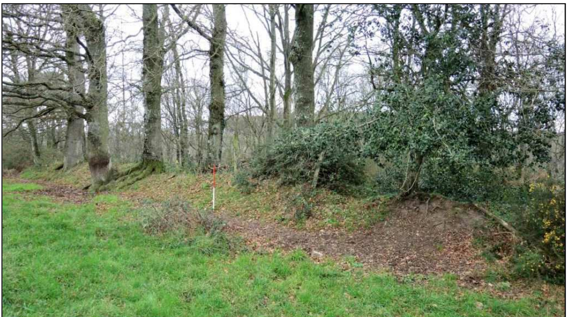
Talus au sud-est
