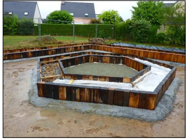
Fig. 44 : vue de la cella avec les entretoises, le géotextile et la semelle en béton
