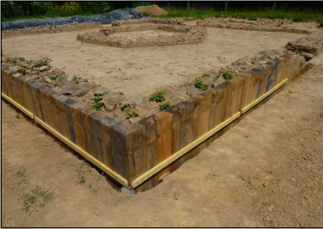
Fig. 43 : angle sud ouest en cours de travaux
