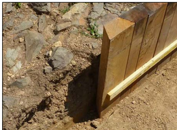
Fig. 42 : vue de l'assemblage des poteaux de chêne
