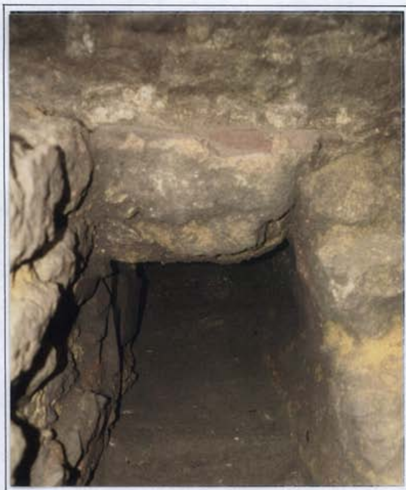
Figure 46 : Le Quiou, l'ancienne gare ; S 23; linteau de soutènement (us 240) du mur 210 édifié sur la canalisation.
