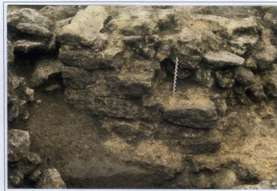
Figure 13 : Le Quiou, l'ancienne gare. Sondage S 11; paroi sud du fossé 108, chaîne d'angle des murs 104/103 conservée sur 5 assises au-dessus de la semelle de fondation débordante.
