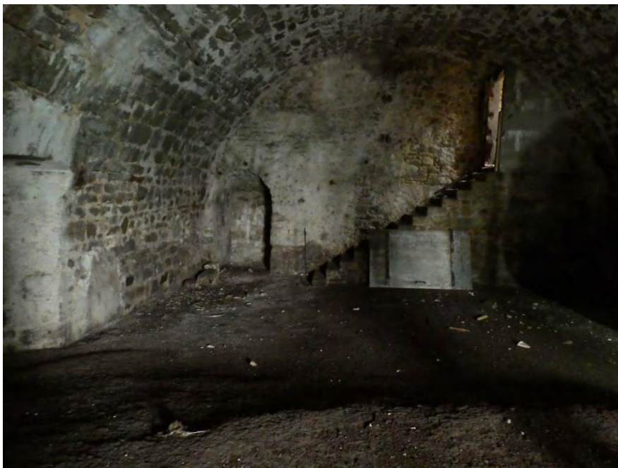
Figure 73 : intérieur de la casemate centrale du bastion des Chambres
