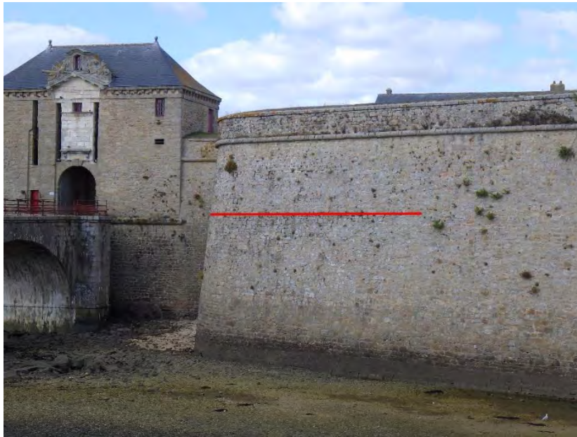
Figure 59 : césure horizontale sur le bastion Desmouriers et entrée principale de la citadelle en arrière-plan
