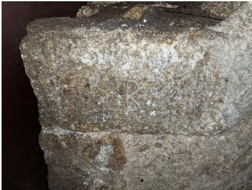
Figure 48 : marque de tâcheron sur le piédroit de la porte primitive
