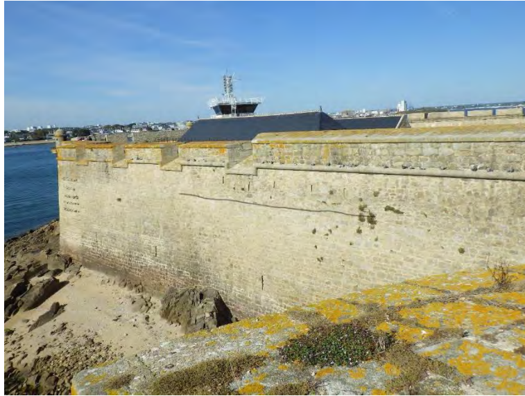
Figure 61 : face sud du bastion Irrégulier (bastion non terminé). Coup de sabre lié au rehaussement visible dans la maçonnerie et marque de harpage du bastion en attente de construction ainsi qu'un massif maçonné visible au centre de la photo (état avant 1620 ?)
