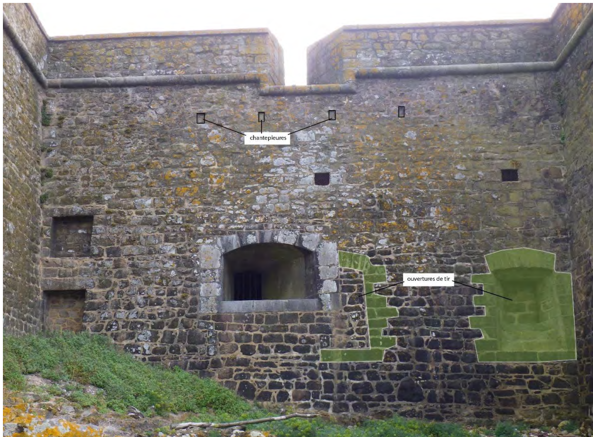
Figure 74 : élévation ouest du flanc du bastion des Chambres
