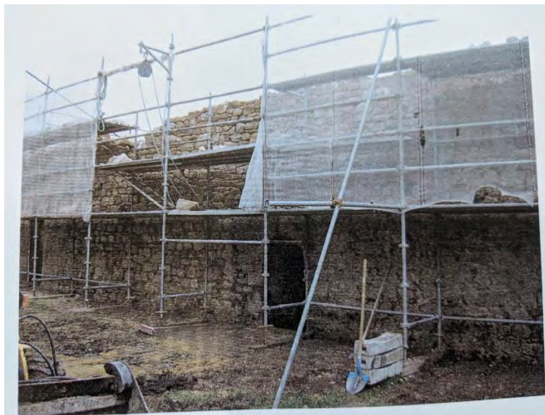
Figure 33 : restauration du « mur des Espagnols », en 2002-3 (LAGNEAU, 2004, p. 25)
