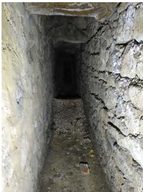
Figure 66 : vue de la gaine entourant le premier magasin à poudre
