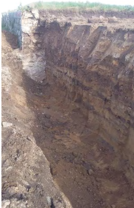
Figure 26 : suivi de travaux du démontage du parapet nord-est, décembre 2020
