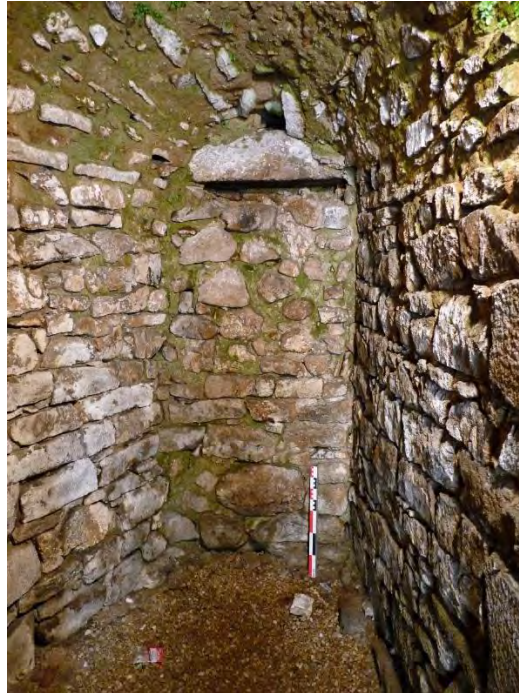
Figure 64 : ouverture de tir murée 33
