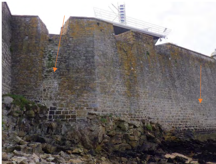
Figure 65 : trois ouvertures de tir bouchées en partie basse du flanc nord du Grand Bastion.
