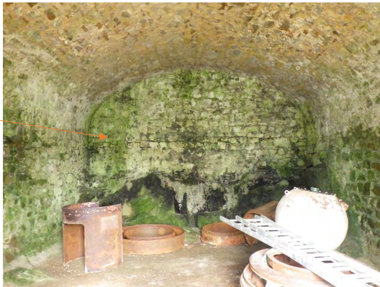
Figure 60 : fond de la casemate de la courtine nord-ouest à proximité du four à pain. La voûte est postérieure au mur, elle s'appuie contre celui-ci, qui a été surélevé d'environ 3m selon le coup de sabre horizontal visible sur la maçonnerie.
