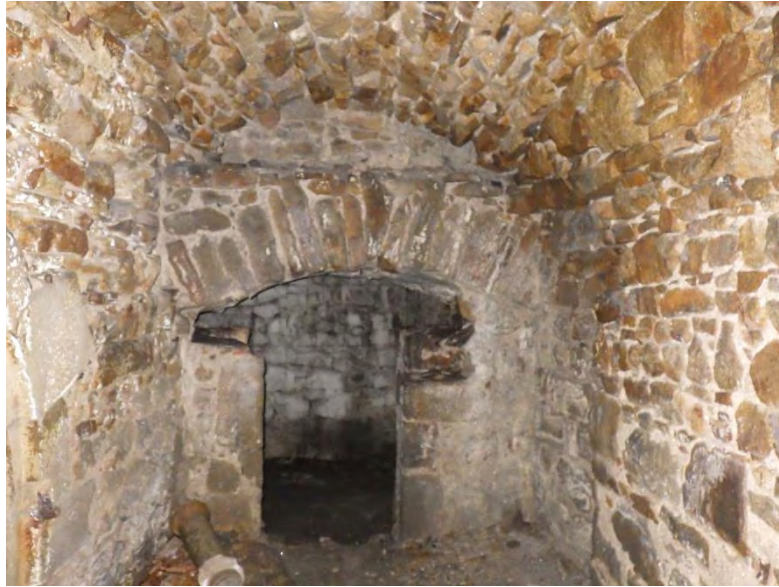
Figure 47 : porte primitive du souterrain du bastion de la Brèche.
