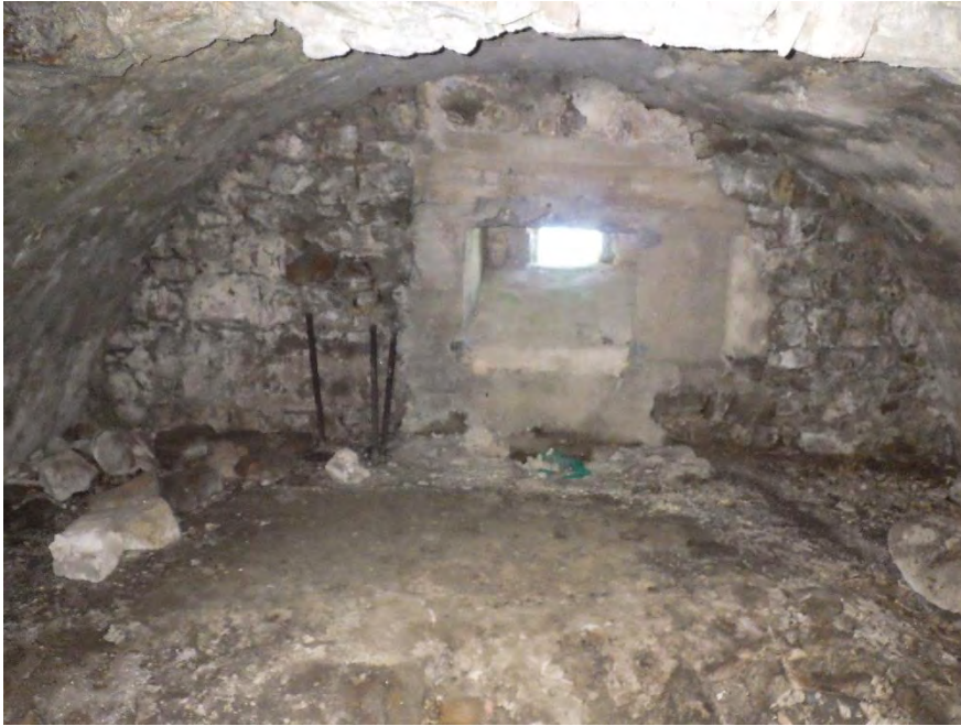
Figure 75 : casemate 1 démurée, bastion de la Brèche
