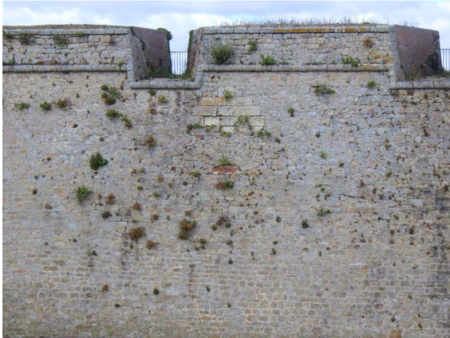
Figure 34 : vue du blason du bastion Desmouriers depuis l'enfilade de la demi-lune, avant intervention de restauration
