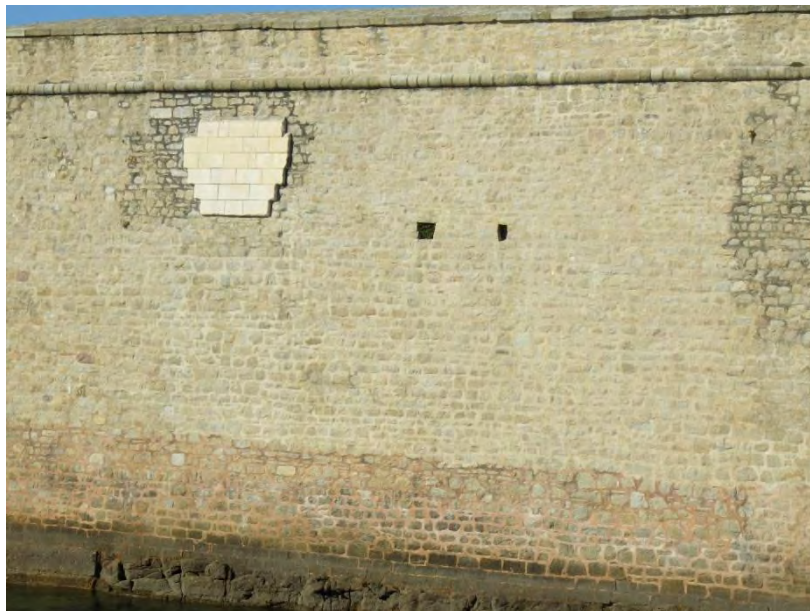
Figure 37: emplacement du "blason" restauré du bastion de Groix
