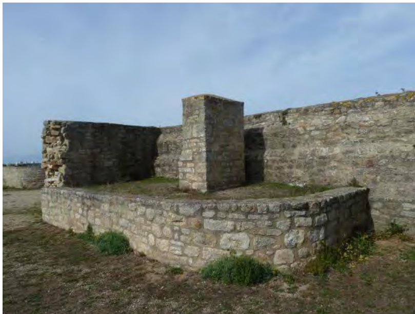
Figure 71 : Abri à munitions privé de sa couverture terrassée, bastion des Chambres (ca 1880).
