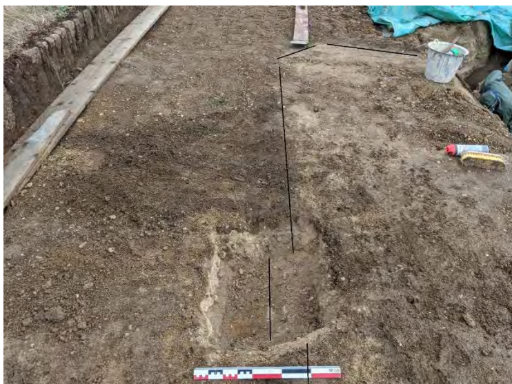
Figure 23: sondage 5, fouille en plan sur le sommet du parapet
