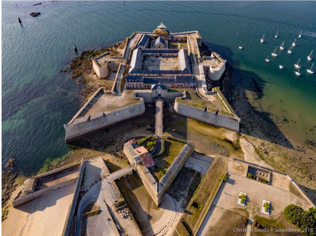
Figure 50 : l'allongement du bastion de Groix lui permet de couvrir le fossé de la demi-lune construite après 1636 (Crédit : Christian Baudu, 2018).
