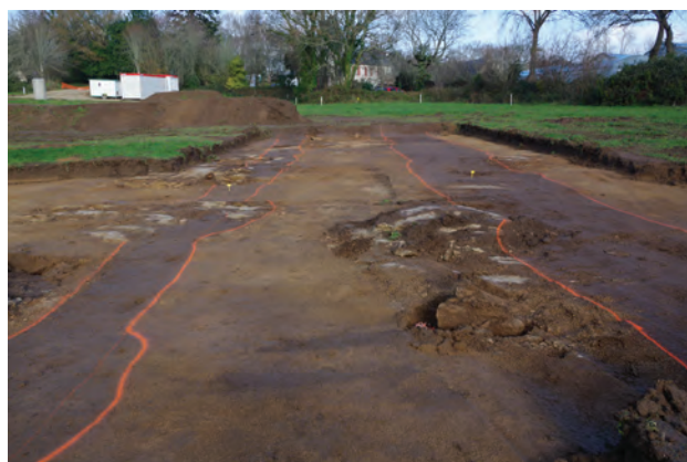
figure 26: Vue d'ensemble depuis le sud des fossés FO 1039-FO1041 (M. Lemée CDA 29)
