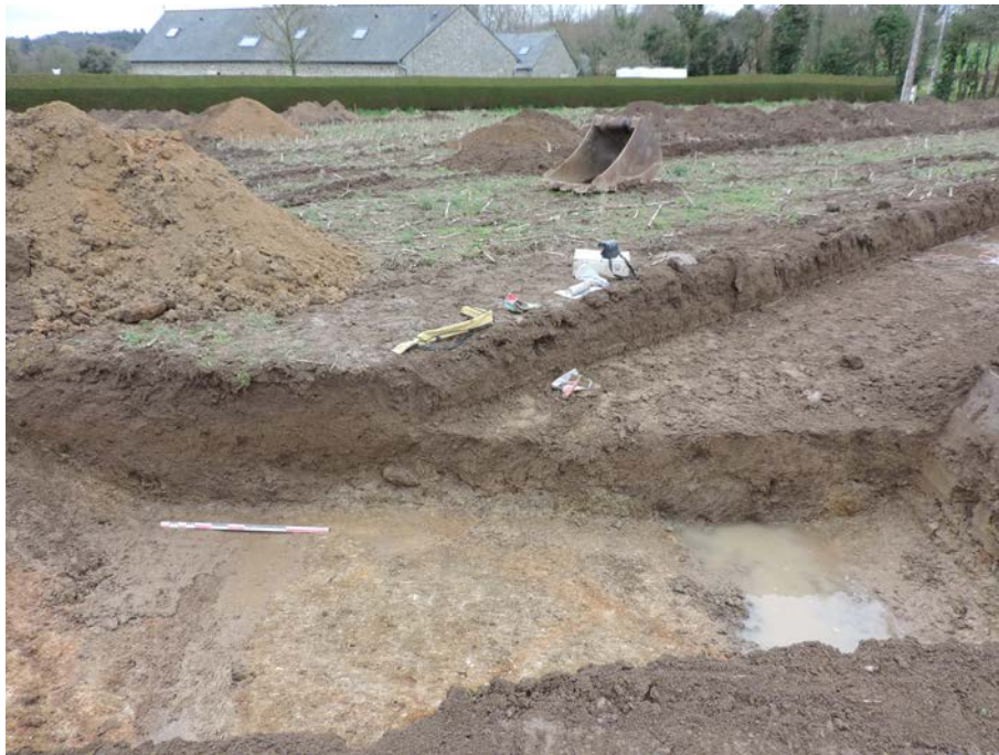
Fig. 24 Vue de la coupe NNE/SSO réalisée sur la moitié nord de F1 dans la tranchée 9 © Inrap
