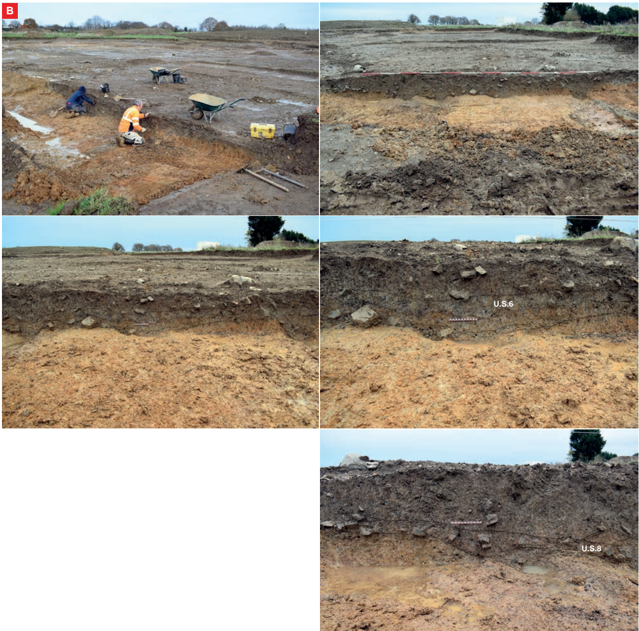
Fig. 67b L'exécution de la coupe 3 sur la voie, de sa vue d'ensemble et de ses niveaux de circulation . © G. Leroux, Inrap
