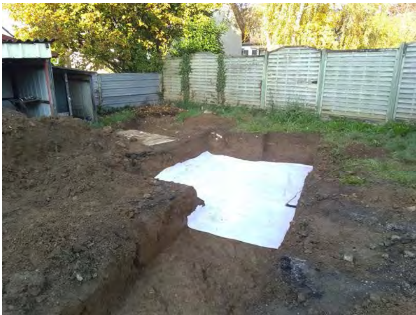
Vue de la protection en géotextile posée sur l'empierrement F.2 au nord de la tranchée 2 © Inrap.
