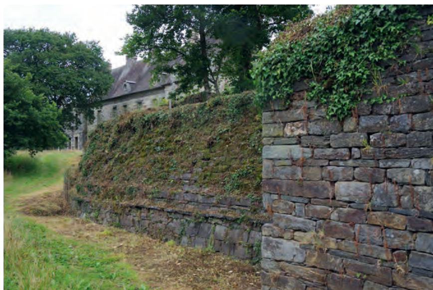
Illustration 37 : Vue du soubassement et de la tourelle des latrines du bâtiment B2 du complexe architectural sud-est, vue depuis le sud-est (Cl. J.-B. Vincent).
