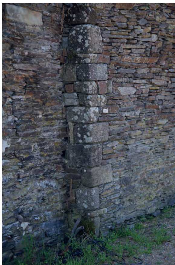
Illustration 23 : Détail du chaînage et du ressaut entre les parements Usc 1004 et 1002, vue depuis l'est (Cl. J.-B. Vincent).
