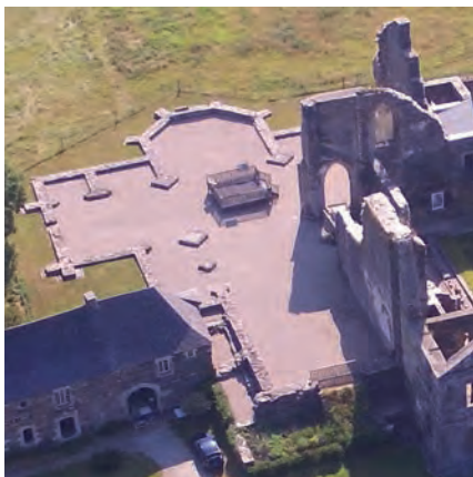
Illustration 20 : Vue aérienne depuis le nord-ouest de l'abbatiale (Cl. R. Péron).
