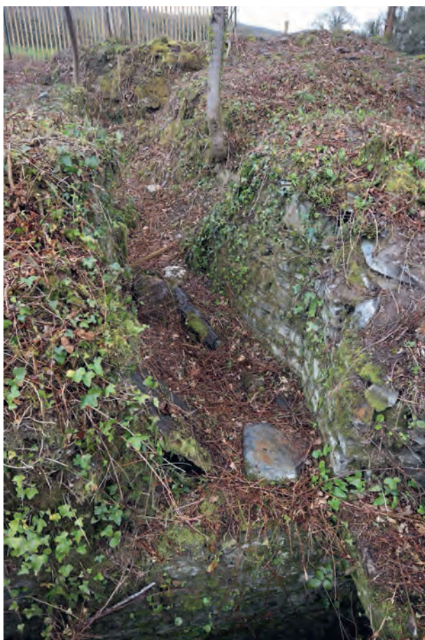
Illustration 52 : Couloir d'accès aux latrines, vues depuis l'intérieur de la tour des latrines (Cl. J.-B. Vincent).
