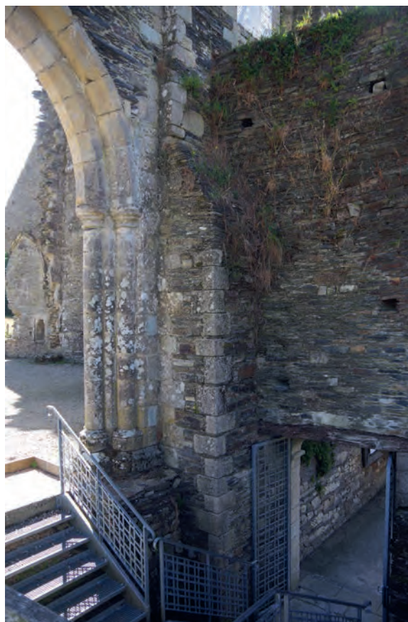
Illustration 29 : Vue depuis le nord-ouest du pilier du bas-côté de la nef (jonction avec le bras sud du transept) et le vestige du gouttereau originel du bas-côté sud de la nef transformé en contrefort au XVIII e siècle (Cl. J.-B. Vincent).
