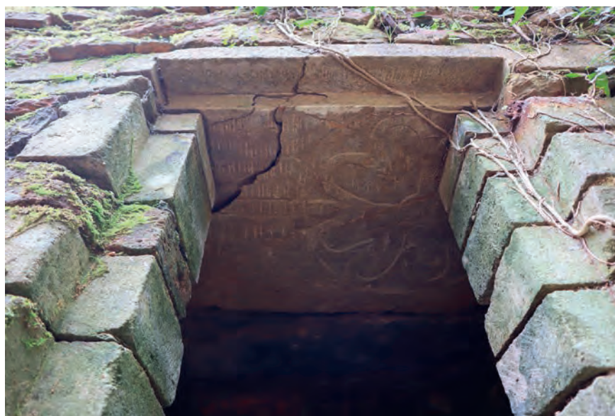
Illustration 42 : Détail d’une pierre tombale décorée d’un motif floral et réemployée en linteau pour le placard de la salle B1-a (Cl. J.-B. Vincent).
