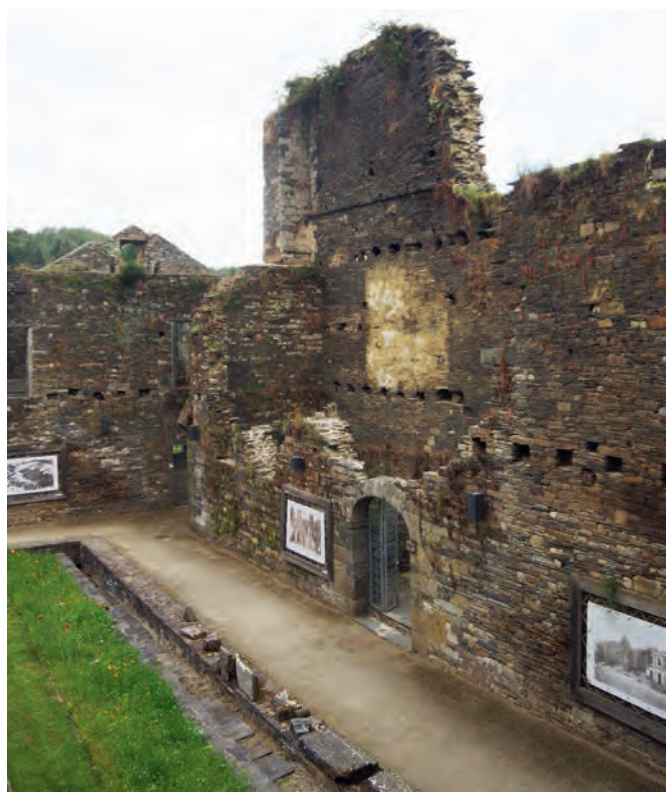
Illustration 24 : Vue depuis l'étage de la galerie orientale du cloître des vestiges du bâtiment longeant le gouttereau sud de la nef (Cl. J.-B. Vincent).
