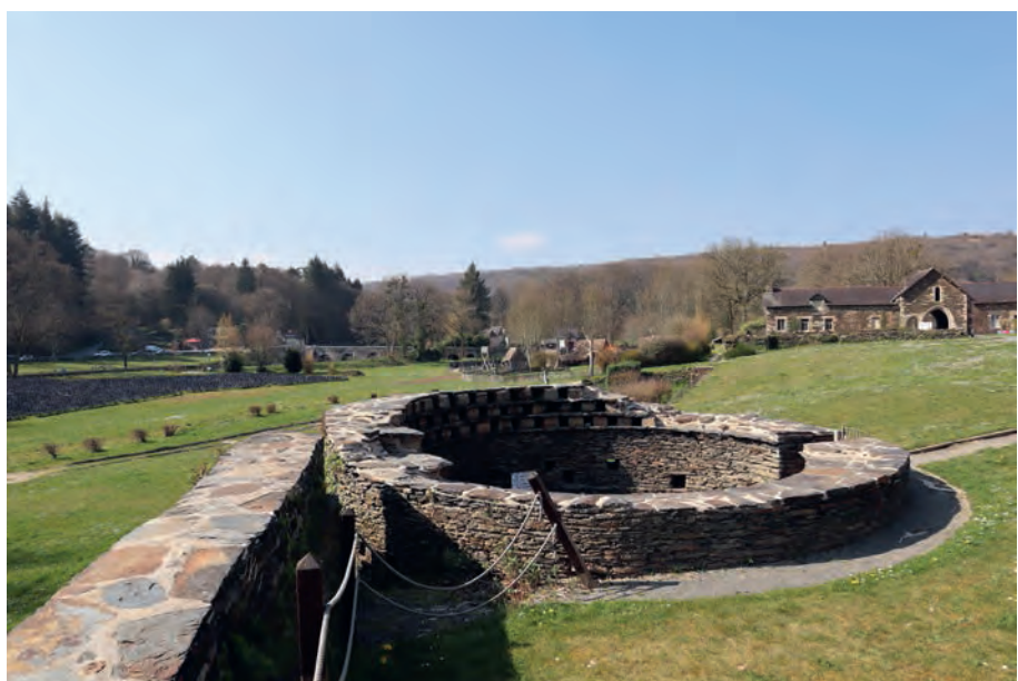
Illustration 67 : Vue d'ensemble du pigeonnier situé au sud-ouest de l'aile occidentale (Cl. J.B. Vincent).
