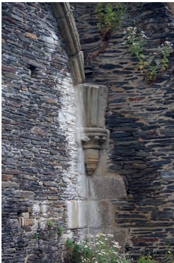
Illustration 34 : Détail du culot (angle orientale) du voûtement du dortoir médiéval (Cl. J.-B. Vincent).
