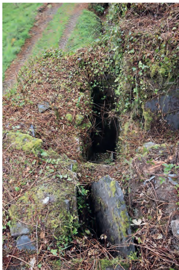
Illustration 53 : Détail des conduits des latrines depuis le sommet de la tour. Vue depuis l'est (Cl. J.-B. Vincent).
