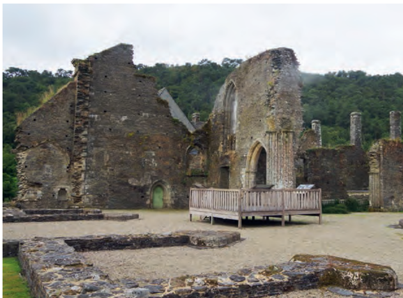
Illustration 25 : Vue d'ensemble des vestiges du croisillon sud du transept avec, au premier plan, l'arase du collatéral oriental du bras nord du transept et celui du chœur (Cl. J.-B. Vincent).
