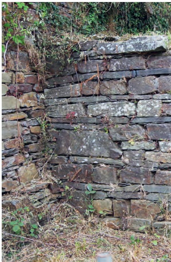
Illustration 54 : Connexion structurelle entre B1 et B2. Le pignon ouest de B2 est collé contre le pignon sud de B1 (Cl. J.-B. Vincent).
