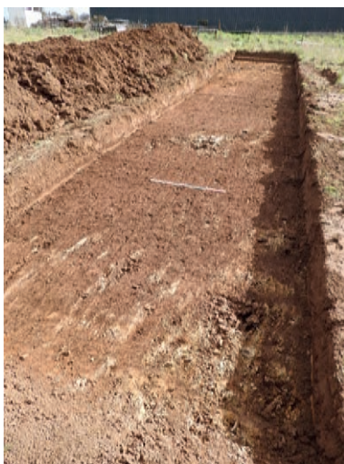
Fig.6 Aspect du substrat en surface de décapage, dans la tranchée 5 (© prise de vue A.-L. Hamon, Inrap)
