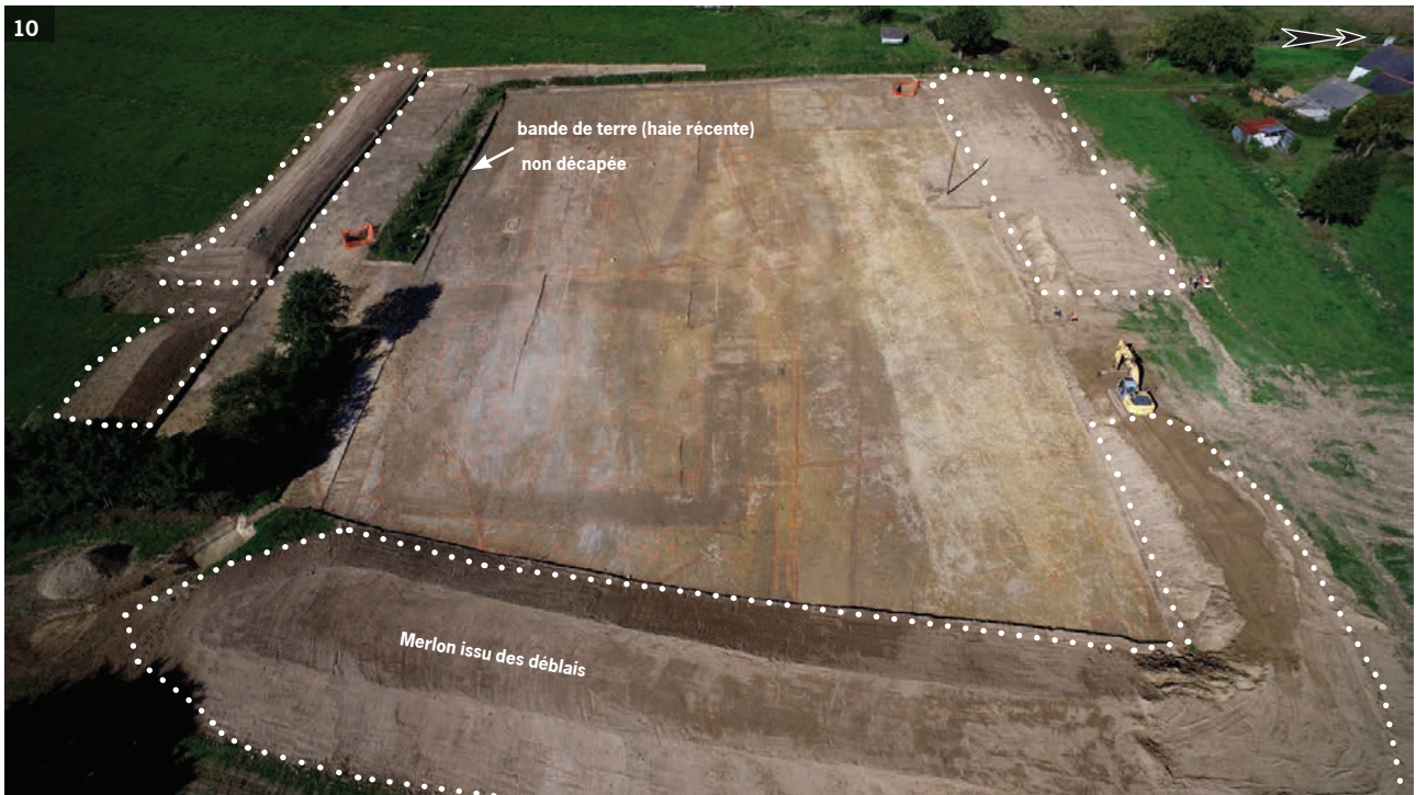
Fig. 10 Vue de l'emprise de la fouille, vue aérienne vers le nord. Situation des zones de stockage des terres décapées (merlon en pointillé blanc) et de la bande de terre non décapée © Askel Drone Prod, 2015
