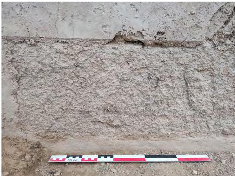
**Figure 25:** Traces de faux joints au pied du mur 1 (nord), surlignant un bloc de granit (R. Louessard)
