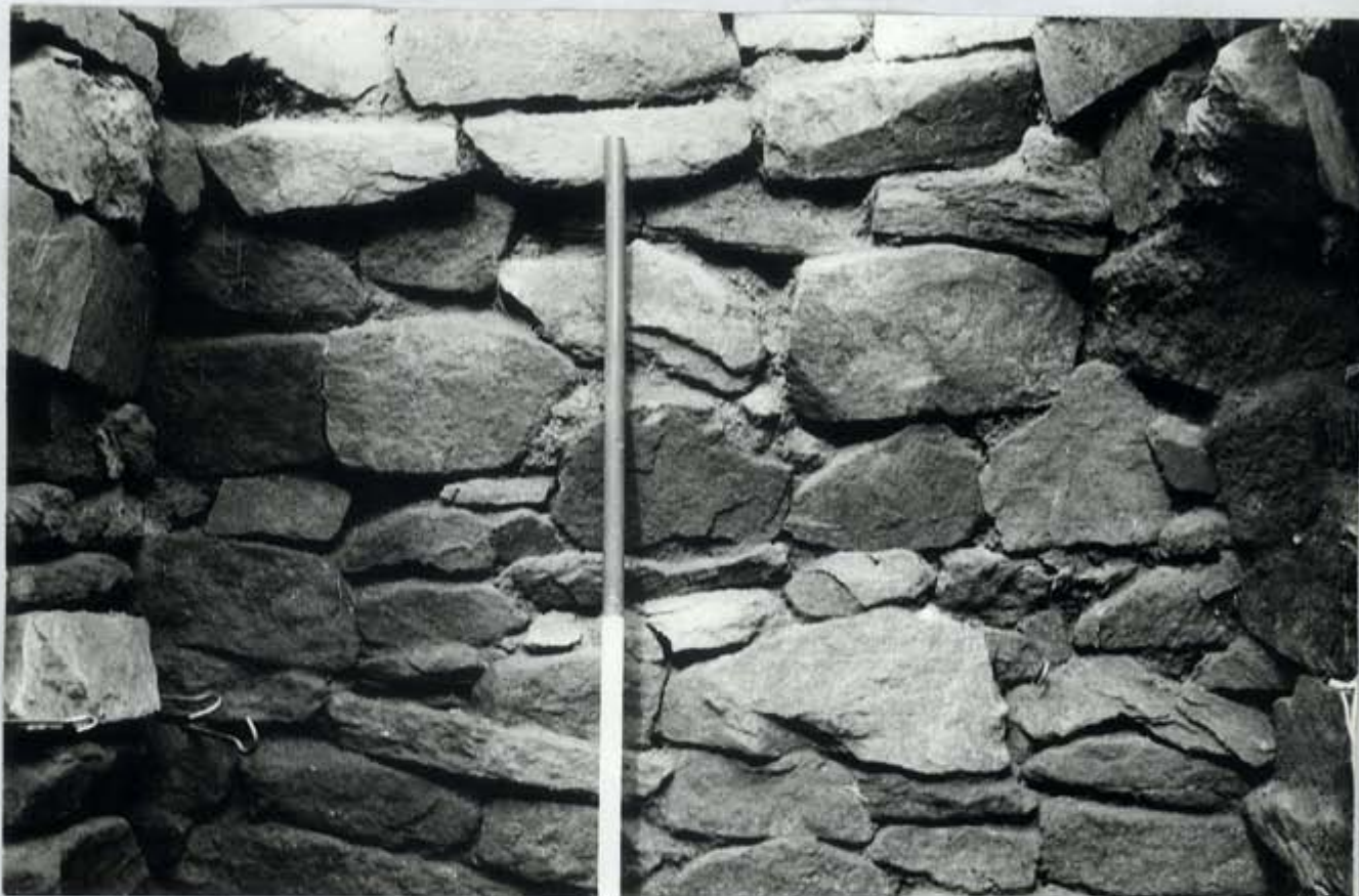
Fig. 7 - Détail du mur en pierre sèche. Paroi Nord-Ouest.
