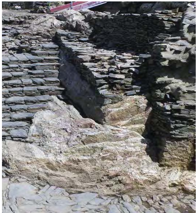
Fig. 19 : Détail du socle de quartzite taillé sous le mur M 2412, et de la rigole US 2421, qui longe cette semelle rocheuse. Vue de l'ouest. Cl. R. Pérennec, CD 29/ Mission archéologie.
