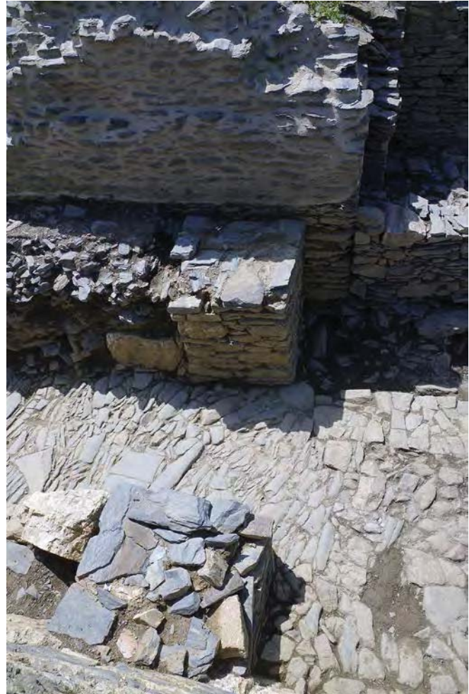
Fig. 66 : Piliers quadrangulaires M 2666, réduisant le passage du sas de la porterie. Vue de l'est. Cl. R. Pérennec, CD 29/ Mission archéologie.
