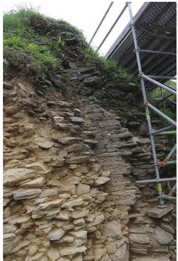
Fig. 80 : Mur M 2415, vu de l'ouest. Cl. R. Pérennec, CD 29/ Mission archéologie.
