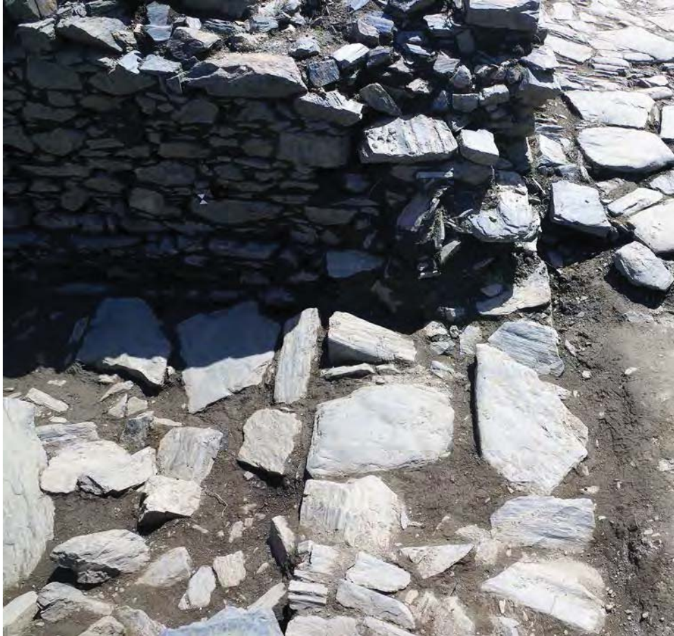
Fig. 17 : Mur M 2717 arasé, et vestiges du dallage US 2720 (à gauche). A l'arrière-plan, mur M 2528 et retraits d'aplombs US 2718 et US 2719. Vue du nord. Cl. R. Pérennec, CD29/ Mission archéologie.
