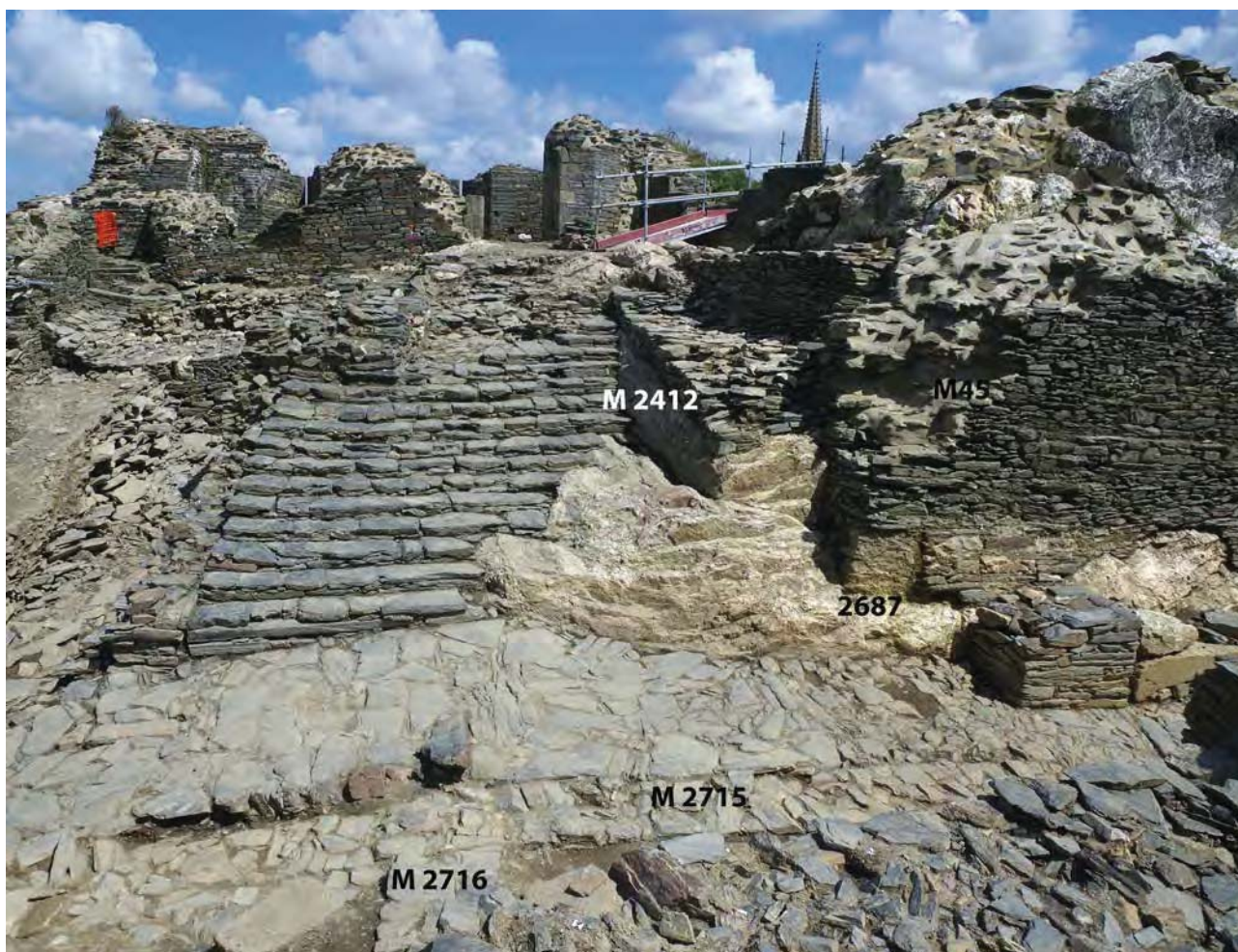
Fig. 55 : Vue sur la partie est de l'enceinte, depuis l'ouest.
