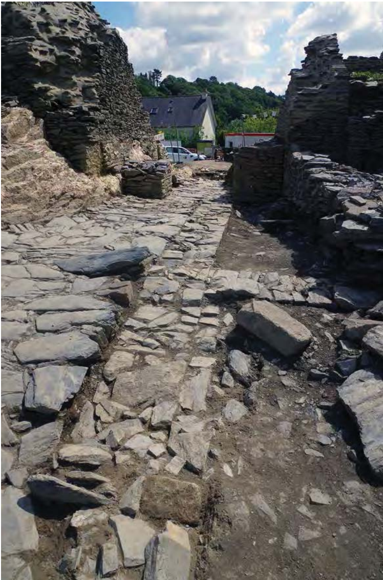
Fig. 54 : Parement US 2686 accolé au parement ouest du mur M 2715 ; mur M 2716 et dallage US 2710. Vue du nord. Cl. R. Pérennec, CD 29/ Mission archéologie.
